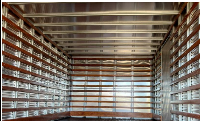
Ripamento interno em madeira de lei
