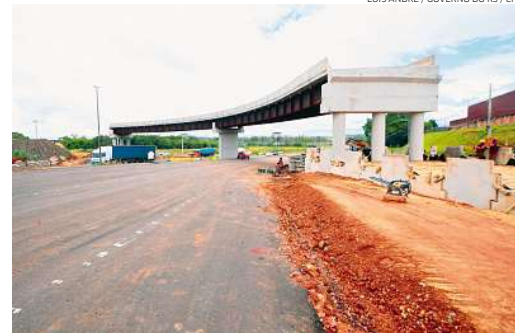
Elevada em Gravataí já foi liberada para o trânsito
