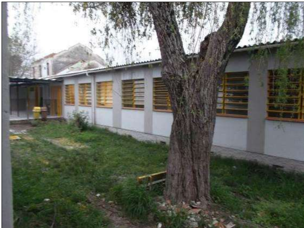
Figura 09– Bloco 02 / Elevação Norte
