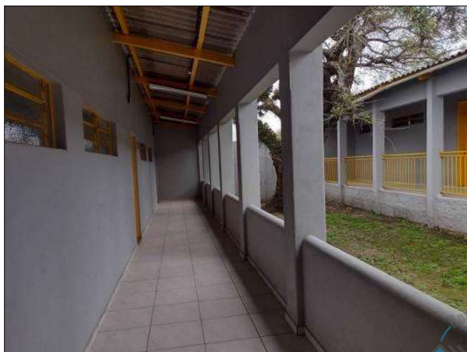
Figura 39 - Bloco 02 / Circulação – piso
