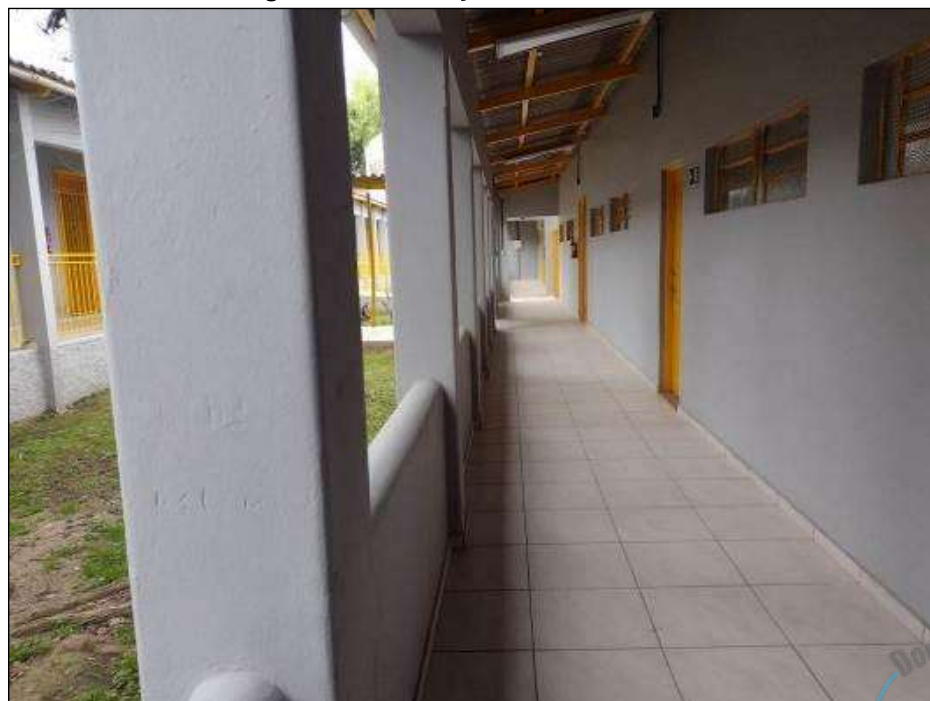
Figura 90– Circulação interna / Bloco 03
