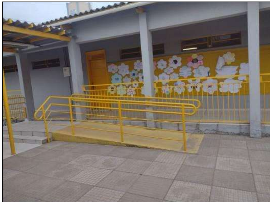
Figura 56 - Rampa de acesso Bloco 01
