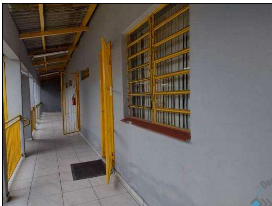
Figura 88 – Circulação interna / Bloco 02
