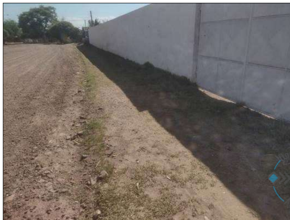
Figura 103 – Acesso de veículos
