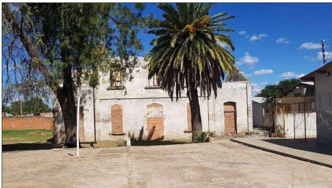
Figura 23– Ruínas Estação Ferroviária / Elevação Norte
