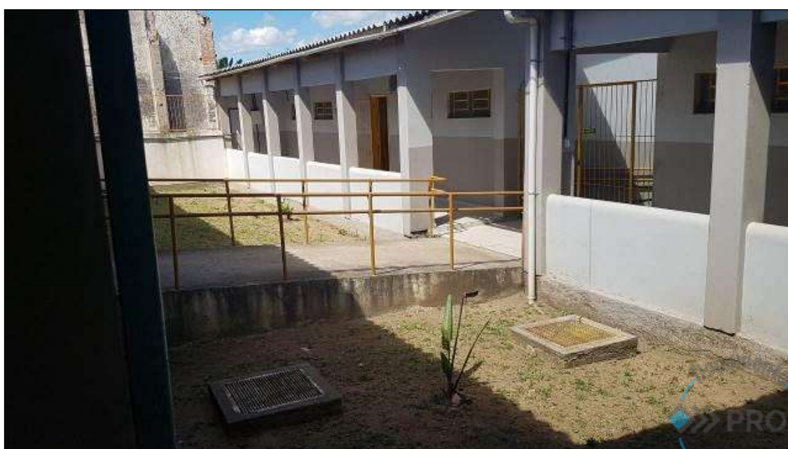
Figura 16 – Bloco 03 / Elevação Norte
