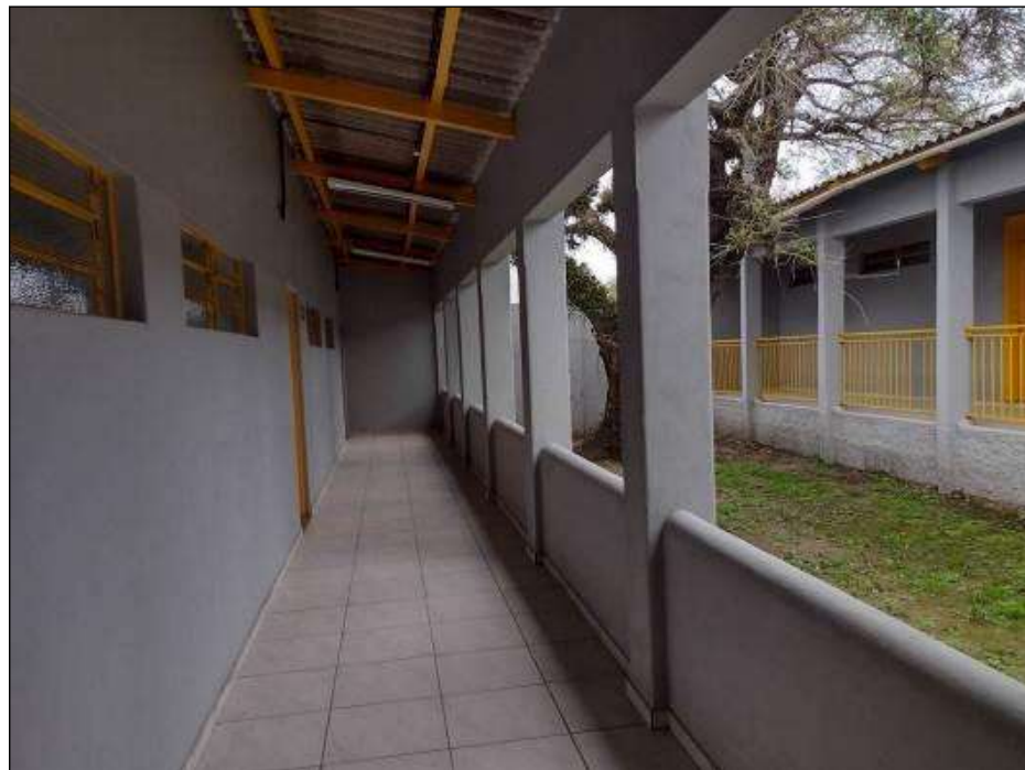
Figura 89– Circulação interna / Bloco 03
