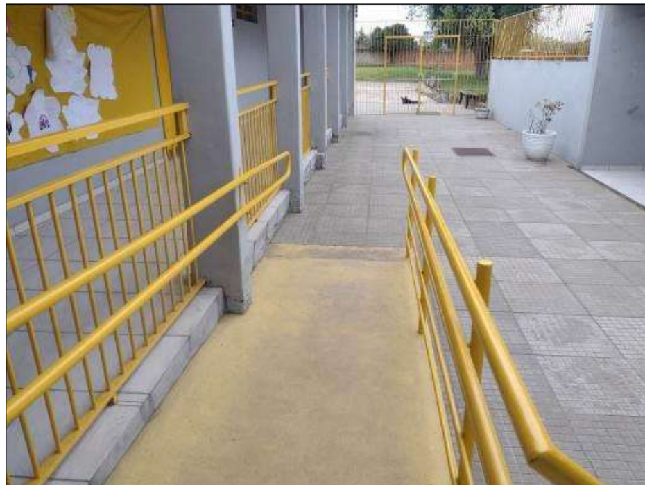
Figura 58 - Rampa de acesso Bloco 01
