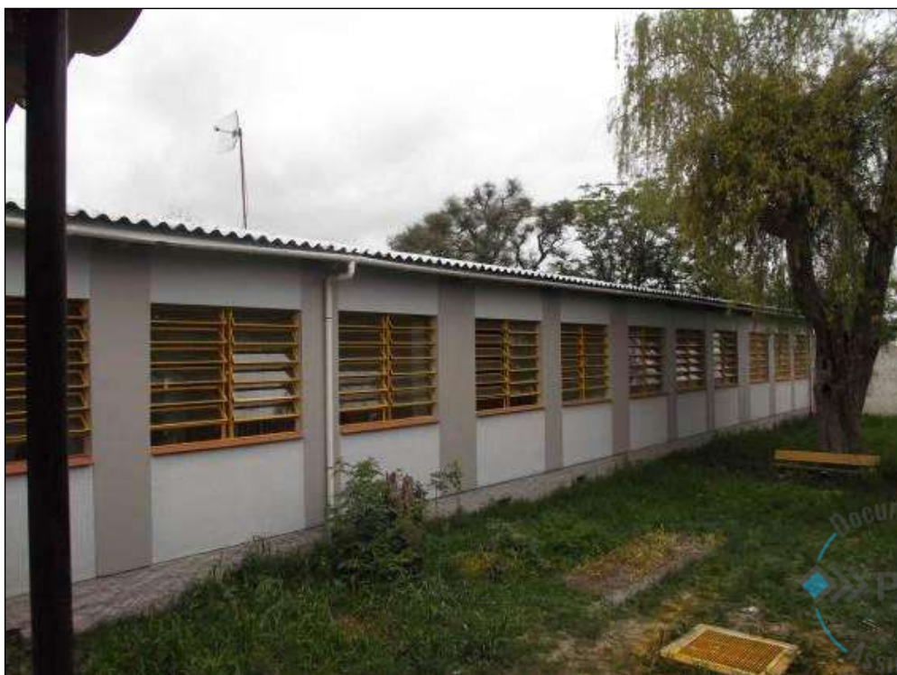
Figura 10– Bloco 02 / Elevação Norte
