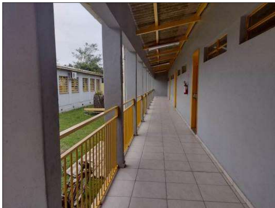
Figura 34 – Bloco 01 / Circulação – piso
