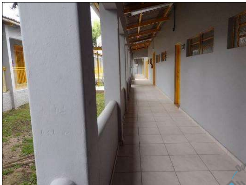
Figura 41 - Bloco 03 / Circulação – piso
