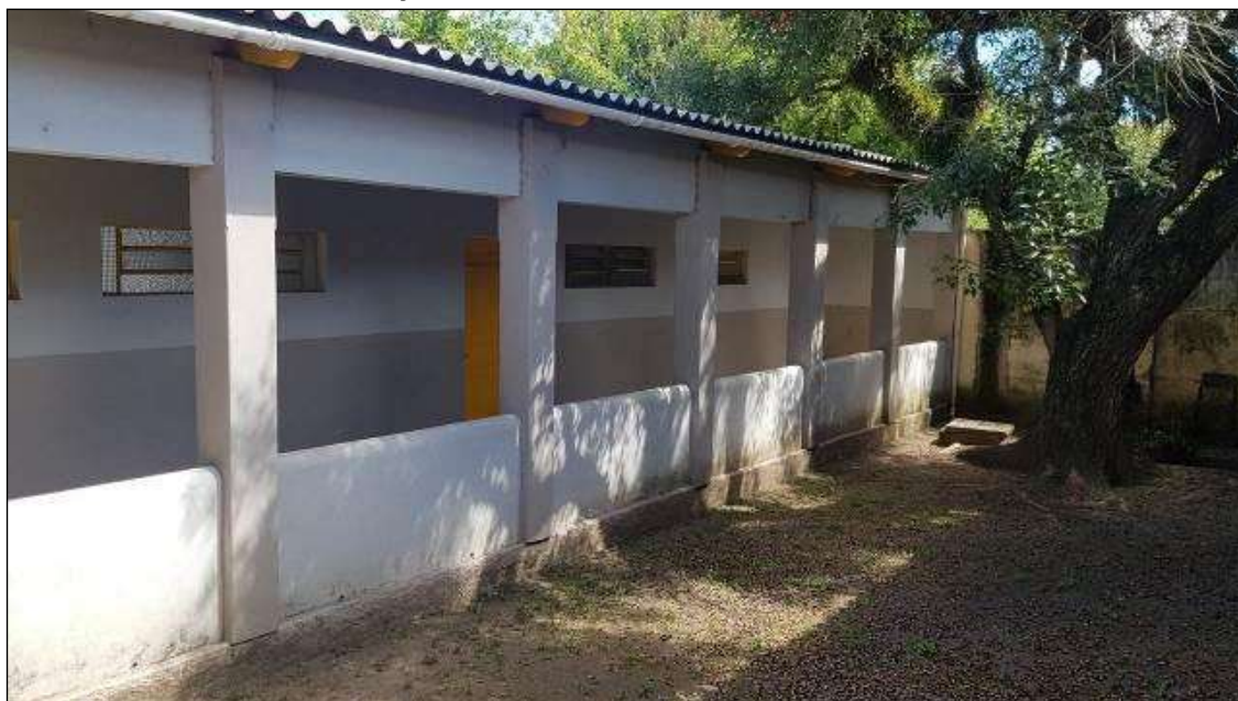
Figura 15 – Bloco 03 / Elevação Norte
