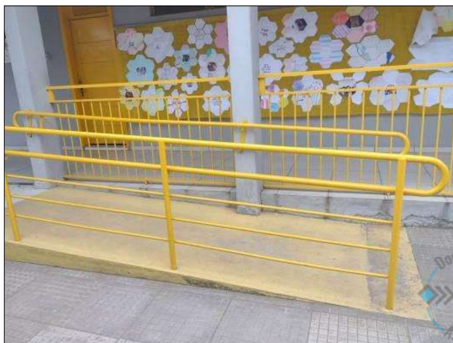
Figura 55 - Rampa de acesso Bloco 01
