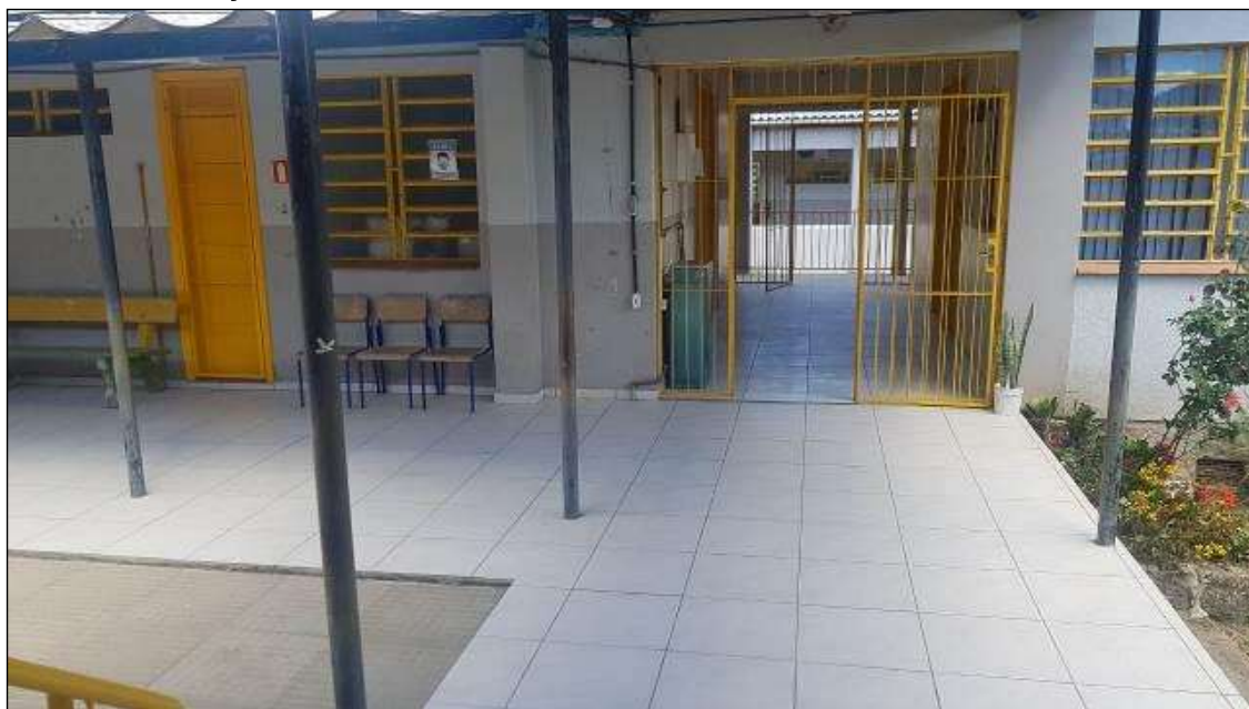
Figura 07– Bloco 02 / Elevação Norte
