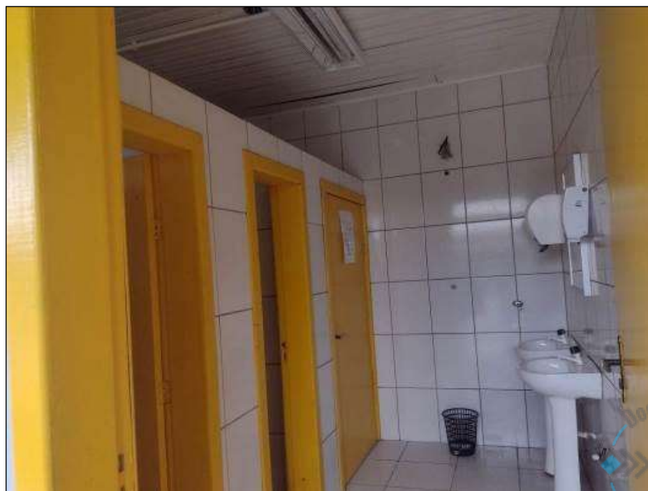
Figura 109- Bloco 02 / Sanitário feminino
