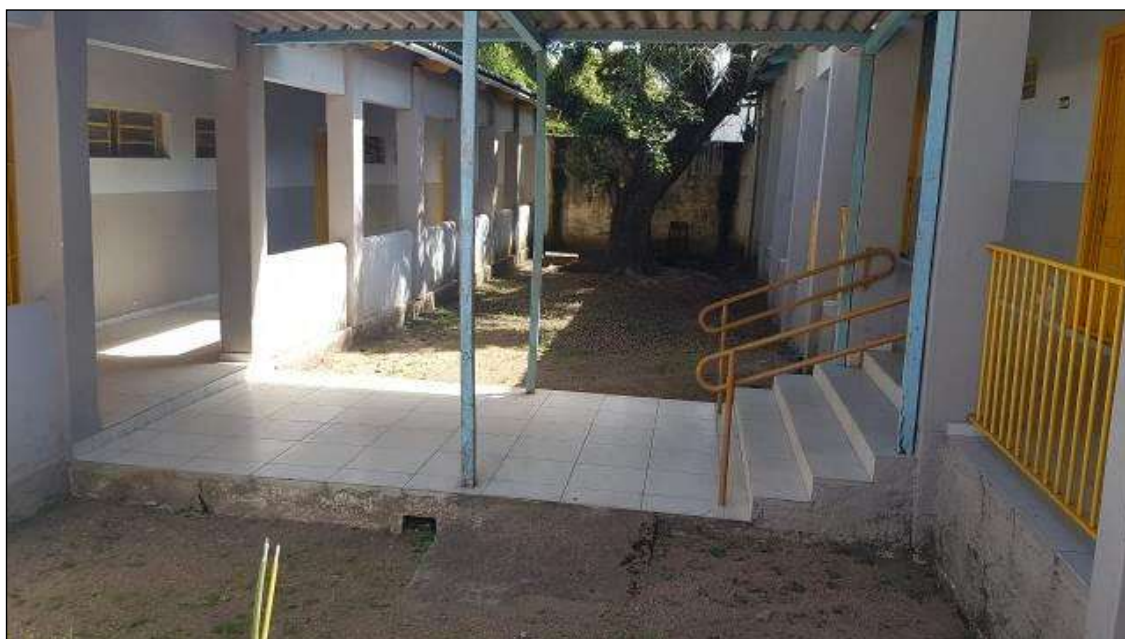
Figura 18– Bloco 03 / Elevação Norte
