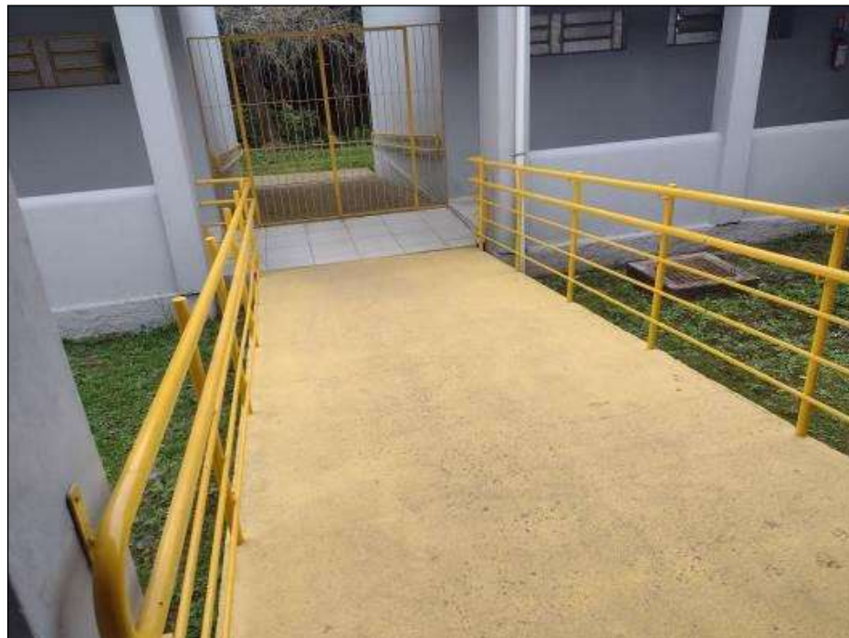
Figura 62– Rampa de acesso Bloco 03
