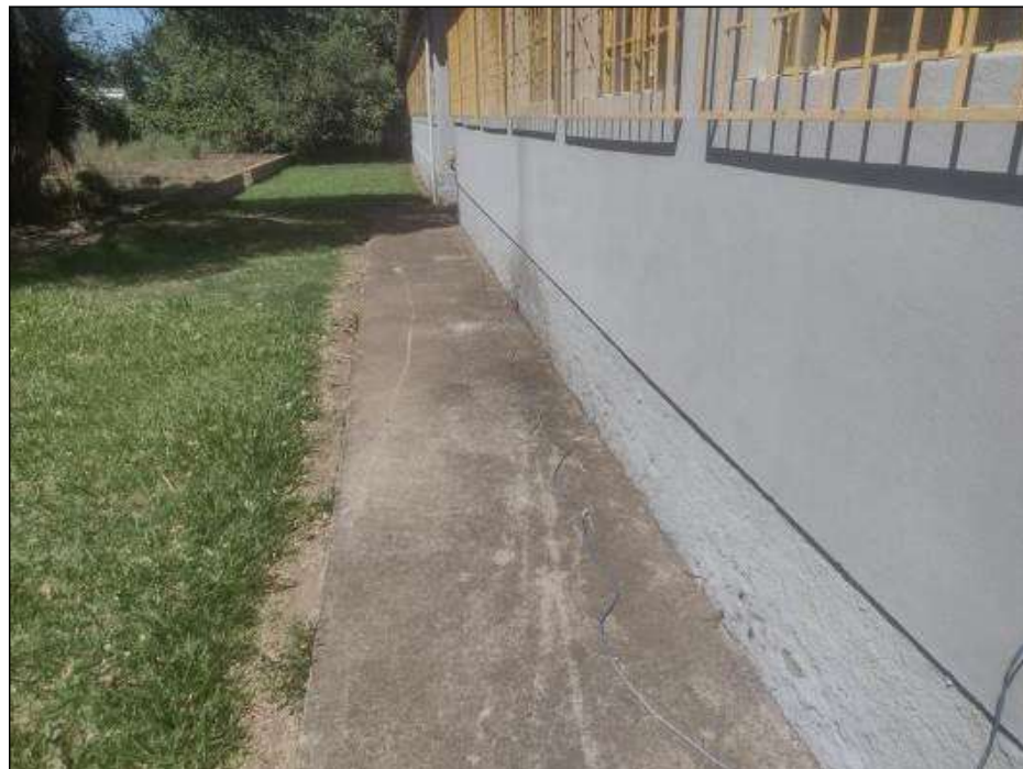
Figura 44 - Bloco 03 / Circulação externa – piso
