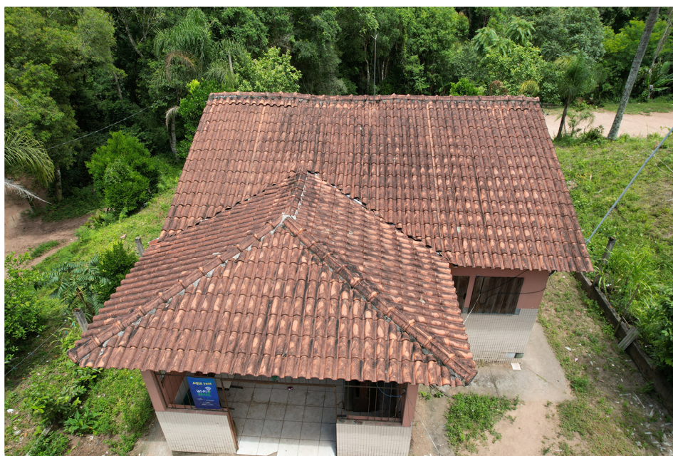
Figura 3: Foto de drone - Visão geral da cobertura
