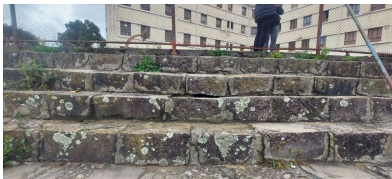
Figura 4 Detalhe da escada
