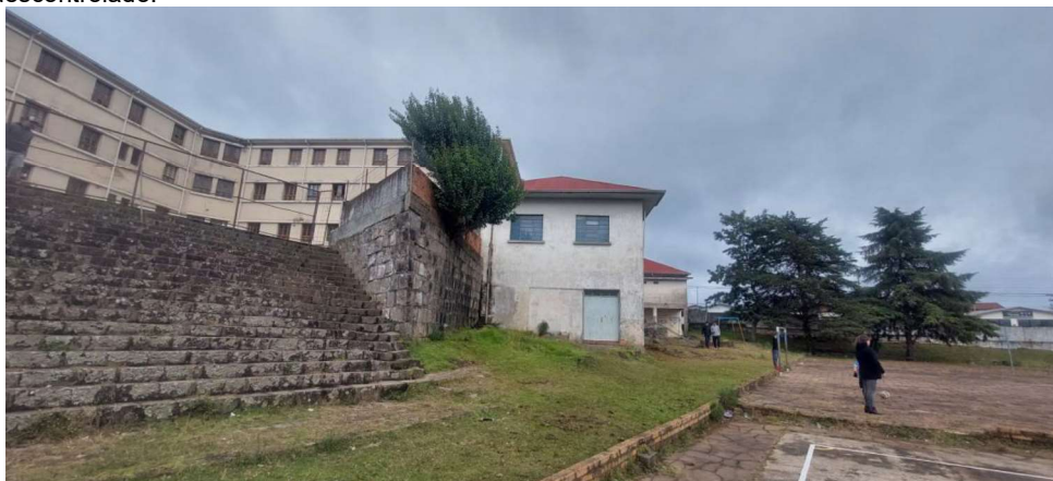
Figura 3 Vista da escada existente
