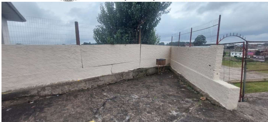
Figura 9 Muro danificado
