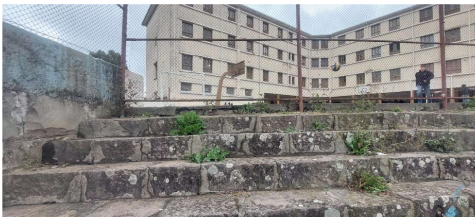
Figura 5 Detalhe da escada
