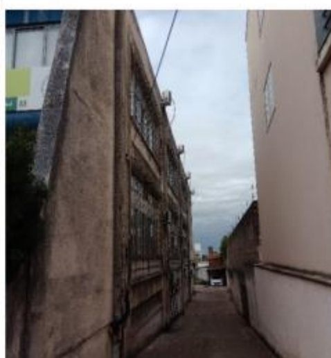
Local para instalação de condensadoras: Corredor garagem.
