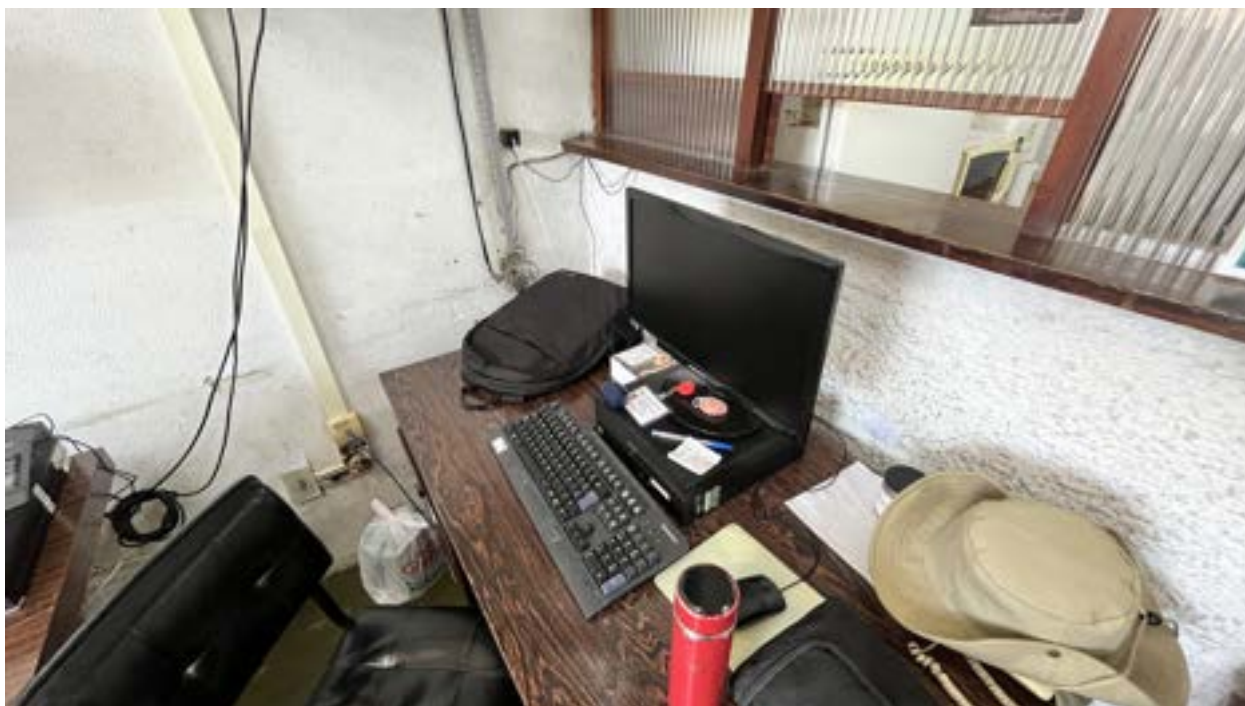
Figura 12 – SUBÁREA D – Visão do local das tomadas elétricas e ponto lógico/rede existente – O novo ponto lógico/rede deverá ser criado na parede bem atrás do micro/monitor da foto
