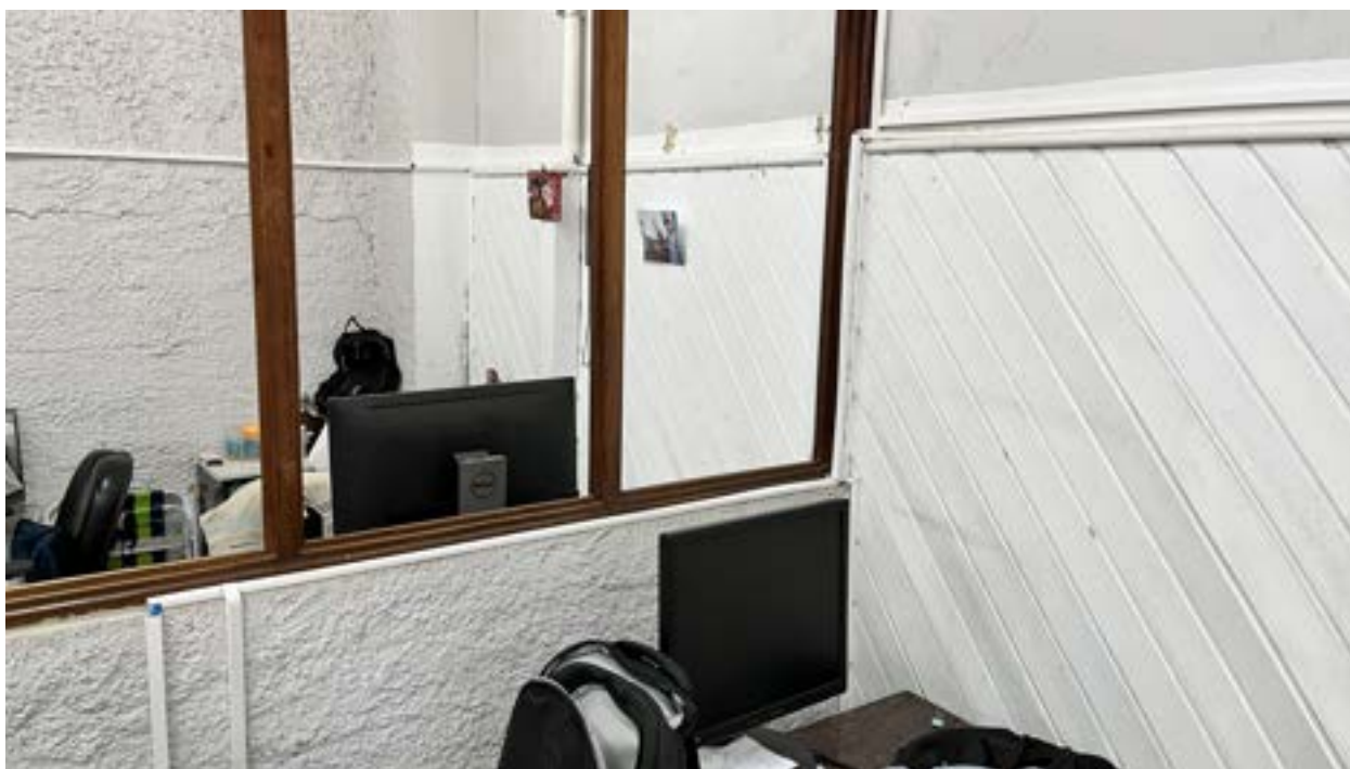
Foto 2 – SUBÁREA A - Canaletas existentes
