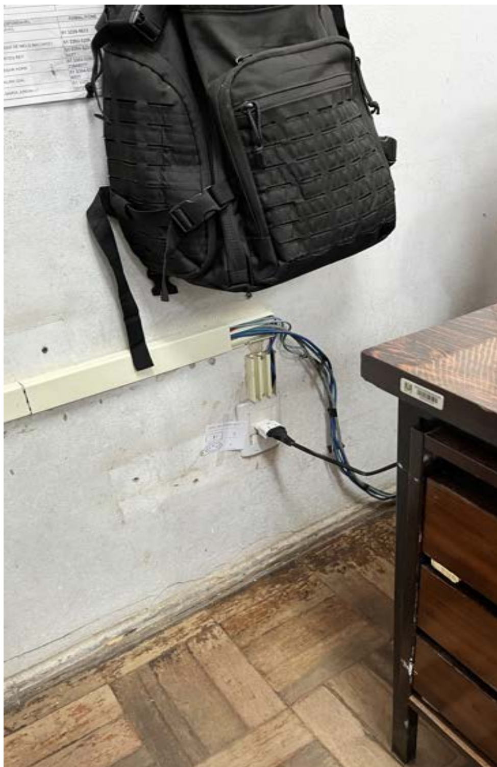
Figura 10 – SUBÁREA C – Canto das tomadas elétricas (visão aproximada)
