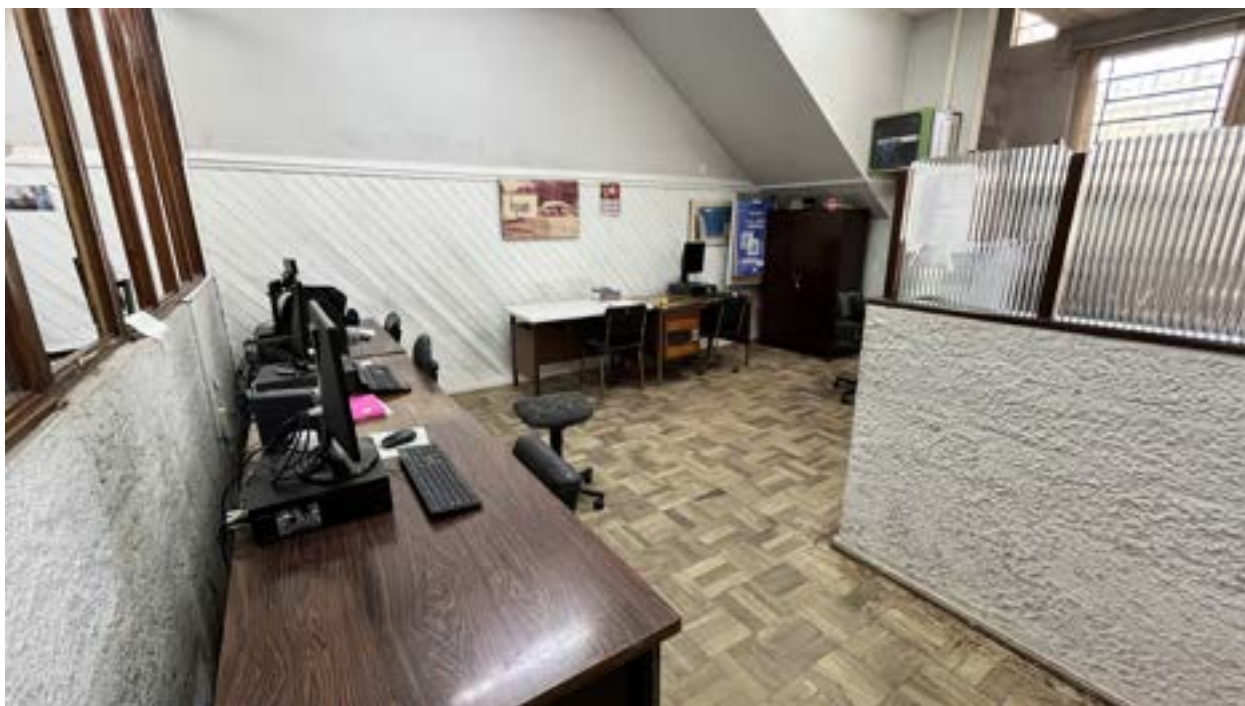
Figura 6 – SUBÁREA B – Visão de longe das paredes, canaletas e rack ( R )
