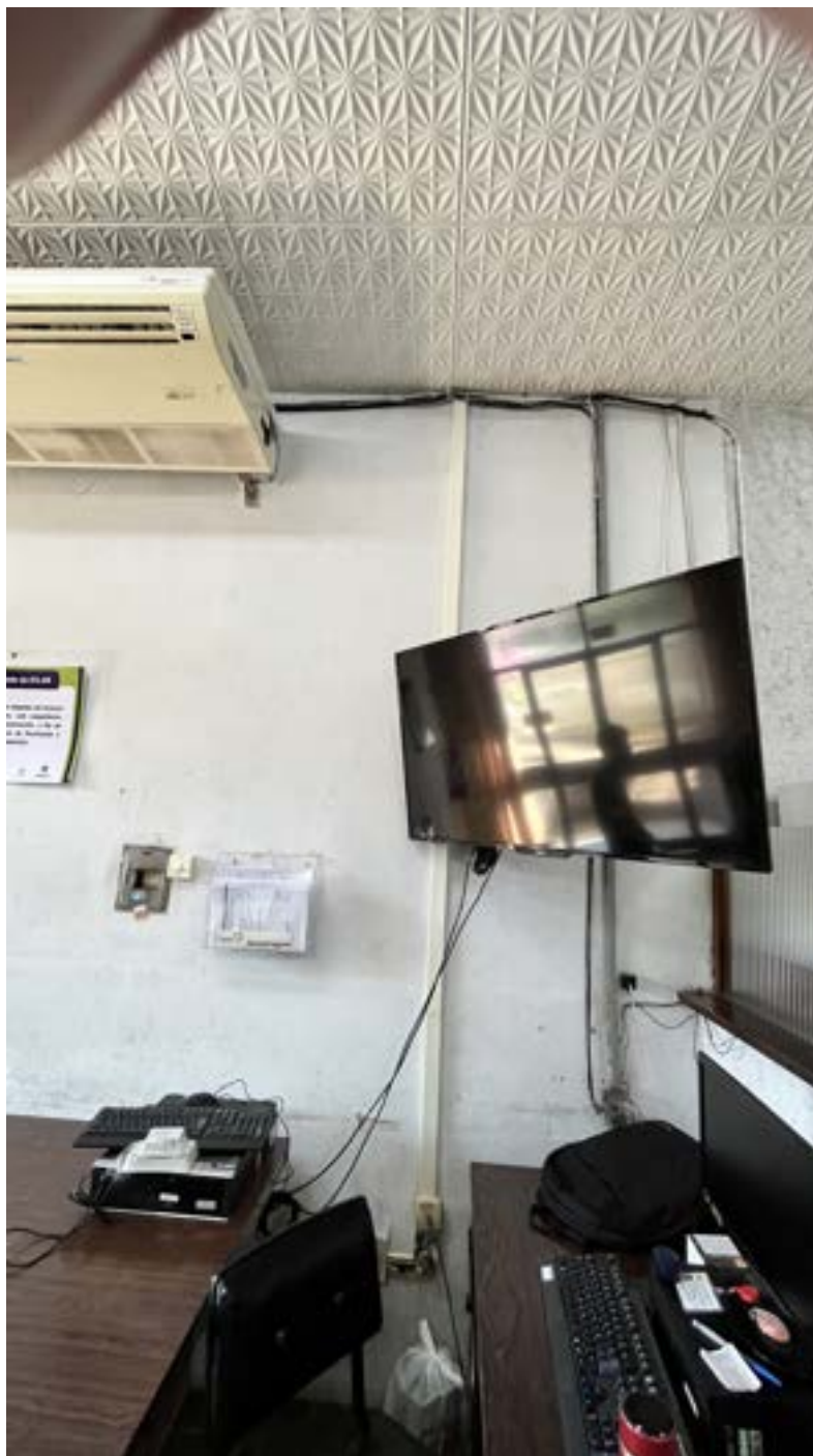
Foto 11 – SUBÁREA D – Tomadas elétricas (1 reformar e outra criar) e tomada/ponto lógico/rede existente
