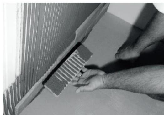
Falha de assentamento. Cordões não totalmente esmagados
