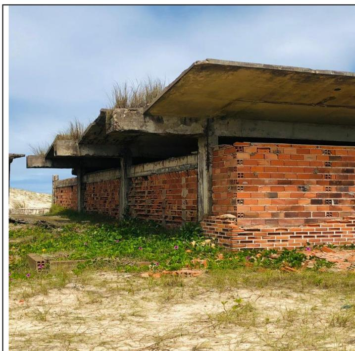
9 – Cobertura (laje) em Concreto Armado deteriorada.
