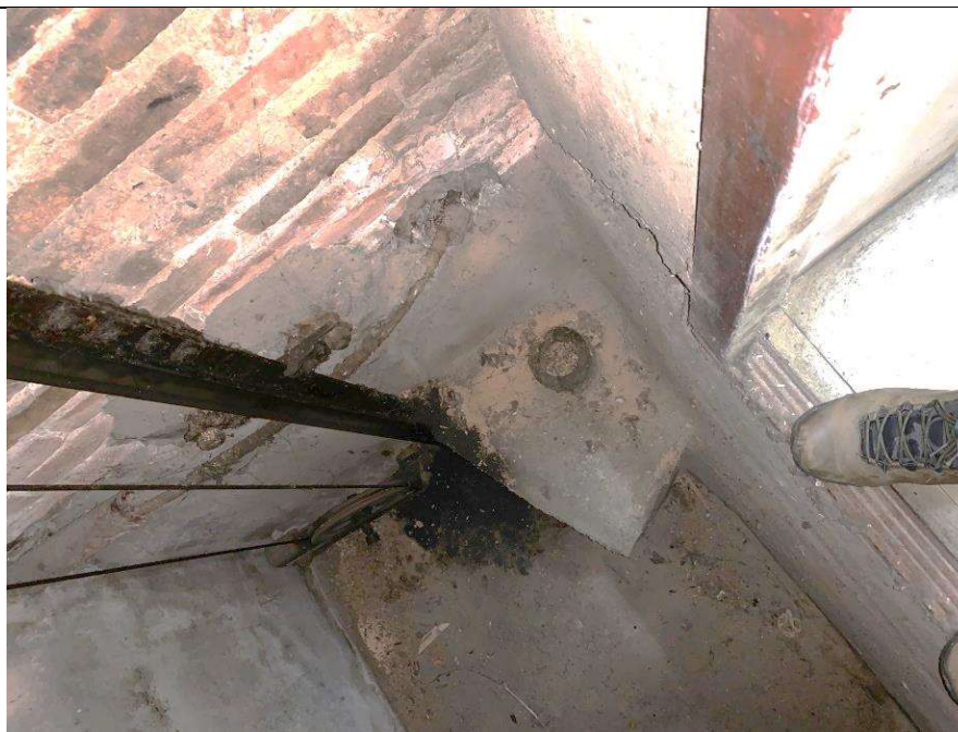
Fotografia 12 Fundo de poço caixa de corrida 02
