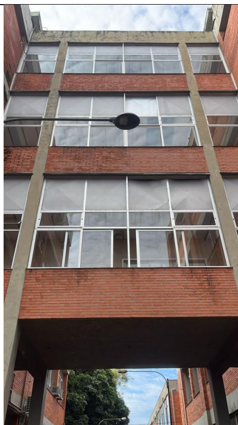
Foto 08: vista fachada oeste
