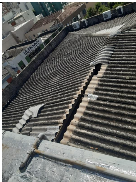
Foto 02: vista bloco norte
