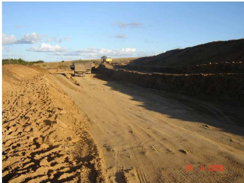
Foto 13 – Vista geral da cava das estruturas das Galerias da Tomada D'água e Desvio do Arroio Jaguari – ao fundo vê-se o perfil de alteração
