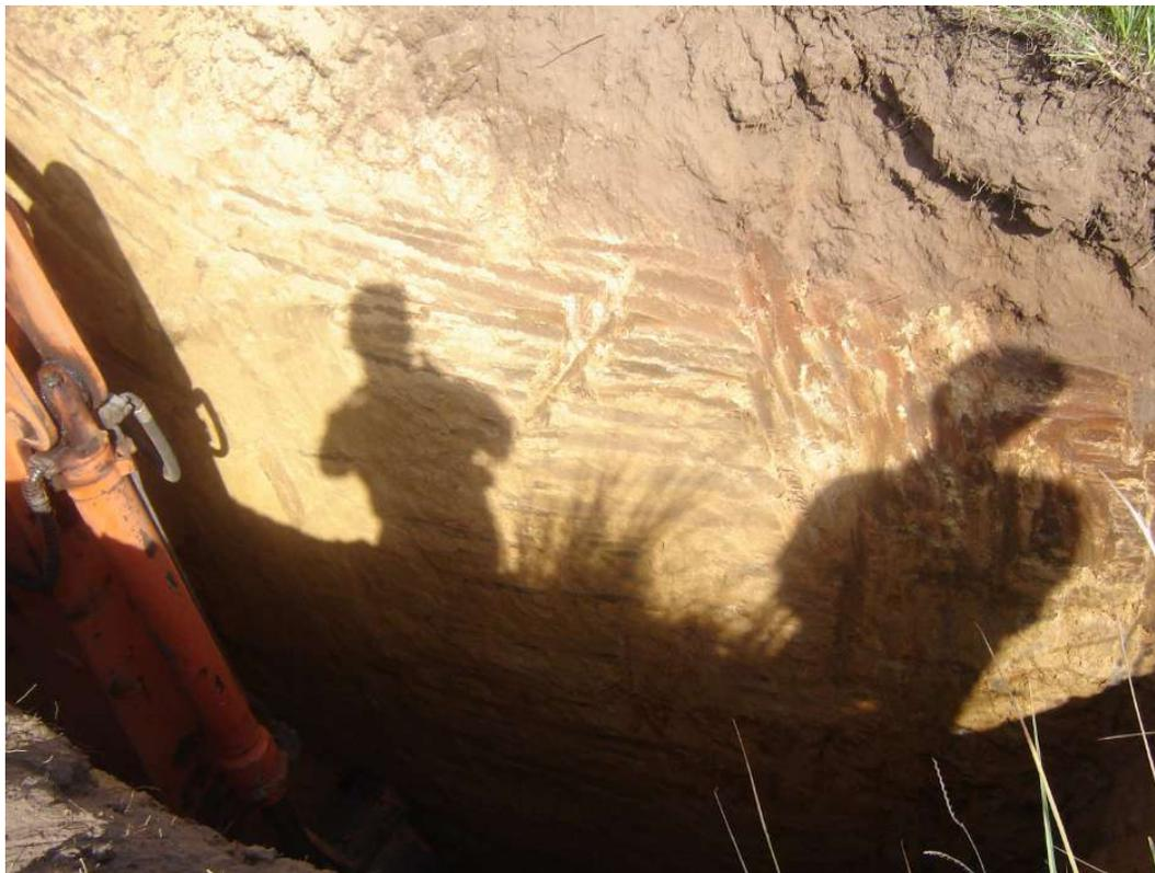
Foto 4 – Vista de um corte do perfil de alteração da margem esquerda nas proximidades da estaca 14. Neste trecho o perfil da fundação da barragem é constituído de uma camada superficial de argila silto-arenosa marrom de consistência média e, na seqüência, de areia média e grossa silto-argilosa ou areia siltosa com pedregulhos amarelada às vezes com blocos de quartzo (solo saprolítico ou saibro) compacta e a rocha decomposta amarelada impenetrável a trépano ou rocha saprolítica
