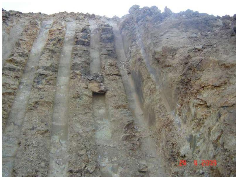
Foto 14 – Vista do talude da cava de fundação das estruturas das Galerias da Tomada D'água e Desvio do Arroio Jaguari no trecho do eixo do barramento – vê-se que terreno é constituído de rocha saprolítica ou decomposta, conforme descrição das sondagens rotativas
