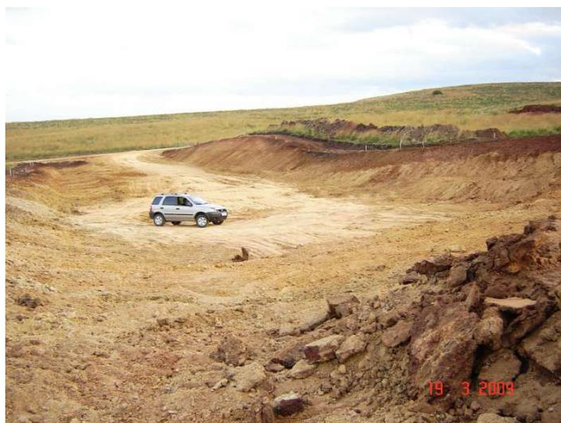
Foto 12 – Vista geral da cava do vertedouro no seu trecho de montante – ao fundo vê-se o perfil de alteração completo, com as camadas superficiais de areia silto-argilosa de cores avermelhadas com pouca espessura e a areia média e grossa silto-argilosa amarelada, sendo estas duas camadas representativas da Jazida da Ombreira Esquerda da barragem
