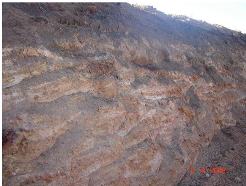
Foto 18 – Detalhes da camada superficial da margem direita da barragem na estaca 40 - superficialmente vê-se a camada de solo vegetal e subjacente à rocha granítica decomposta quase aflorando
