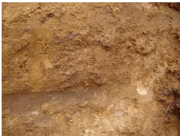
Foto 6 – A foto mostra em detalhes uma porção do perfil de alteração da ombreira esquerda constituído de materiais saprolíticos ou de areia média e grossa siltosa de coloração amarelada ou saibro – esta camada ocorre principalmente no trecho da estaca 09 a estaca 15 e se mostra com espessura variável e com aspecto visual e tátil de material não plástico e permeável
