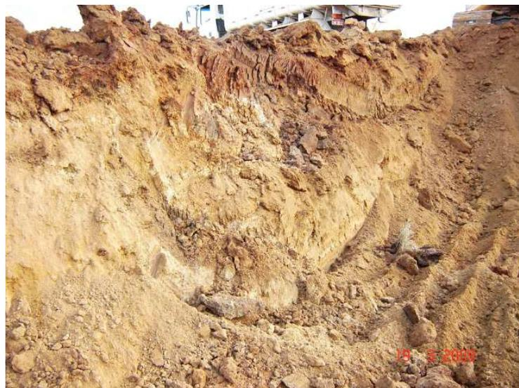
Foto 2 – Vista geral de um corte do perfil de alteração da margem esquerda no local da calha do vertedouro – a imagem mostra as camadas de areia argilosa vermelha e amarelada e subjacente as areias silto-argilosas ou saibro
