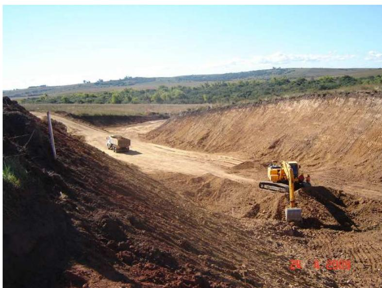
Foto 40 – Vista geral da escavação do canal de restituição do vertedouro – neste trecho não é verificada a presença de nível freático nas camadas de rocha decomposta
