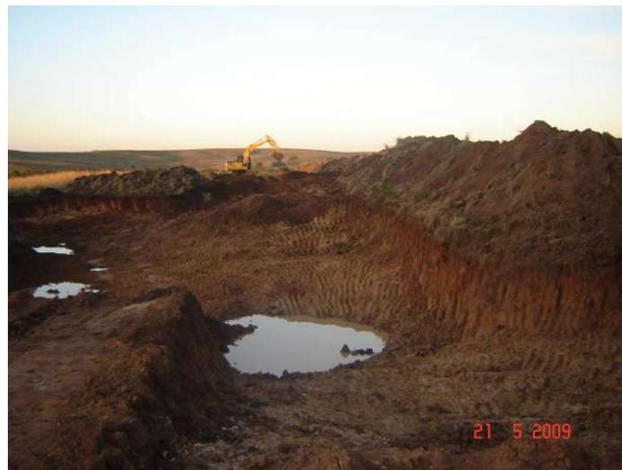
Foto 36 – Vista geral da conformação das escavações da Jazida da Ombreira Esquerda da Barragem do Arroio Jaguari – vê-se que as camadas de argila arenosa de cor vermelha e as areias silto-argilosas de cores amareladas apresentam pouca espessura e muito variável. O aproveitamento das camadas superficiais argilosas desta jazida deve variar de 0,5 a 2,0m – este corte foi destinado a construção da Ensecadeira da Tomada D'água
