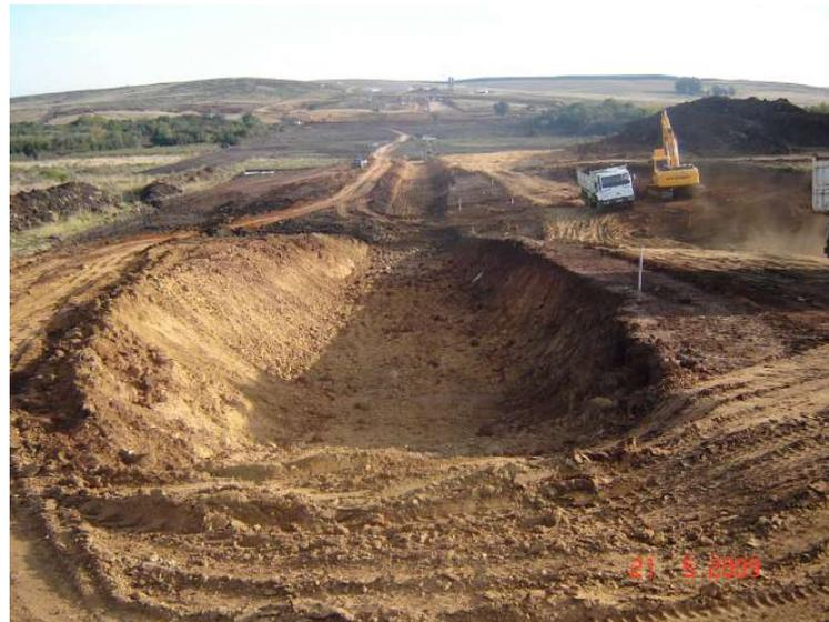
Foto 16 – Vista geral da cava da trincheira de vedação na Ombreira Direta do barramento, no seu trecho final (estaca 52) – neste trecho, vê-se que o perfil de alteração é constituído de solo saprolítico e rocha granítica decomposta, materiais arenosos compactos ou impenetráveis a trépano em profundidades menores do que 1,0m
