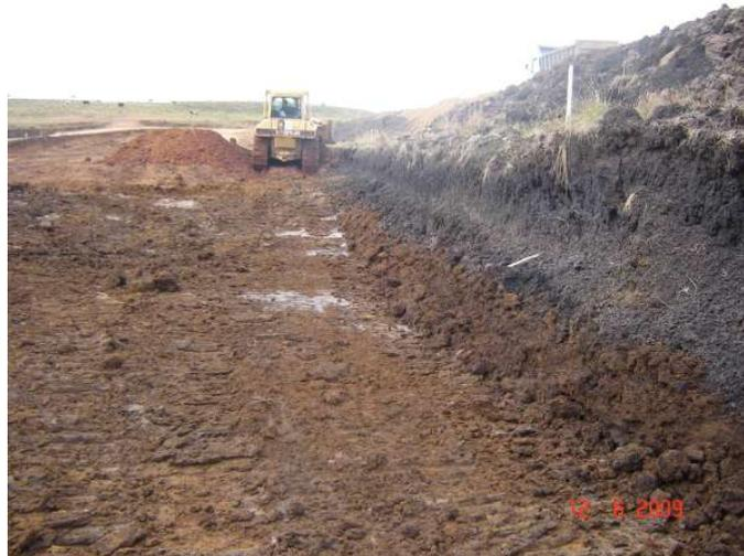
Foto 21 – Vista geral da camada de argila orgânica da ombreira direita da barragem – subjacente verifica-se a presença da camada de areia média e grossa silto-argilosa ou de solo saprolítico de coloração variegada, predominando a cor amarela. Esta ocorrência de argila orgânica se limita a um trecho com uma nascente d’água no alto da coxilha nas proximidades da estaca 49
