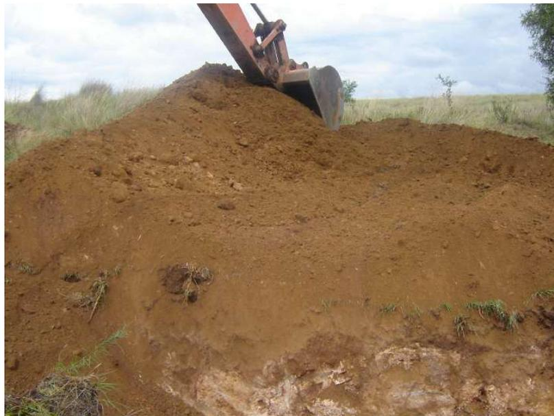
Foto 7 – Detalhes da camada superficial da margem esquerda na estaca 17 - superficialmente vê-se a camada de solo vegetal com grama e subjacente a rocha granítica decomposta
