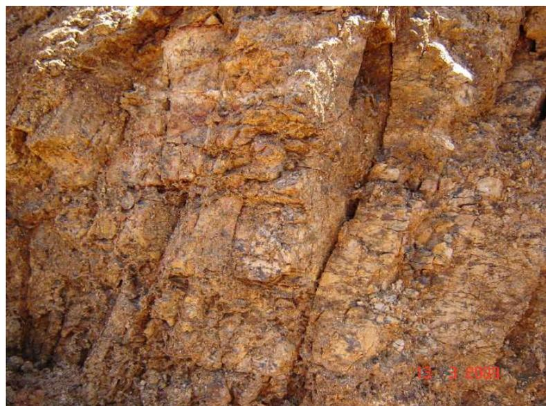
Foto 10 – Detalhes do talude de corte da calha do vertedouro constituído de rocha saprolítica ou decomposta
