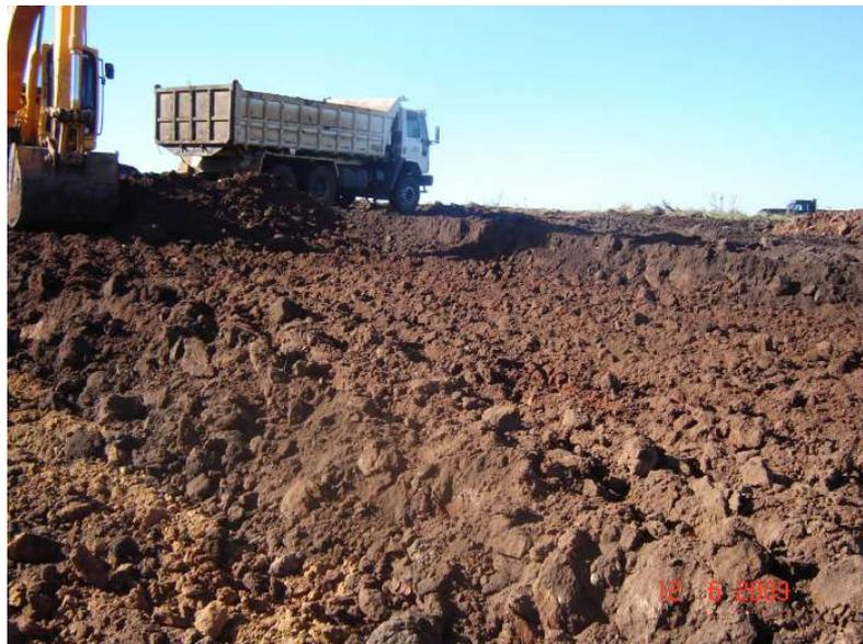
Foto 39 – Idem foto anterior – camada sem cobertura vegetal, sendo preparada para a escavação da camada aproveitável para o fornecimento de materiais argilosos para a construção do maciço do barramento e ensecadeiras
