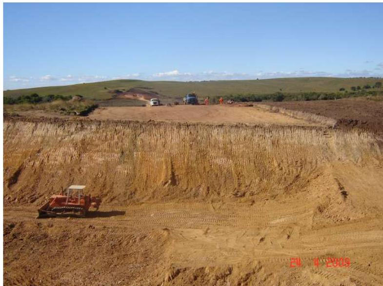
Foto 9 – Vista geral do talude de corte da calha do vertedouro no trecho do barramento – neste trecho o terreno de fundação, suprimida a camada de cobertura vegetal, é constituído de solos saprolítico e rocha saprolítica ou decomposta
