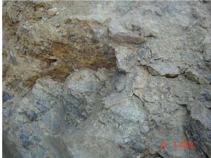
Foto 15 – Detalhes da rocha decomposta dos taludes da cava das estruturas das Galerias da Tomada D'água e Desvio do Arroio Jaguari – maciço rochoso com fraturamento milimétrico
