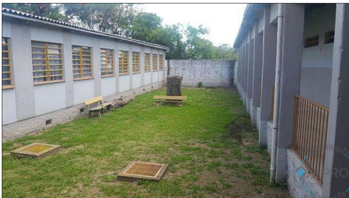
Figura 08– Bloco 02 / Elevação Norte
