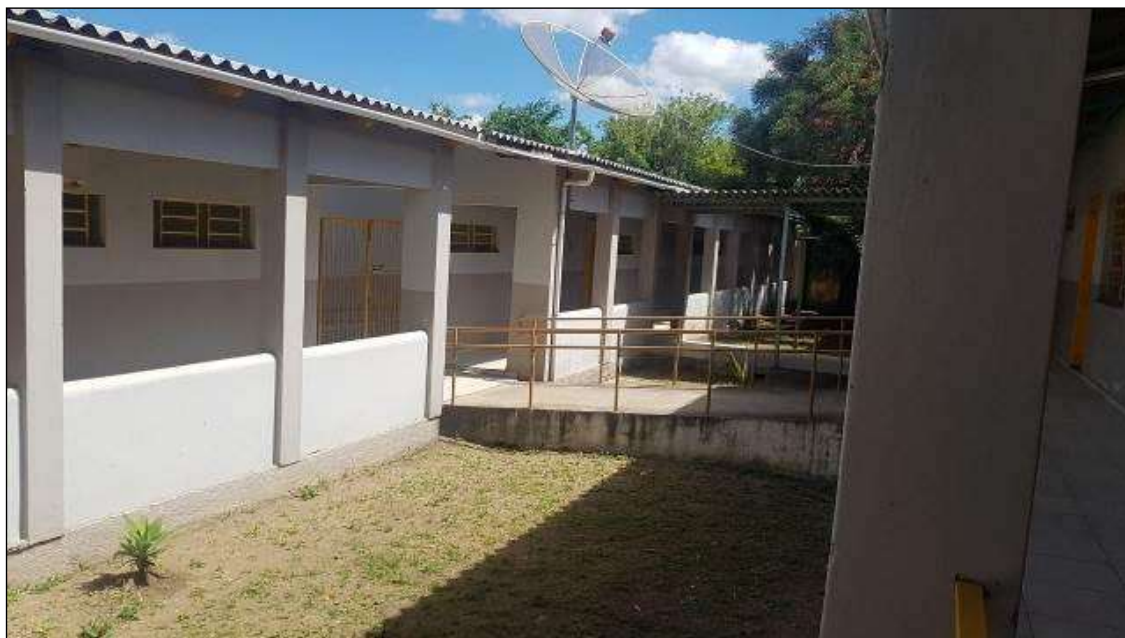
Figura 17– Bloco 03 / Elevação Norte
