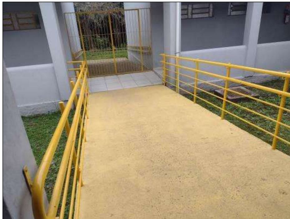
Figura 62 – Rampa de acesso Bloco 03
