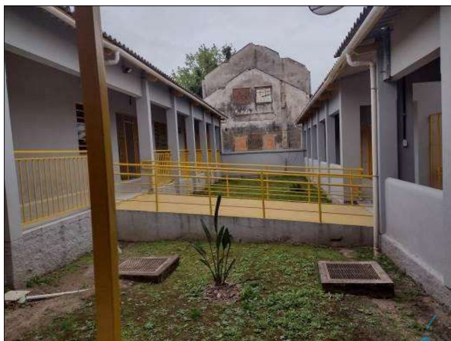
Figura 61– Rampa de acesso Bloco 03
