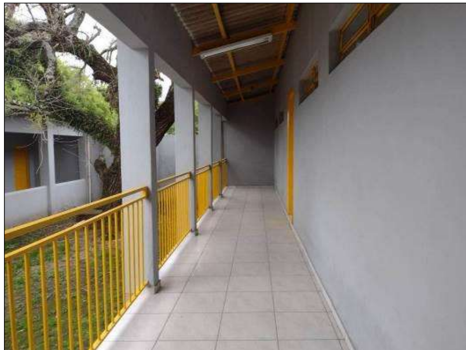
Figura 38 - Bloco 02 / Circulação – piso
