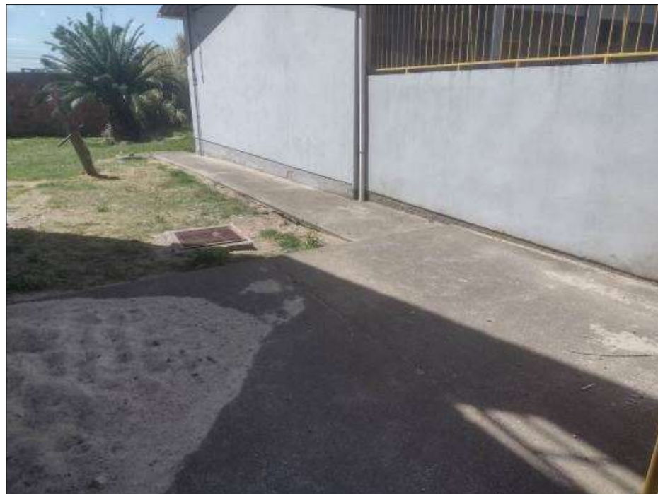
Figura 42 - Bloco 03 / Circulação externa – piso
