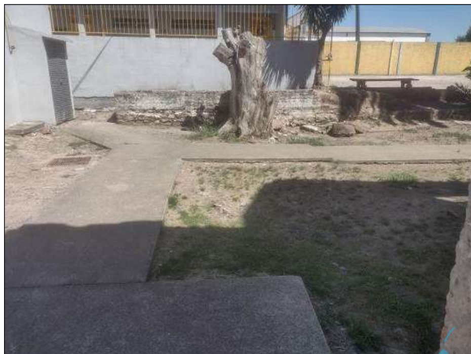
Figura 43 - Bloco 03 / Circulação externa – piso
