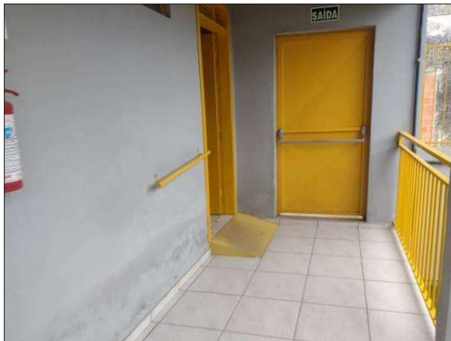
Figura 60– Bloco 02 / Rampa de acesso sanitário masculino
