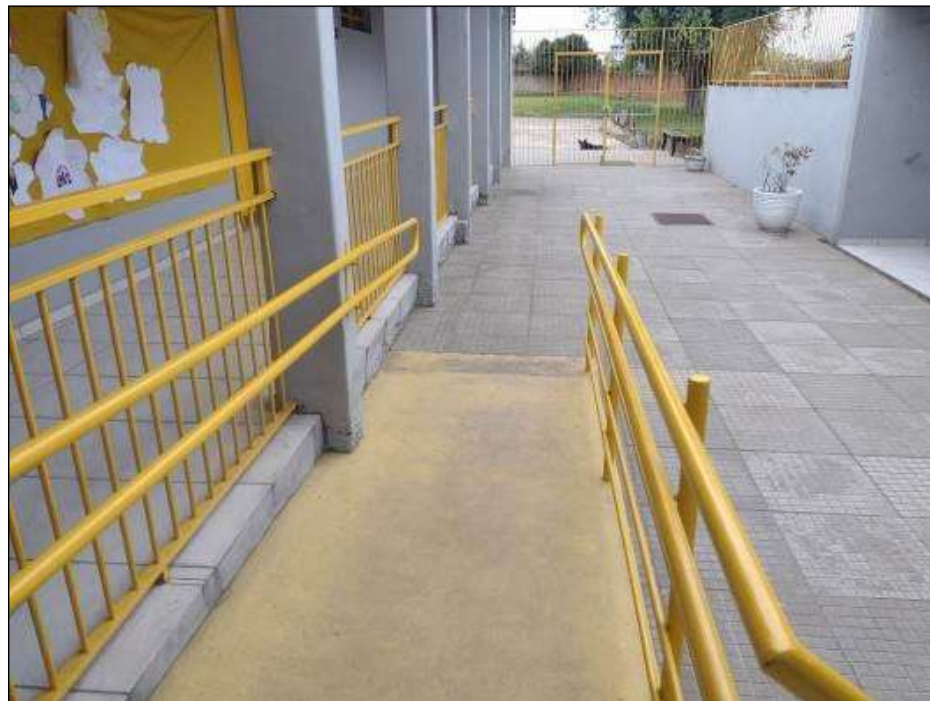
Figura 58 - Rampa de acesso Bloco 01
