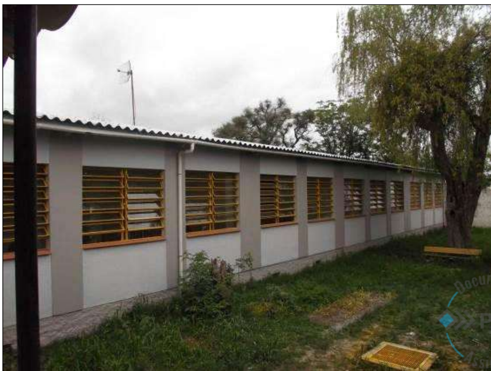
Figura 10– Bloco 02 / Elevação Norte
