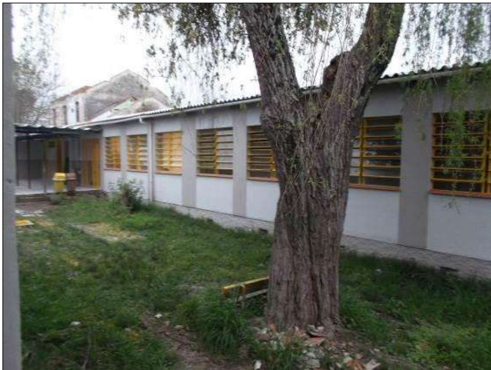
Figura 09– Bloco 02 / Elevação Norte
