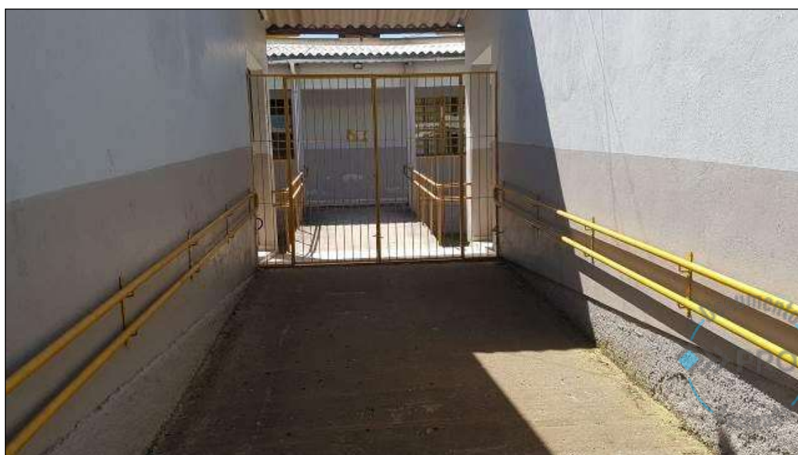
Figura 65 – Rampa de acesso circulação pátio
