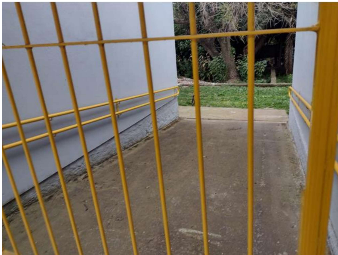
Figura 64 – Rampa de acesso circulação pátio
