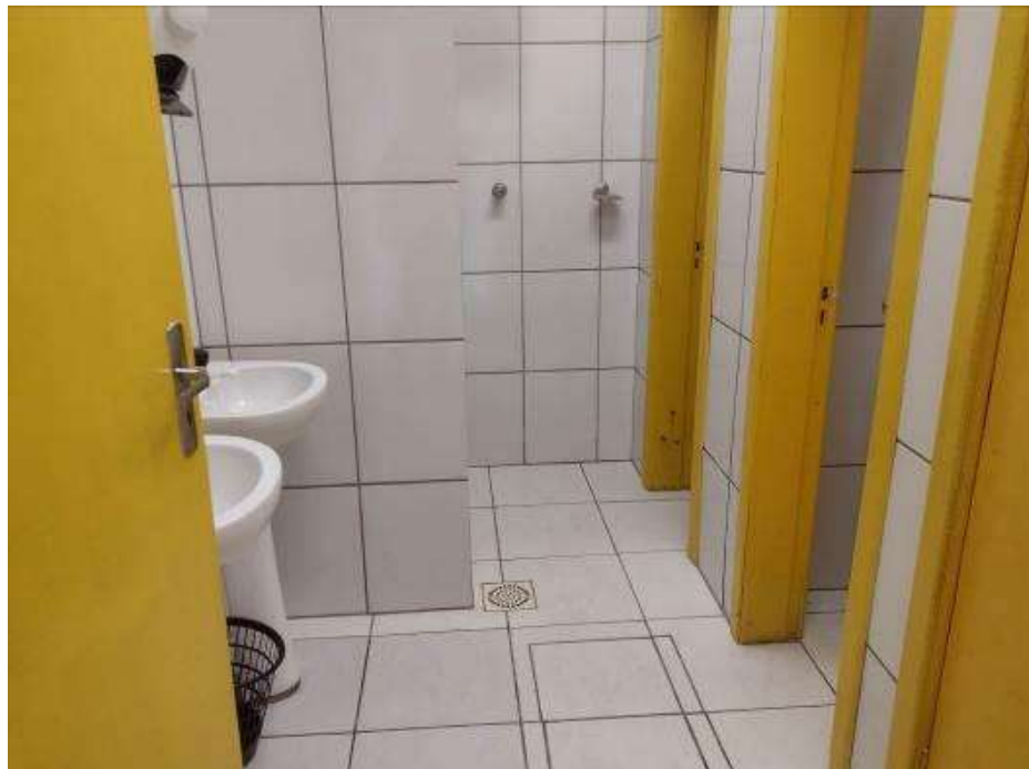
Figura 106- Bloco 02 / Sanitário Masculino
