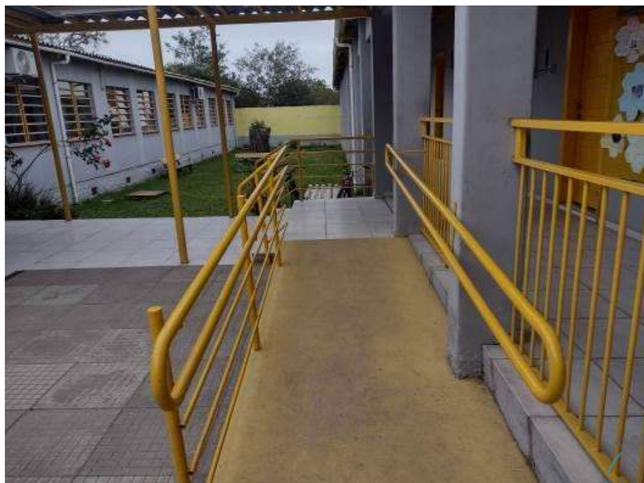
Figura 57 - Rampa de acesso Bloco 01
