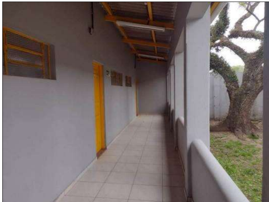
Figura 40 - Bloco 03 / Circulação – piso
