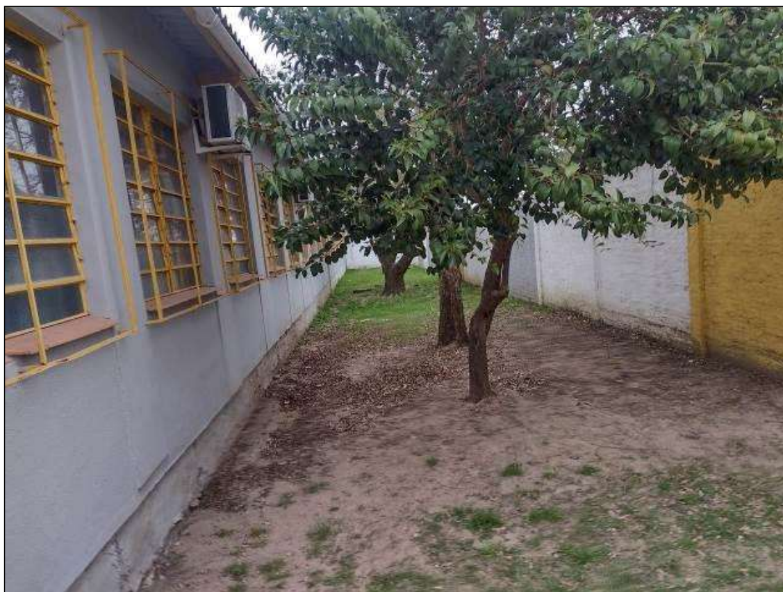
Figura 02– Bloco 01 / Elevação Norte
