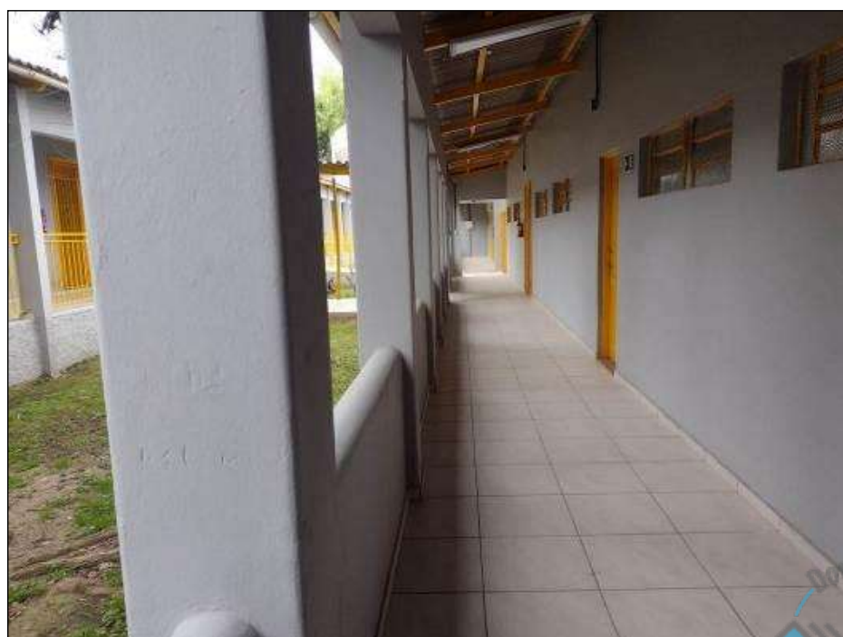
Figura 41 - Bloco 03 / Circulação – piso
