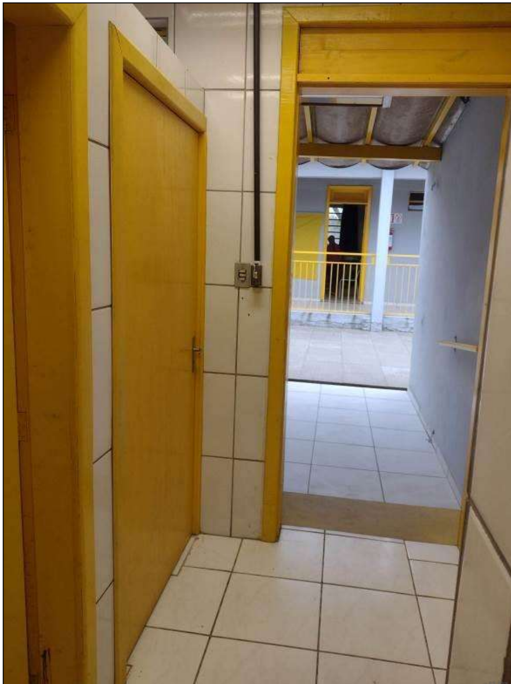
Figura 105 – Bloco 02 / Sanitário Masculino
