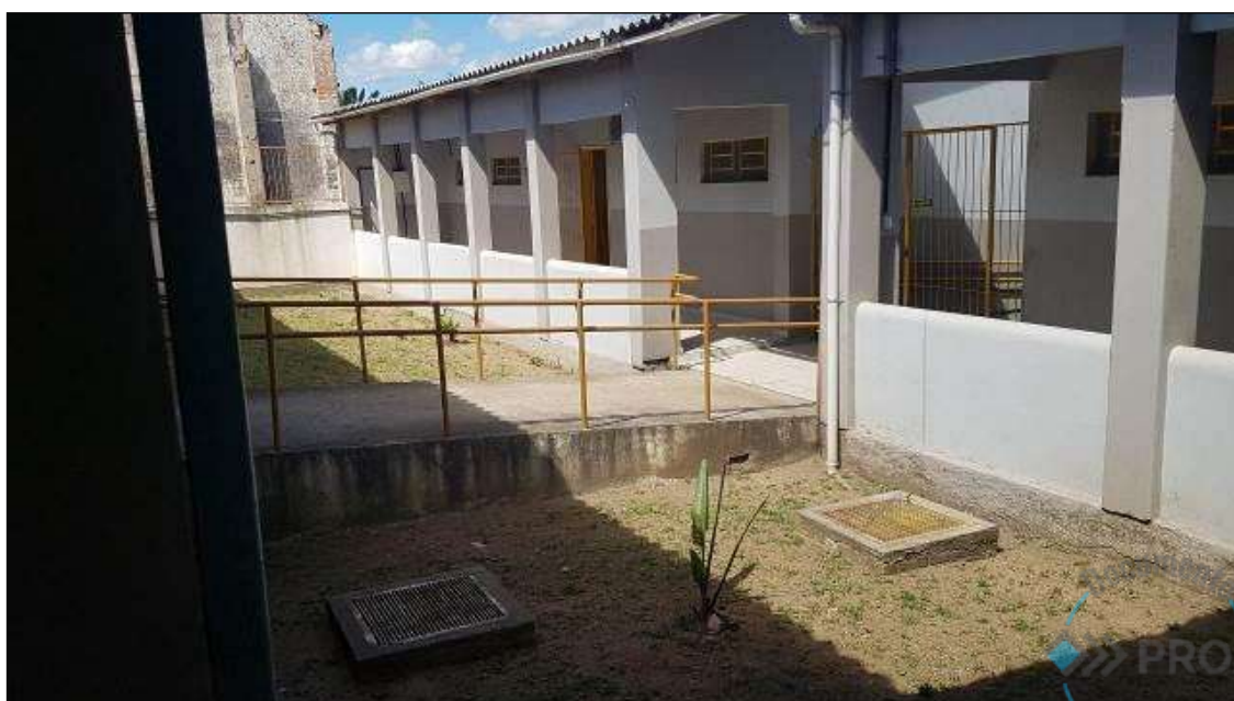
Figura 16– Bloco 03 / Elevação Norte
