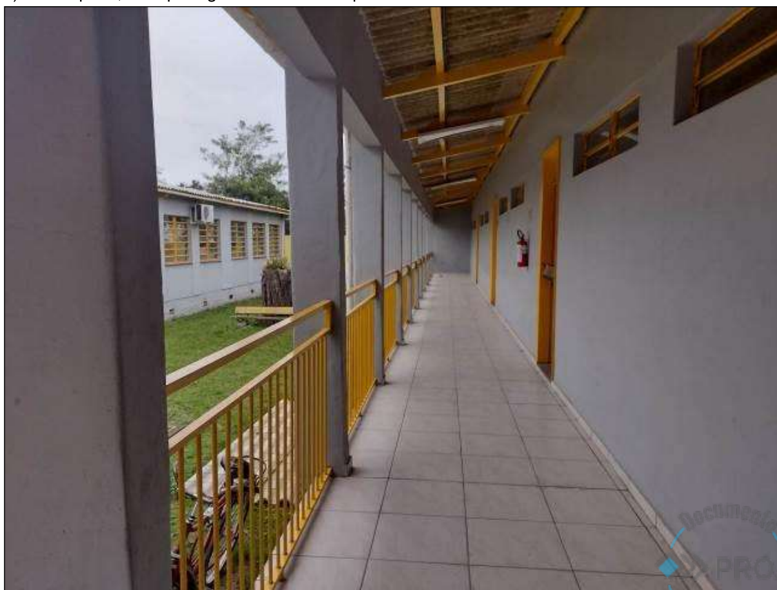
Figura 82– Bloco 01/ Circulação interna
