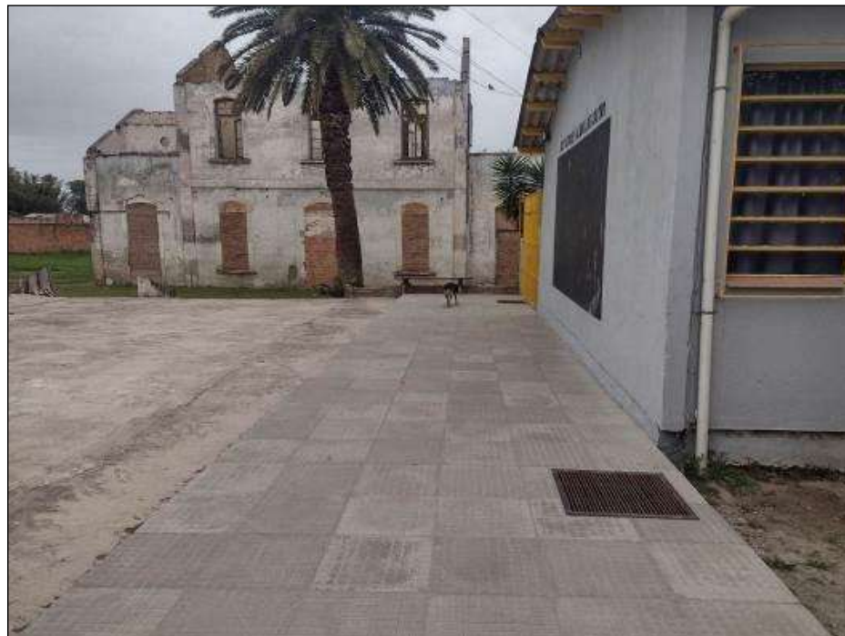
Figura 32 - Circulação Acesso Escola– piso
