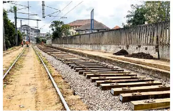
Obras envolvem a remontagem de trechos atingidos pela enchente
