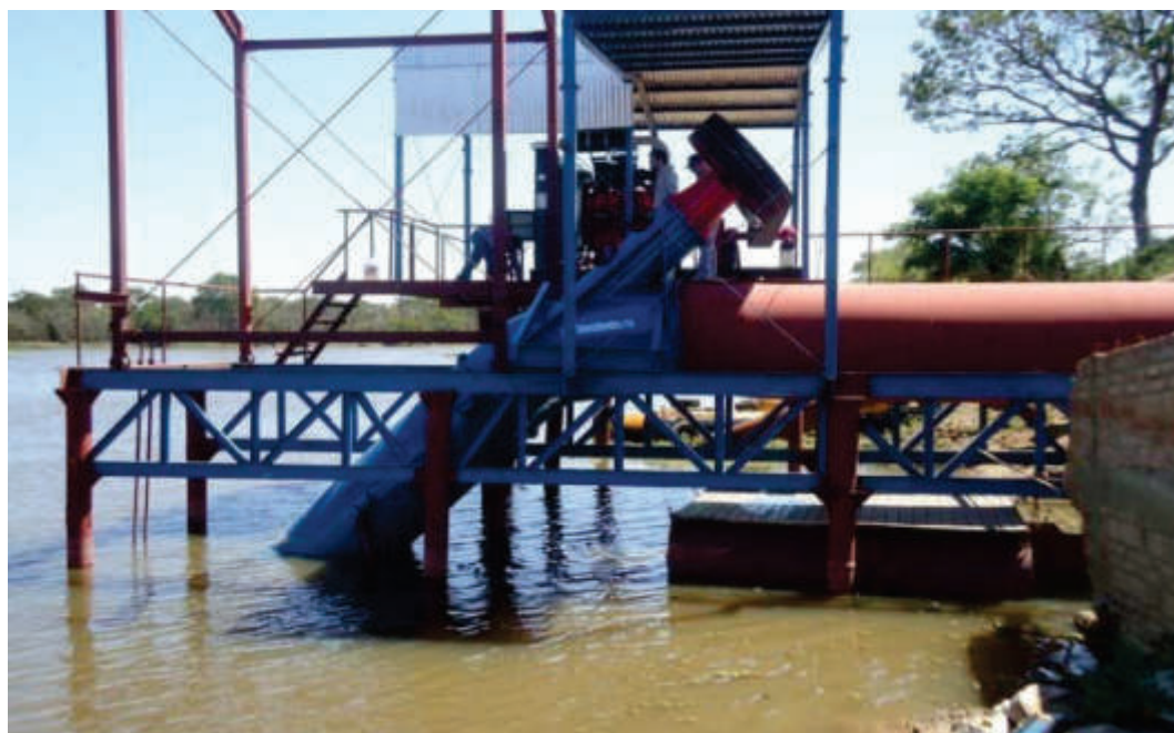
Figura 4.5. Instalações com bombas tipo turbina instaladas com eixo inclinado ou vertical
