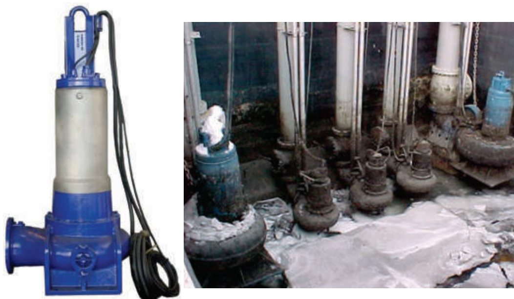
Figura 4.4. Bomba submersível para drenagem urbana e arranjo típico em estação subterrânea
