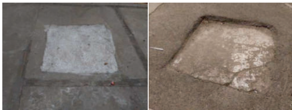
Figura 3.17: Poços de visita inacessíveis
