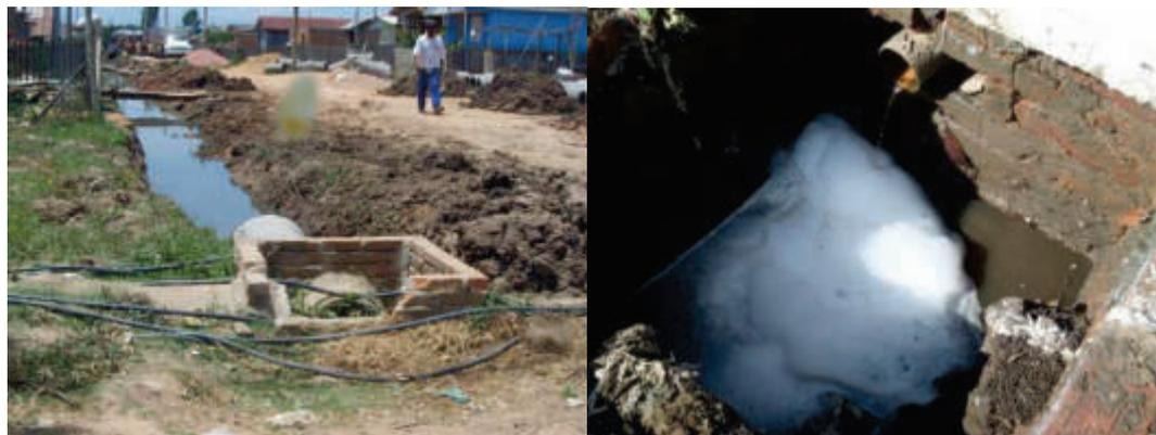
**Figura 3.47: Rede de drenagem em Eldorado do Sul, com contribuições de esgoto sanitário**
