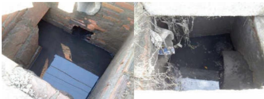
**Figura 3.48: Escoamento insuficiente, por declividade inadequada**
