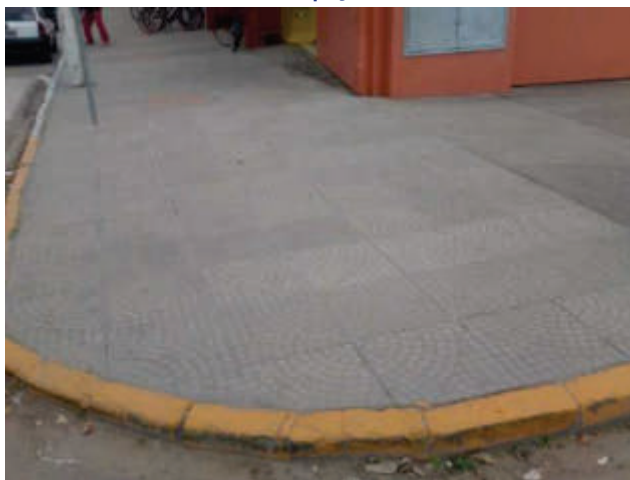
Caixa de inspeção lacrada
