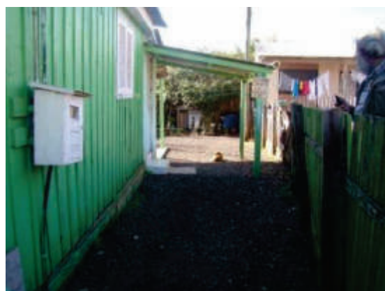
Vista da área do Imóvel que frequentemente é afetada pelas enchentes.
