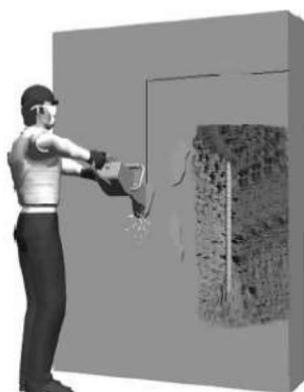
3. Remover com martetele, marreta/talhadeira o concreto deteriorado, inclusive o do entorno da armadura corroída ou não ( $\pm 2$  cm). Remover sujeira, contaminantes, incrustações e partes soltas por hidrojateamento de alta
