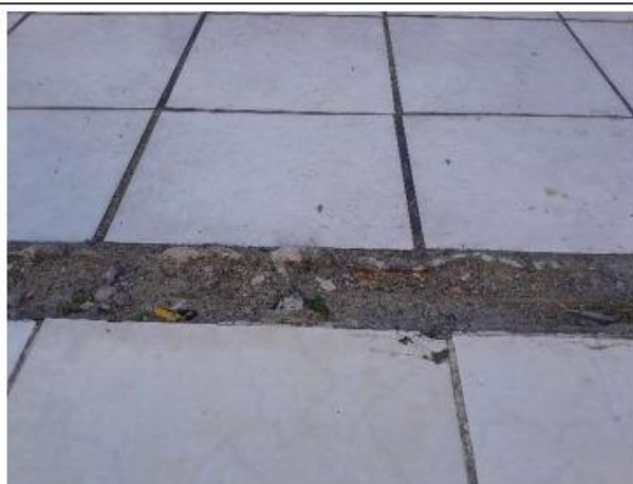
Buracos no pavimento na sala de atendimento externo
