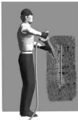
4. No caso das estruturas danificadas ou faltantes proceder a quebra do concreto até o aparecimento da armadura existente e, a seguir, executar a reconstrução da armadura novamente. Reconstituir a seção de concreto inicial utilizando graute com fck > 40 Mpa.
