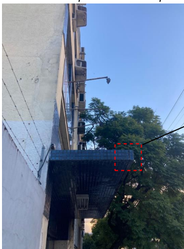
Figura 2: Vista lateral da marquise no acesso principal do D. M. L.
