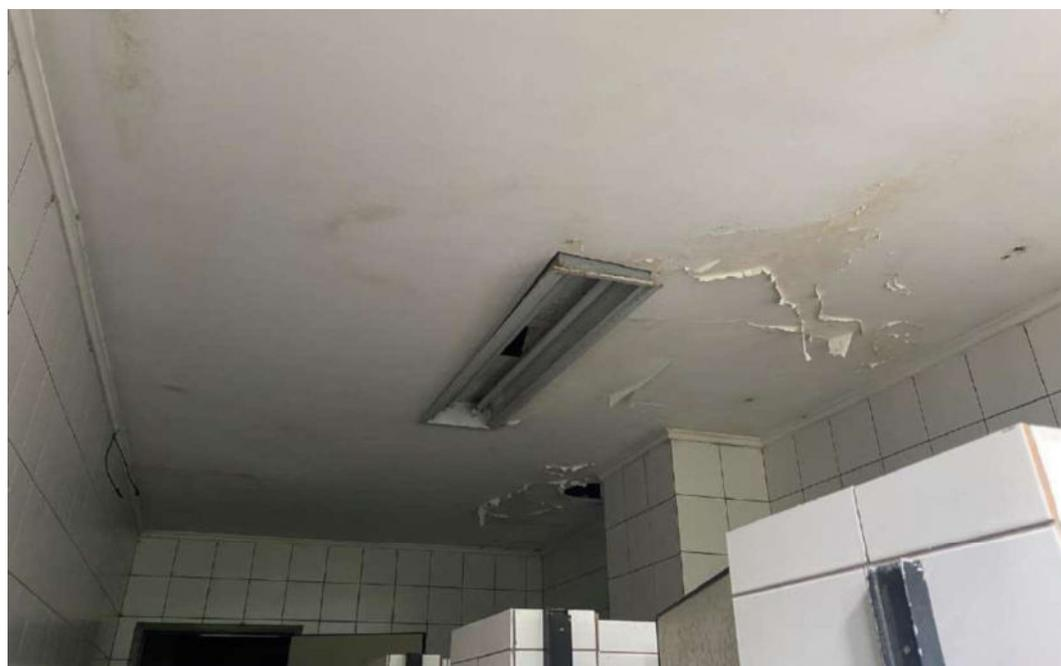
Figura 111: Presença de umidade e deslocamento no forro de gesso na laje 441
