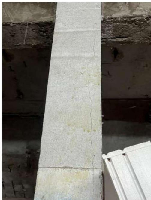
Figura 29: Presença de fissura no pilar 85
