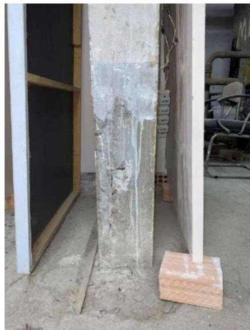
Figura 45: Detalhe - Desplacimento do concreto de cobertura, exposição e corrosão de armaduras no pilar 68
