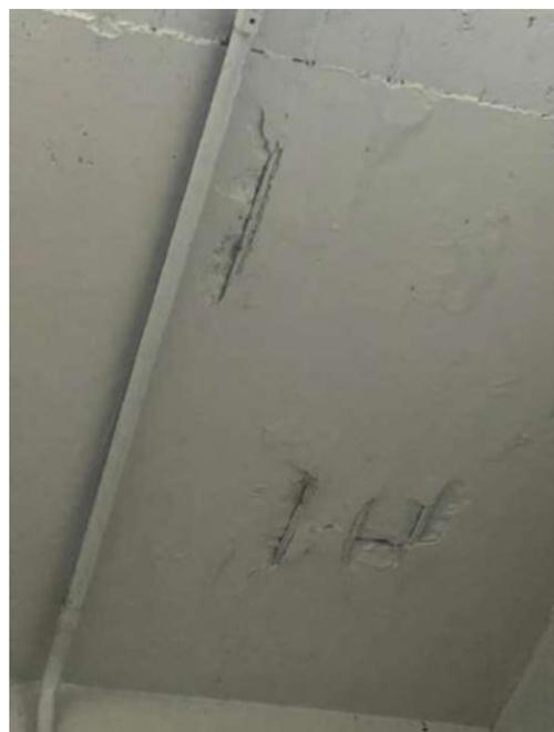
Figura 79: Detalhe - Armadura exposta e deslocamento na laje 216 do pavimento subsolo (garagem)
