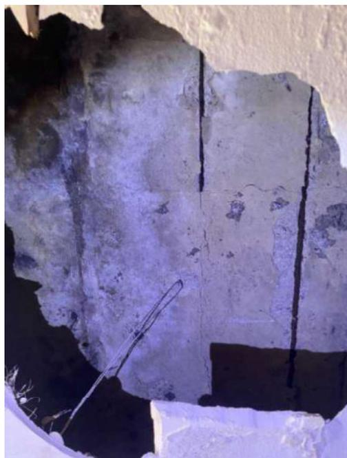
Figura 171: Detalhe - Exposição e corrosão de armadura na laje
