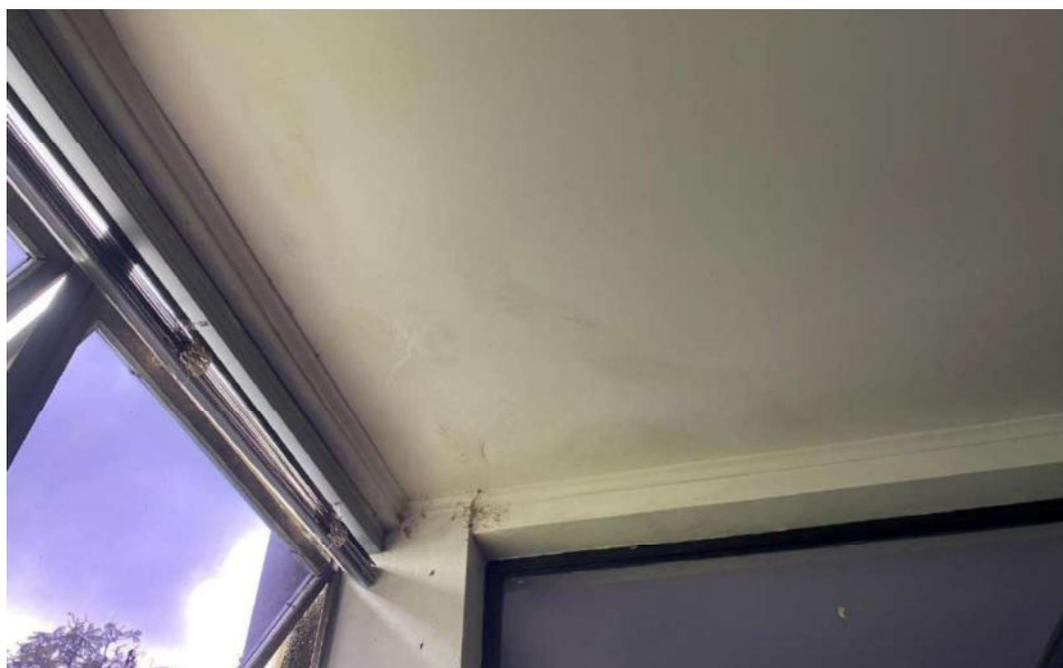
Figura 131: Presença de umidade no forro de gesso na laje 551
