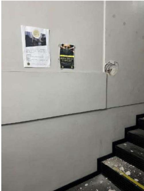
Figura 89: Corrosão da armadura no pilar 59 da escada do pavimento subsolo (garagem)
