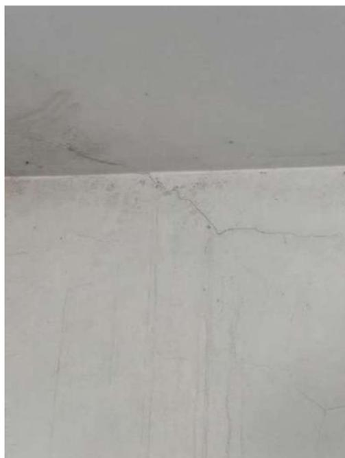
Figura 183: Presença de umidade e fissuras na laje
