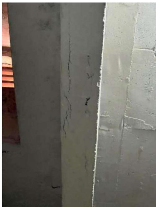
Figura 76: Fissuras e deslocamento do concreto de cobertura da viga 231 no pavimento subsolo (garagem)
