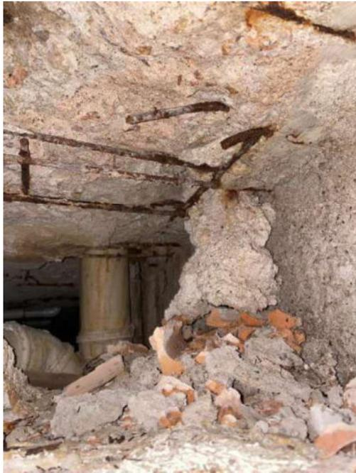
Figura 126: Exposição e corrosão de armaduras na laje 427
