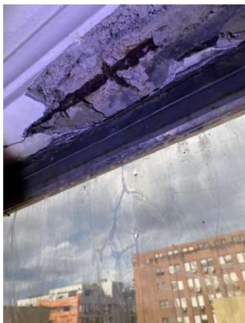
Figura 169: Detalhe - Desplacamento do concreto de cobertura, exposição e corrosão das armaduras na viga
