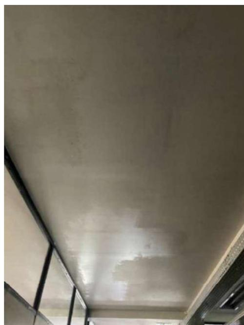
Figura 134: Presença de umidade no forro de gesso na laje 536
