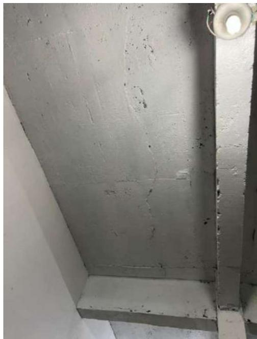
Figura 66: Deplacamento do concreto de cobrimento na laje 244 e fissura na viga 209
