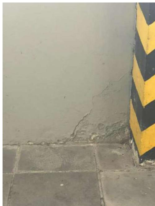
Figura 85: Fissura na alvenaria próxima ao pilar 03 no pavimento subsolo (garagem)
