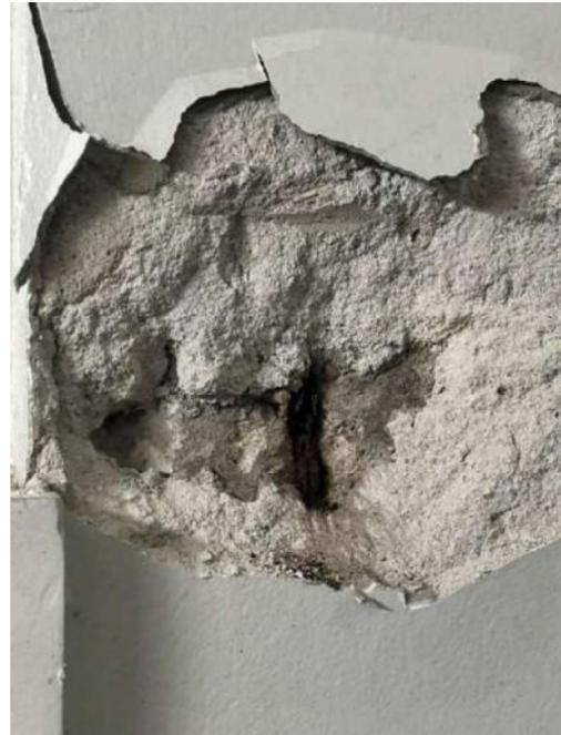
Figura 90: Detalhe - Corrosão da armadura no pilar 59 da escada do pavimento subsolo (garagem)
