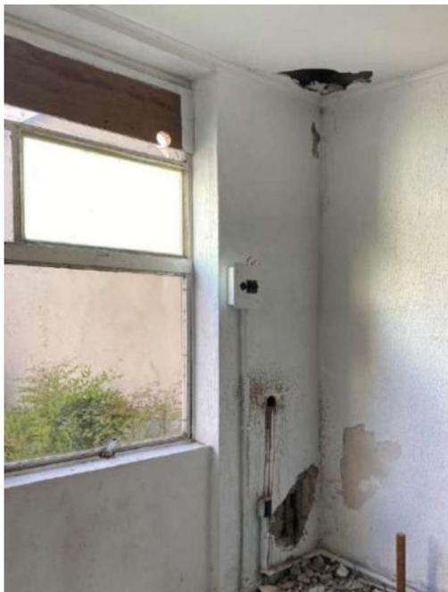
Figura 92: Visão geral - Corrosão da armadura no pilar 82 da fachada principal pavimento térreo
