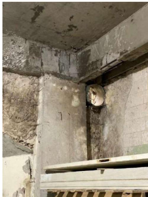
Figura 52: Deslocamento do concreto de cobrimento das vigas 224 e 234, exposição e corrosão de armaduras
