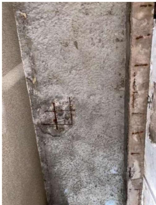
Figura 16: Deslocamento do concreto de cobrimento da viga 246 e laje 267, exposição e corrosão de armaduras
