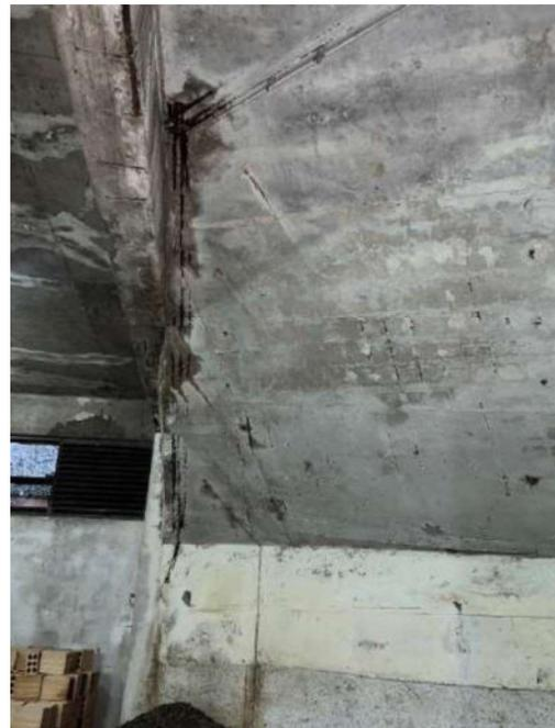
Figura 32: Deslocamento do concreto de cobertura da viga 224 e da laje 281, exposição e corrosão de armaduras
