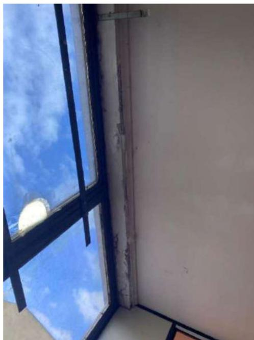
Figura 147: Deslocamento do concreto de cobertura na viga 537
