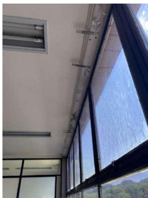
Figura 172: Fissura, deslocamento do concreto de cobrimento e presença de mofo/bolor na viga 501
