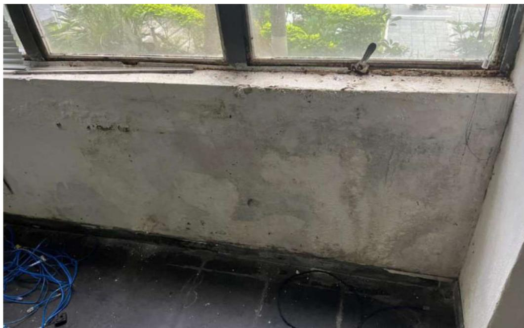
Figura 104: Deslocamento da pintura e presença de umidade na viga 230
