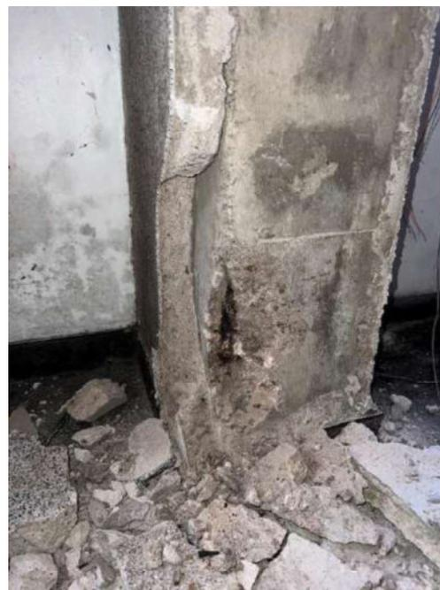
Figura 94: Detalhe - Corrosão do pilar da fachada no pavimento térreo
