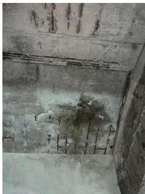
Figura 30: Deslocamento do concreto de cobrimento da laje 281 exposição e corrosão de armaduras
