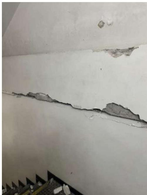
Figura 87: Detalhe - Corrosão de armadura e deslocamento do concreto de cobertura na viga 244 e abaixo dela
