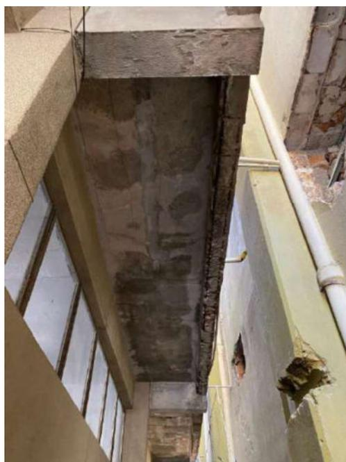
Figura 8: Deslocamento do concreto de cobertura da viga 251 e laje 230, exposição e corrosão de armaduras
