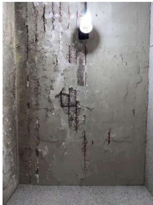
Figura 20: Detalhe - Exposição e corrosão de armaduras na laje 202
