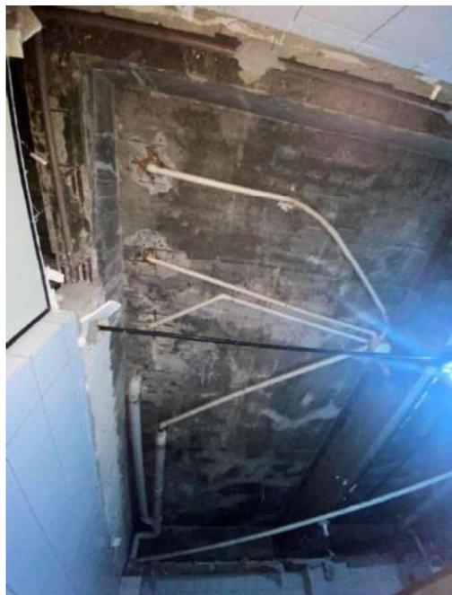
Figura 55: Visão geral - Deslocamento do concreto de cobertura, exposição e corrosão das armaduras na laje 259
