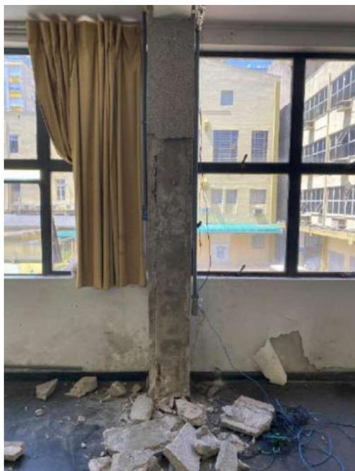
Figura 95: Detalhe - Corrosão de armadura no pilar da fachada pavimento térreo
