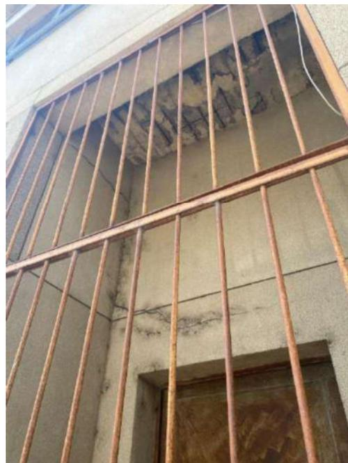
Figura 217: Armadura exposta na laje 201 e 202 e fissuras na alvenaria
