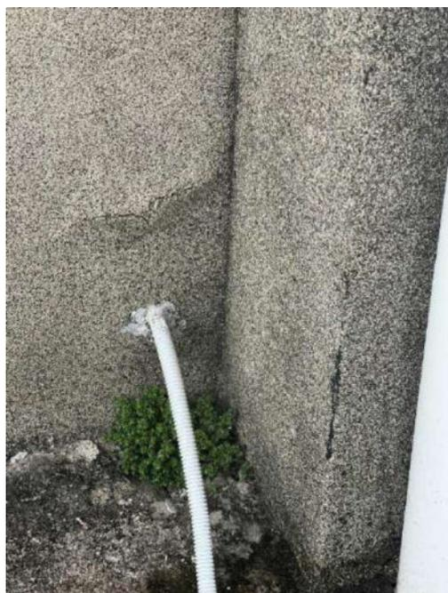
Figura 209: Deslocamento do concreto de cobrimento
