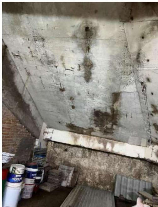
Figura 28: Presença de umidade, Desplacamento do concreto de cobrimento da viga 233 e laje 231, exposição e corrosão de armaduras
