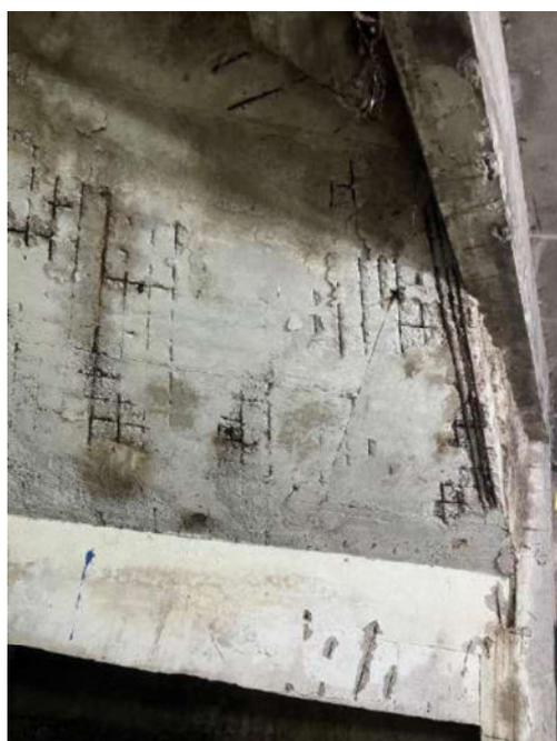
Figura 25: Deslocamento do concreto de cobertura das vigas 240 e 224 e laje 281, exposição e corrosão de armaduras
