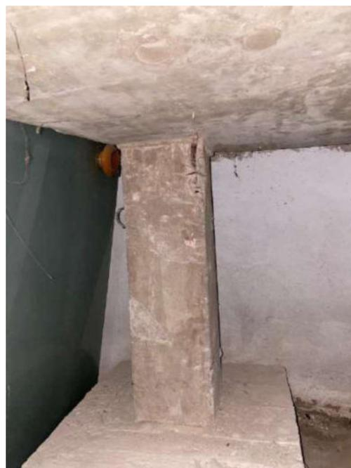
Figura 42: Detalhe - Deslocamento do concreto de cobertura do pilar, exposição e corrosão da armadura
