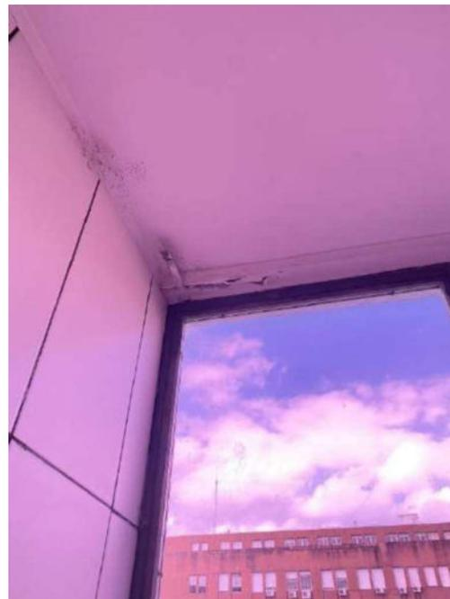
Figura 161: Presença de umidade e deslocamento no forro de gesso na laje 532
