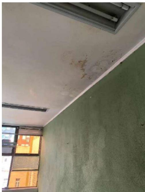
Figura 146: Presença de umidade no forro de gesso
