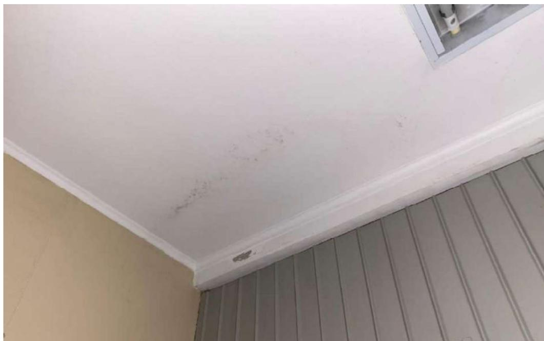
Figura 138: Presença de umidade no forro de gesso na laje 546
