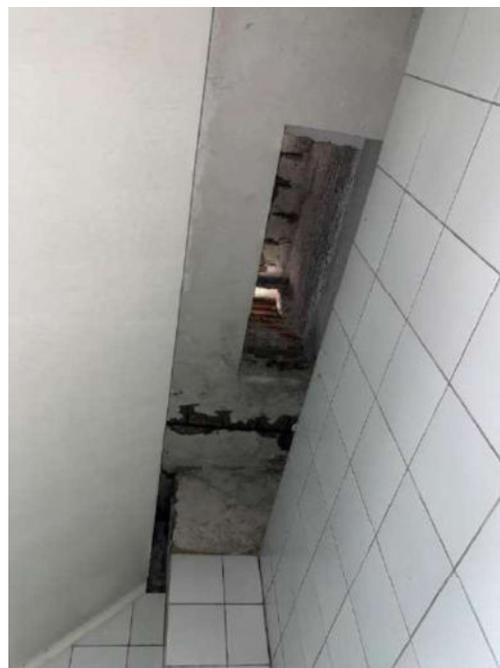
Figura 49: Deslocamento do concreto de cobrimento da laje 242, exposição e corrosão de armaduras
