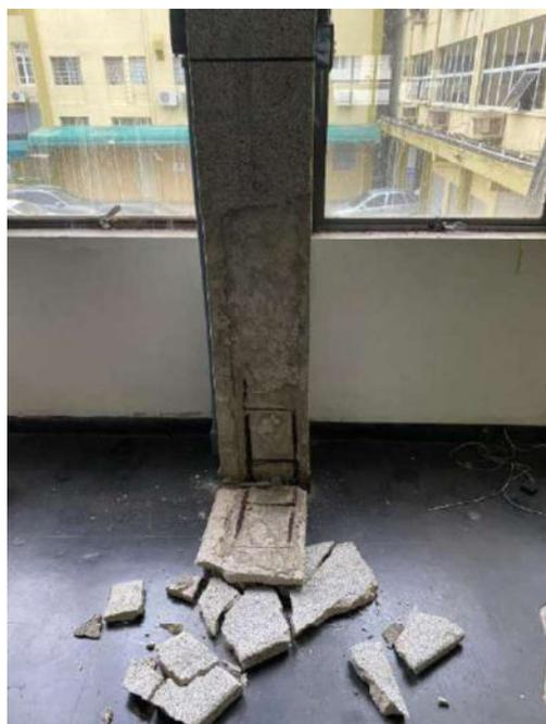
Figura 98: Visão geral - Corrosão de armadura do pilar na fachada pavimento térreo
