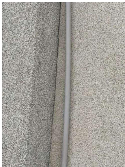
Figura 212: Deslocamento do concreto de cobrimento entre o pilar 03 a alvenaria
