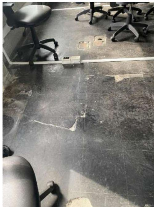
Figura 158: Presença de fissura na laje 433 e 435
