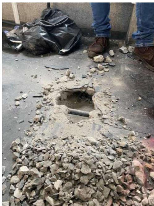
Figura 164: Presença de brita como enchimento na laje
