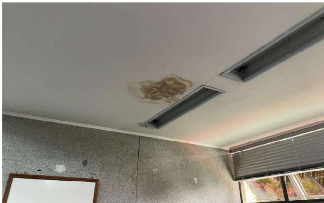
Figura 144: Presença de umidade no forro de gesso na laje 537
