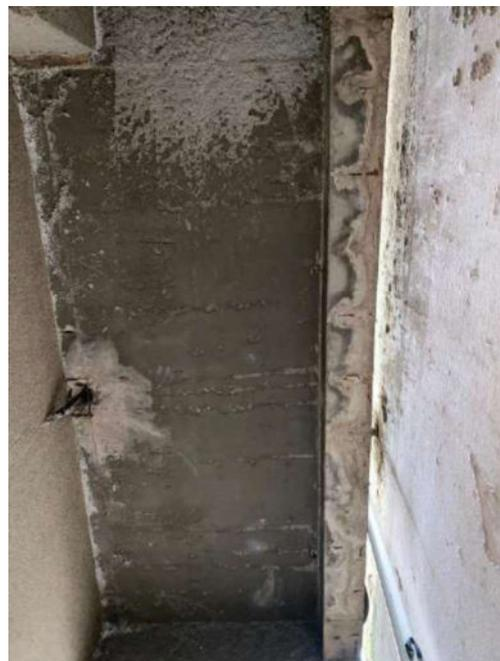
Figura 15: Deslocamento do concreto de cobrimento da viga 246 e laje 267, exposição e corrosão de armaduras
