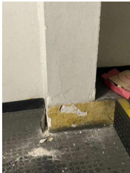
Figura 176: Detalhe - Presença de fissura no pilar 56
