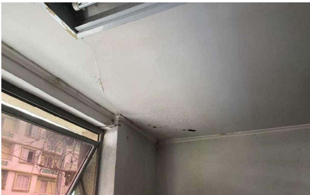
Figura 132: Presença de umidade, fissura e furos no forro de gesso na laje 505
