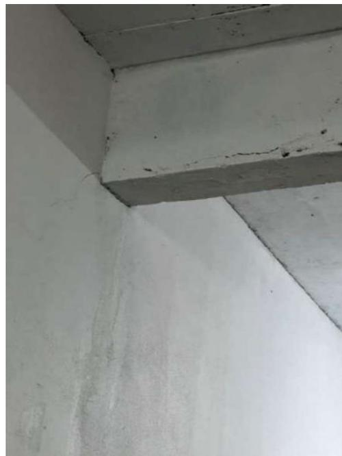
Figura 67: Detalhe - Fissura na viga 209
