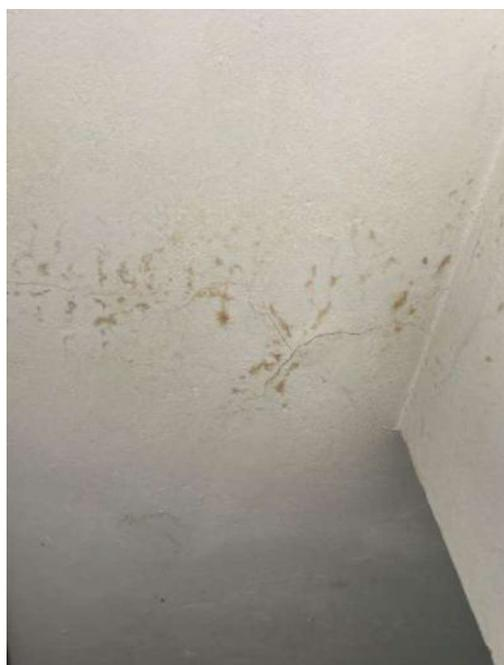
Figura 180: Presença de umidade e de fissuras na laje 703
