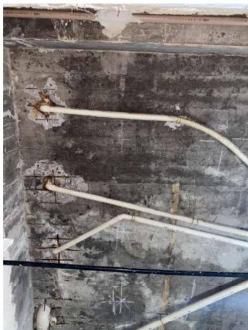
Figura 56: Detalhe - Deslocamento do concreto de cobertura, exposição e corrosão das armaduras na laje 259
