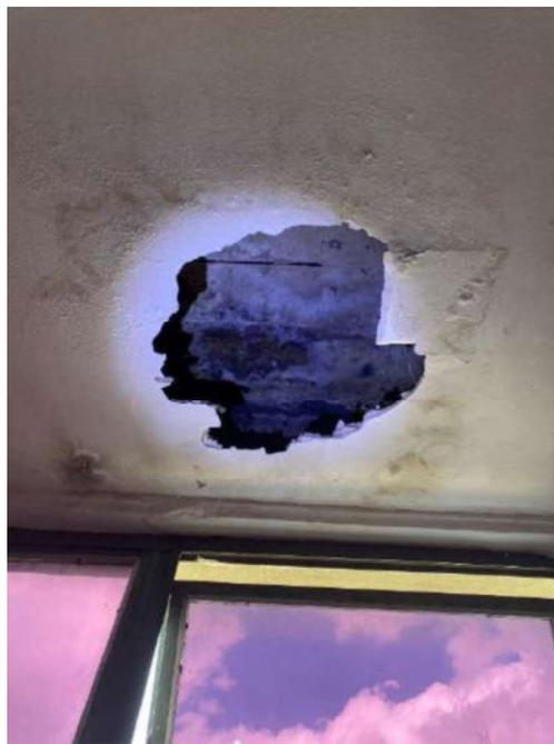
Figura 165: Presença de umidade no forro de gesso, exposição e corrosão de armadura na laje
