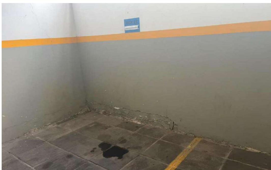
Figura 83: Fissura na viga baldrame no pavimento subsolo (garagem)
