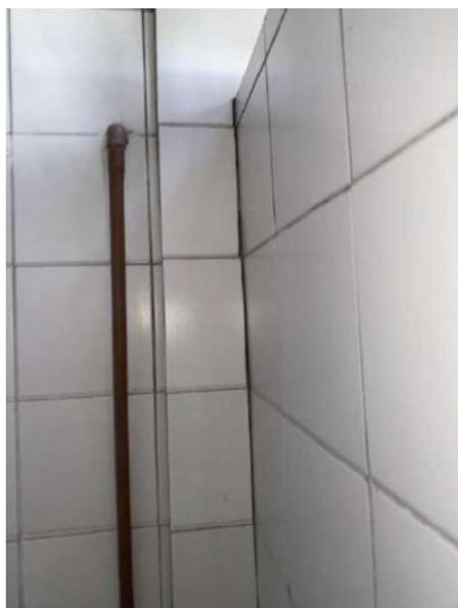
Figura 137: Visão geral: Desplacamento do rejunte
