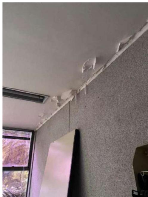
Figura 109: Detalhe - Presença de umidade e deslocamento no forro de gesso na laje 445
