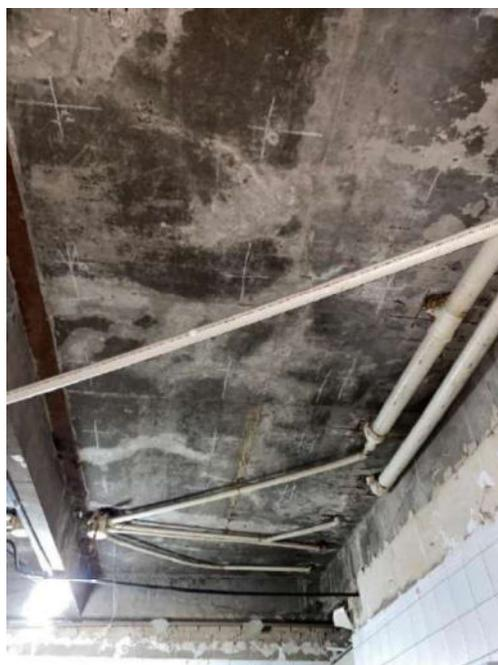
Figura 54: Deslocamento do concreto de cobertura, exposição e corrosão das armaduras na laje 259
