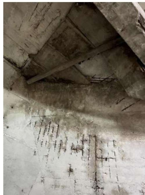
Figura 27: Deslocamento do concreto de cobertura da viga 224 e laje 281, exposição e corrosão de armaduras
