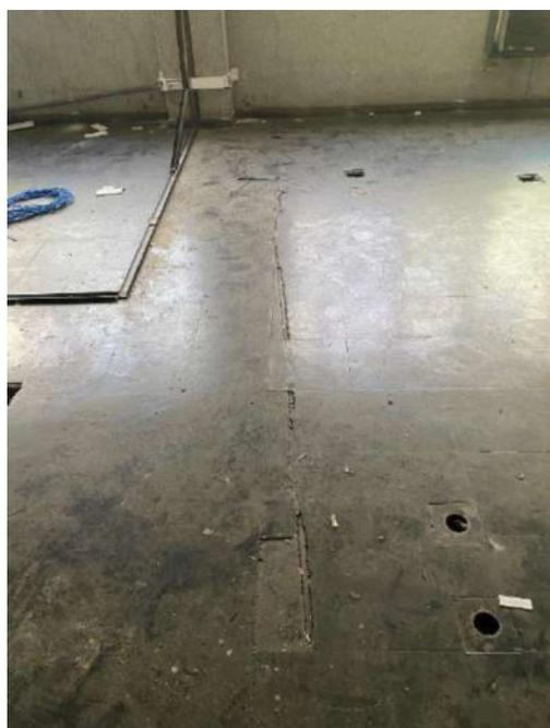
Figura 118: Presença de fissura na laje 336
