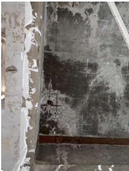
Figura 60: Desplacimento do concreto de cobertura, exposição e corrosão das armaduras na laje
