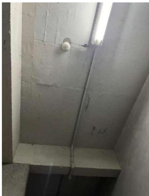
Figura 80: Visão geral - Armadura exposta e deslocamento na laje 216 do pavimento subsolo (garagem)
