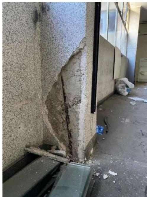
Figura 105: Corrosão de armadura no pilar 31
