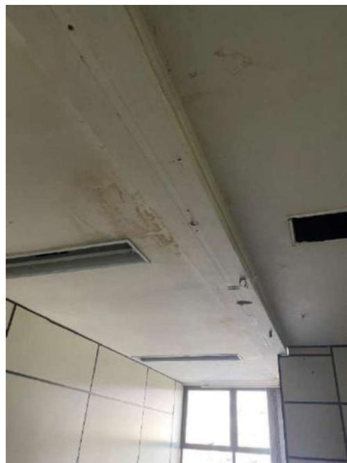
Figura 153: Presença de umidade e deslocamento do concreto de cobertura na viga 512
