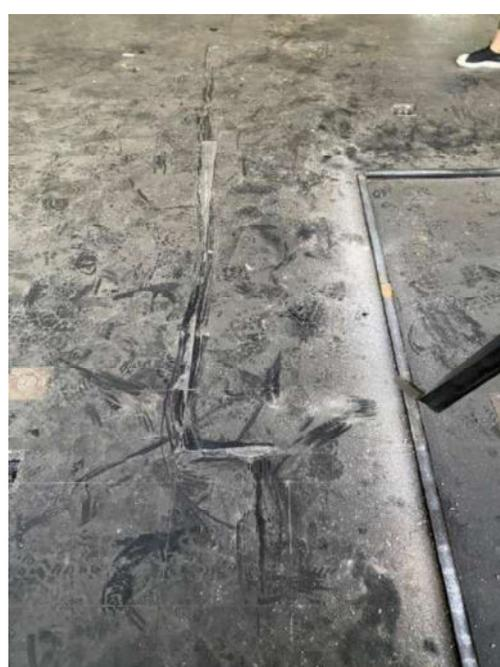
Figura 115: Presença de fissura na laje 336
