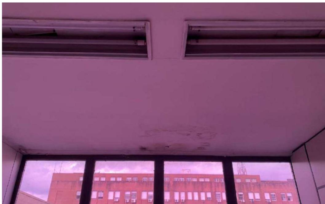
Figura 162: Visão geral - Presença de umidade e furos no forro de gesso na laje 532
