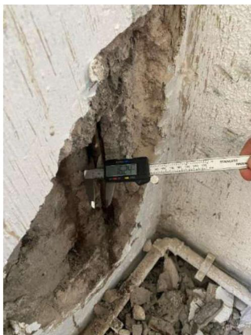
Figura 93: Detalhe - Corrosão e perda de seção da armadura do pilar 82
