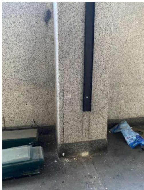
Figura 106: Detalhe – Deslocamento do concreto de cobertura no pilar 31
