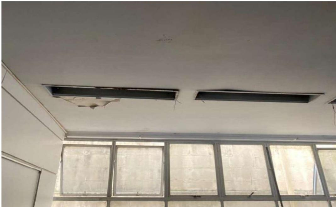
Figura 129: Presença de umidade e deslocamento do forro de gesso na laje 552
