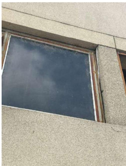
Figura 206: Deslocamento do concreto de cobrimento entre o pilar e a viga, também em relação a esquadria
