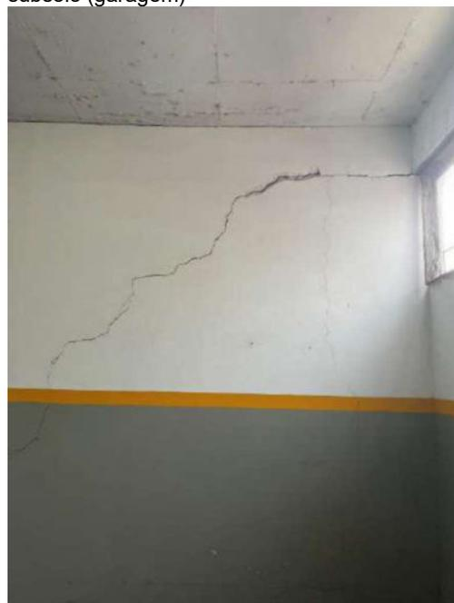
Figura 82: Detalhe - Fissura inclinada na alvenaria no pavimento subsolo (garagem)
