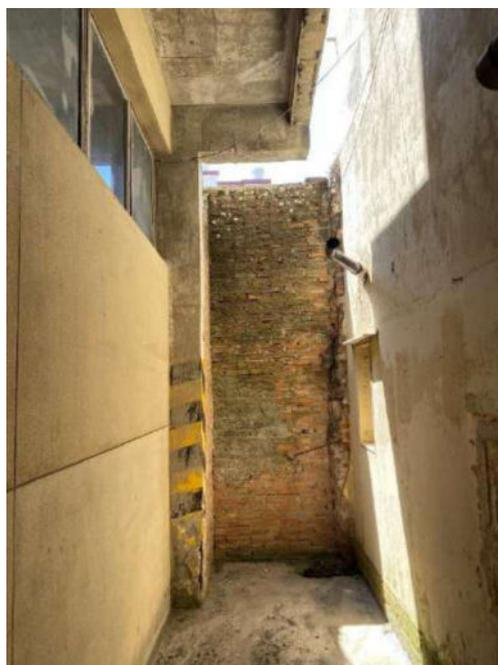
Figura 11: Visão geral - Deslocamento do concreto de cobertura do pilar 2, exposição e corrosão de armaduras
