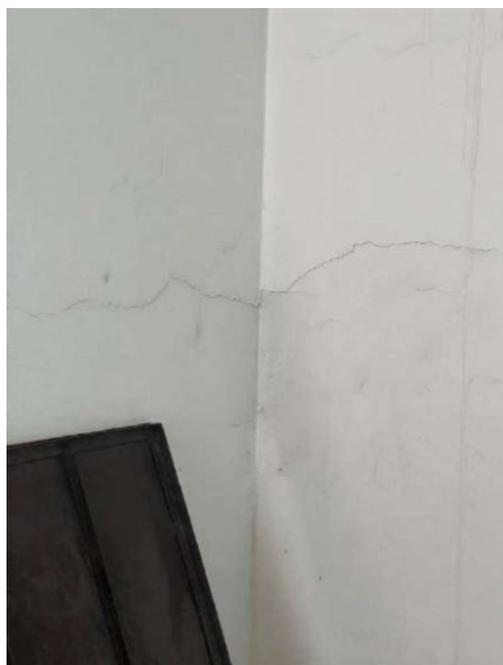
Figura 184: Presença de fissuras na alvenaria
