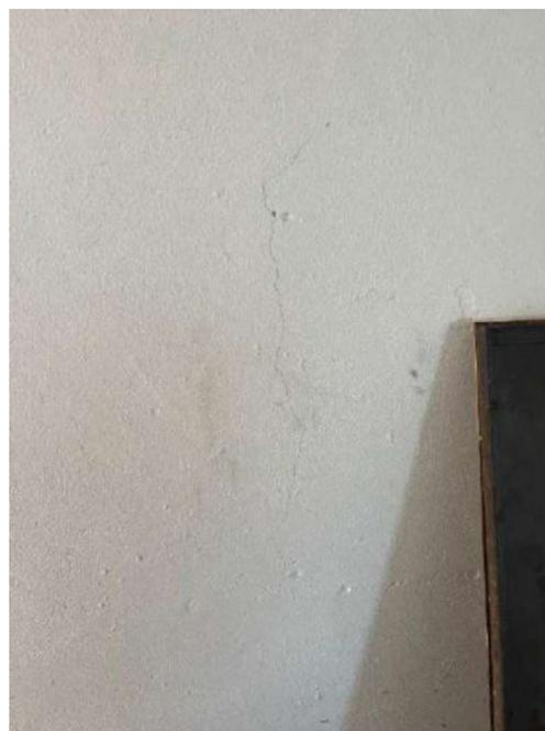
Figura 185: Presença de fissuras na alvenaria
