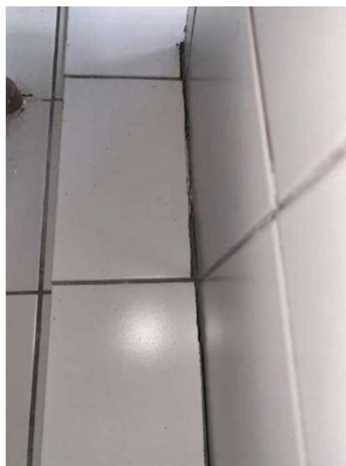
Figura 136: Detalhe - Desplacamento do rejunte
