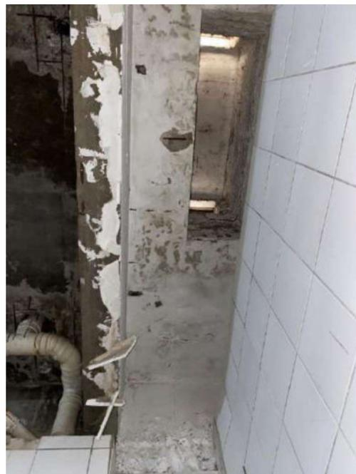
Figura 59: Desplacimento do concreto de cobertura, exposição e corrosão das armaduras nas lajes
