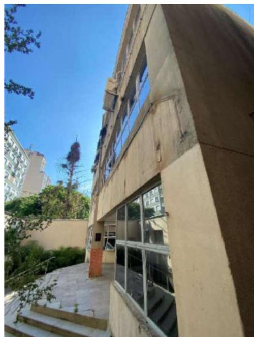
Figura 191: Detalhe - Presença de mofo/bolor na fachada principal
