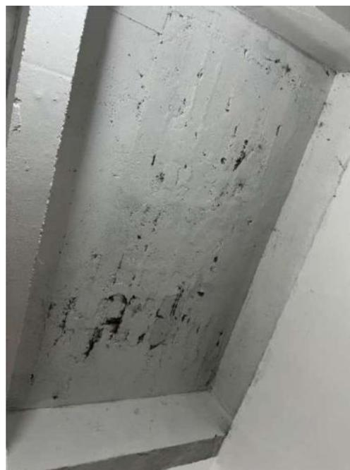
Figura 73: Armadura exposta e nicho de concretagem na laje 234 do pavimento subsolo (garagem)
