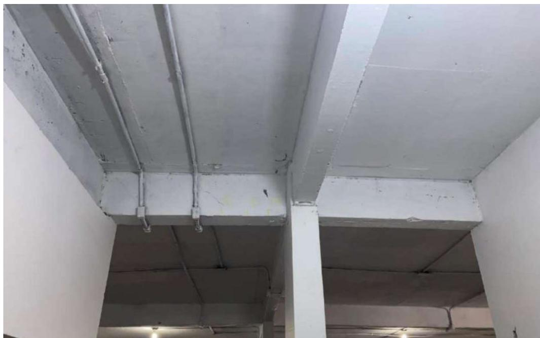
Figura 65: Fissuras inclinadas na viga 204 e armadura exposta e corroída do pavimento subsolo (garagem)
