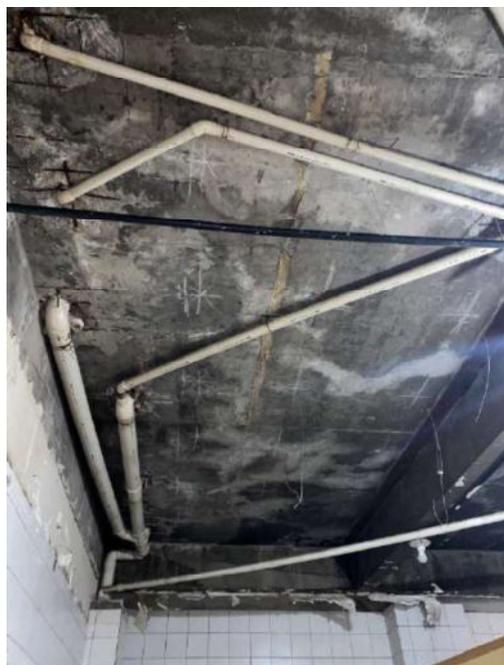
Figura 53: Deslocamento do concreto de cobertura, exposição e corrosão das armaduras na laje 259
