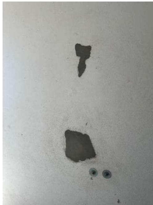
Figura 178: Presença de reparos na laje de cobertura 705
