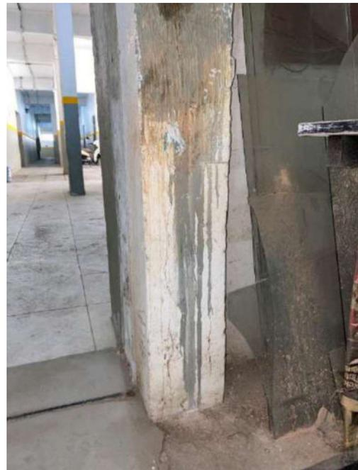
Figura 47: Detalhe - Presença de fissuras no pilar 63
