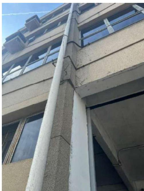
Figura 202: Trinca, deslocamento do concreto de cobertura no pilar da fachada exterior
