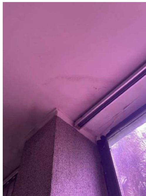
Figura 107: Detalhe - Presença de umidade e deslocamento no forro de gesso na laje 449
