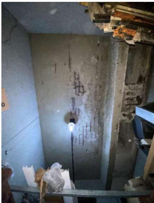
Figura 19: Visão geral - Exposição e corrosão de armaduras nas lajes 201 e 202
