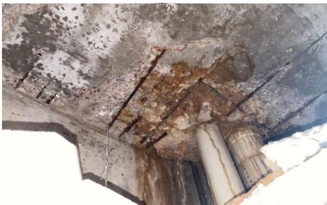
Figura 123: Exposição e corrosão de armaduras na laje 427
