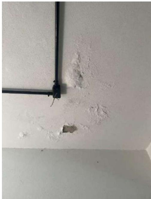
Figura 179: Presença de umidade na laje de cobertura 703
