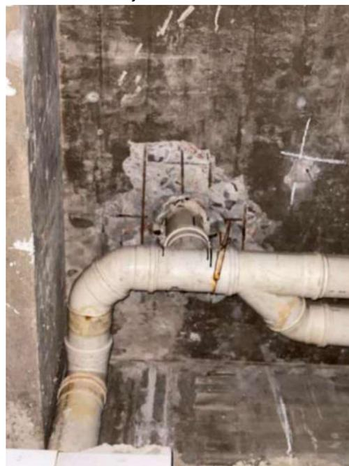
Figura 57: Detalhe - Desplacimento do concreto de cobertura, exposição e corrosão das armaduras nas lajes
