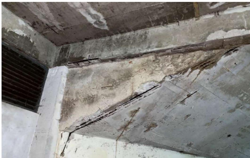
Figura 26: Deslocamento do concreto de cobertura da viga 224 e lajes, exposição e corrosão de armaduras
