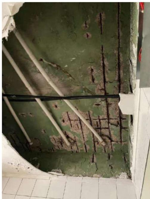
Figura 112: Deslocamento do concreto de cobertura, exposição e corrosão de armadura na laje 439
