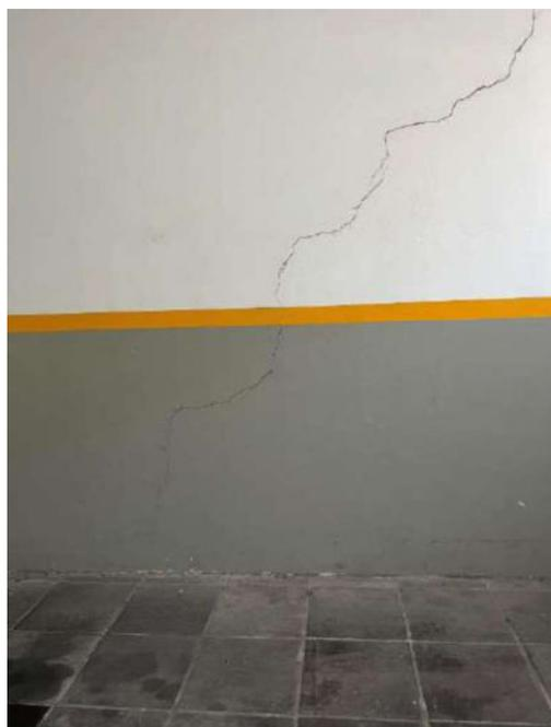
Figura 84: Detalhe – Fissura na alvenaria do pavimento subsolo (garagem)
