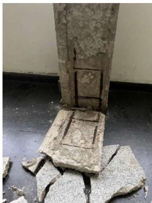
Figura 97: Detalhe - Corrosão de armadura do pilar na fachada pavimento térreo
