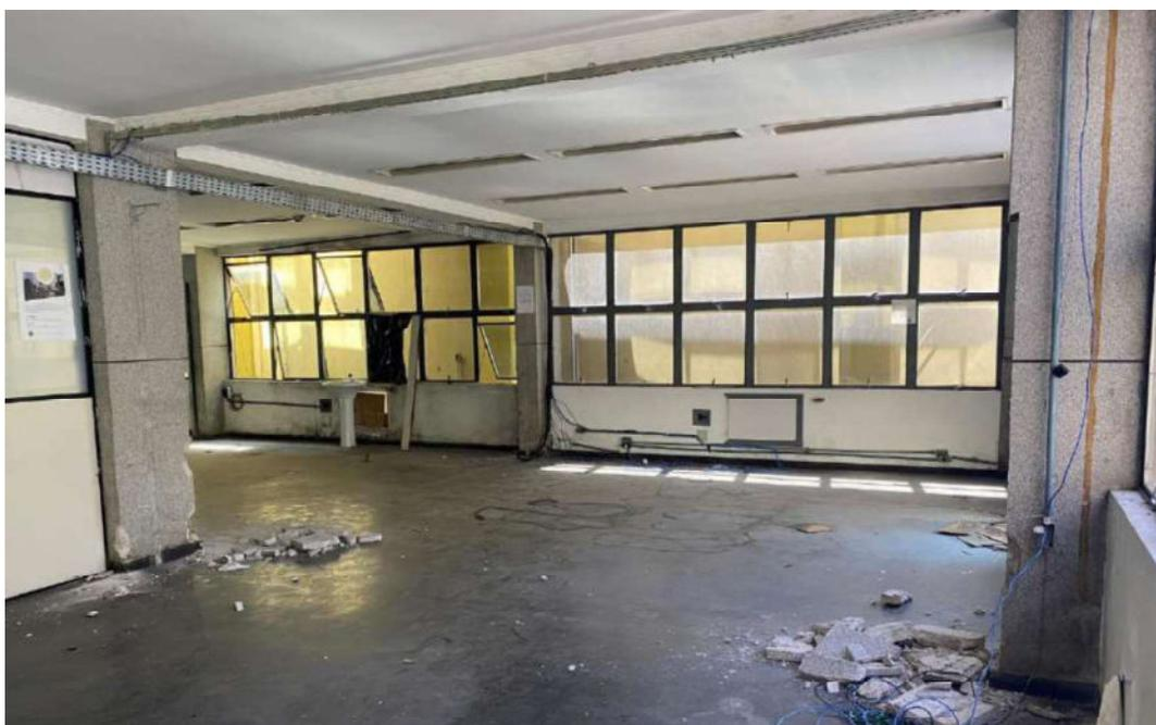
Figura 91: Visão geral - Revestimento de pilar removido para inspeção e constatação de corrosão de armadura nos pilares 31 e 22
