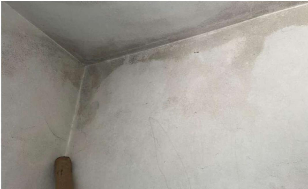
Figura 187: Presença de umidade e mofo/bolor na alvenaria e laje de cobertura
