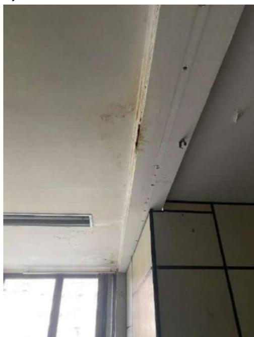
Figura 154: Presença de umidade, fissura e deslocamento do concreto de cobertura na viga 512
