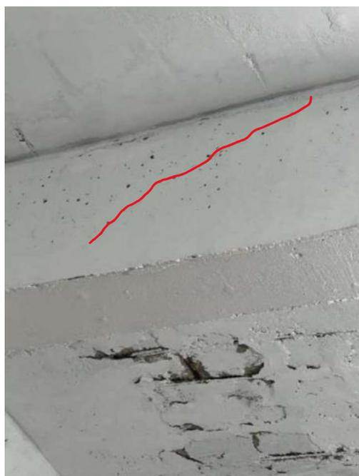
Figura 72: Detalhe: Fissura na viga 207 e armadura exposta na laje 234 do pavimento subsolo (garagem)
