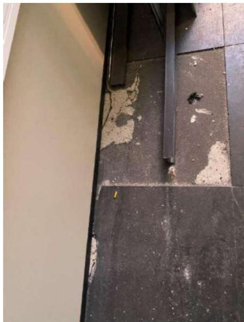
Figura 156: Presença de fissura e deslocamento do concreto de cobertura na laje 436
