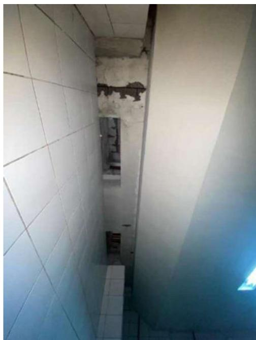
Figura 50: Deslocamento do concreto de cobrimento da laje 242, exposição e corrosão de armaduras
