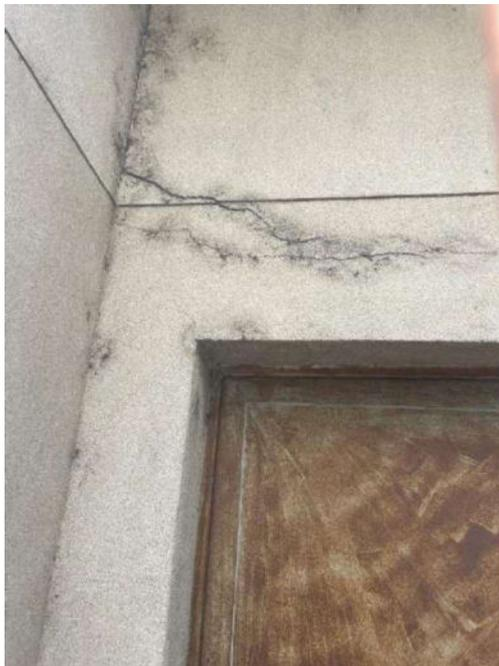
Figura 219: Trinca e deslocamento do concreto de cobertura na alvenaria
