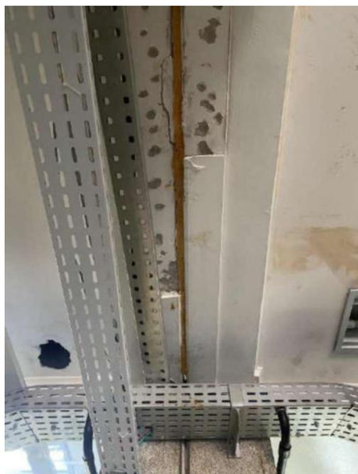
Figura 150: Deslocamento do concreto de cobrimento na junta
