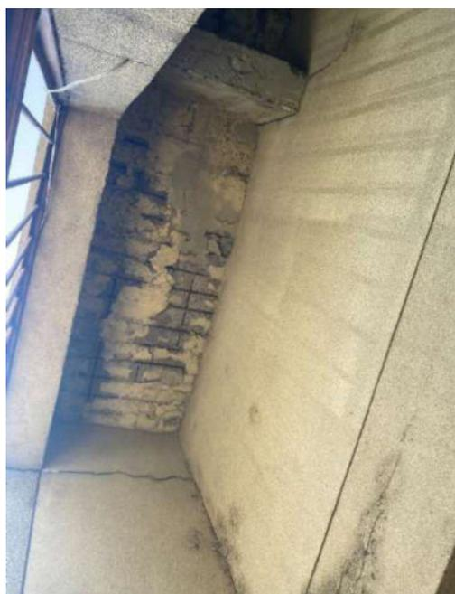
Figura 216: Armadura exposta na laje 201 e 202 e trinca na alvenaria
