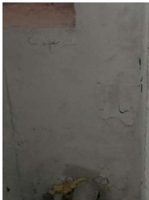
Figura 75: Deslocamento do concreto de cobertura na laje 209 do pavimento subsolo (garagem)
