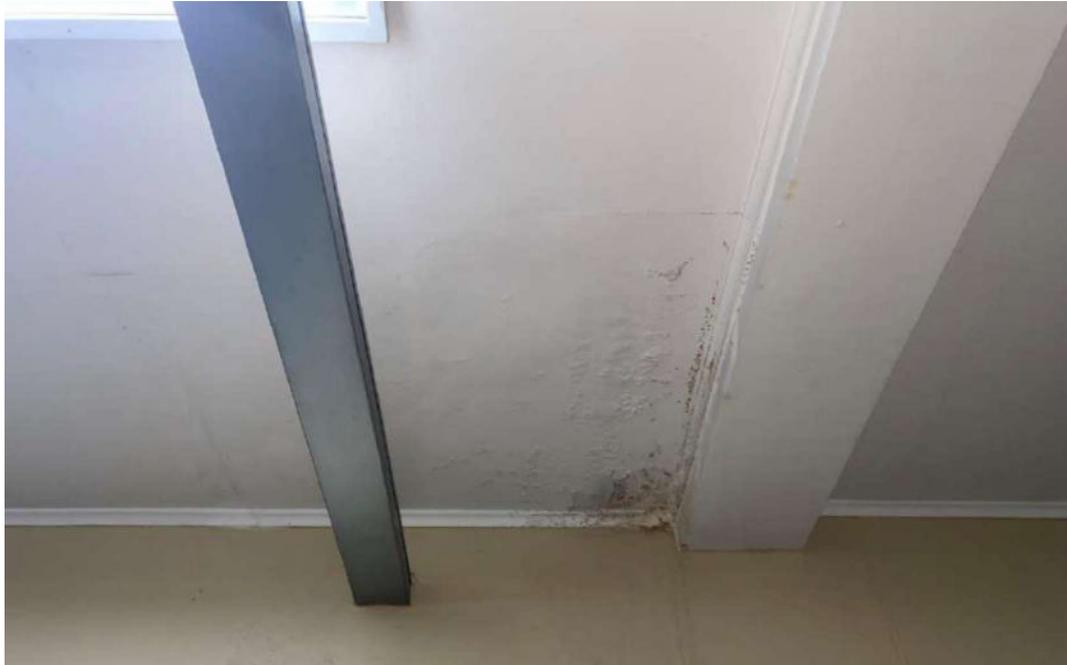
Figura 141: Presença de umidade no forro de gesso na laje 542
