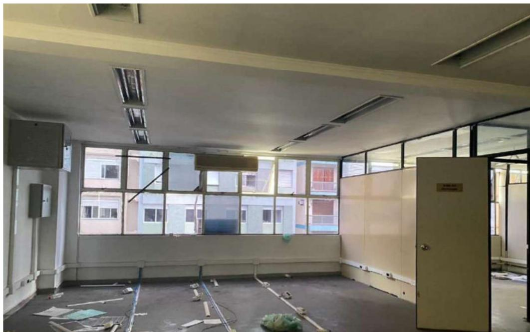
Figura 128: Visão geral - Presença de umidade no forro de gesso na laje 501
