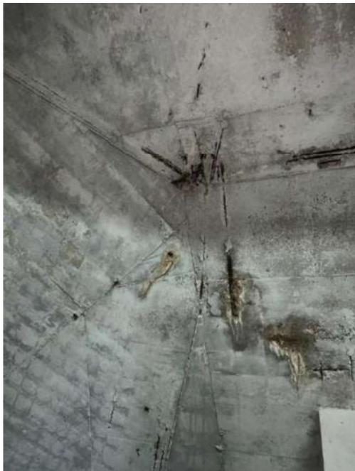
Figura 33: Deslocamento do concreto de cobertura da laje 281, exposição e corrosão de armaduras
