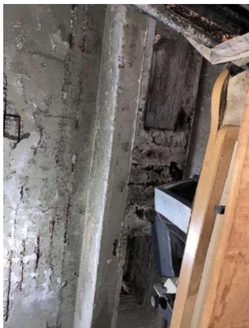
Figura 17: Detalhes - Exposição e corrosão de armaduras nas lajes 201 e 202
