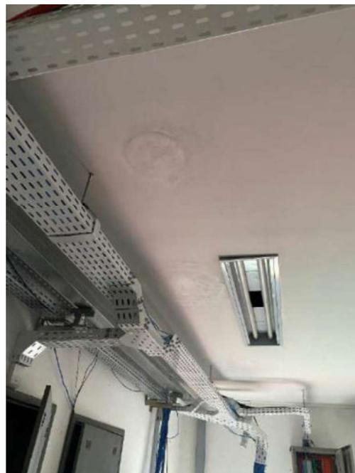
Figura 122: Presença de umidade no forro de gesso laje 429
