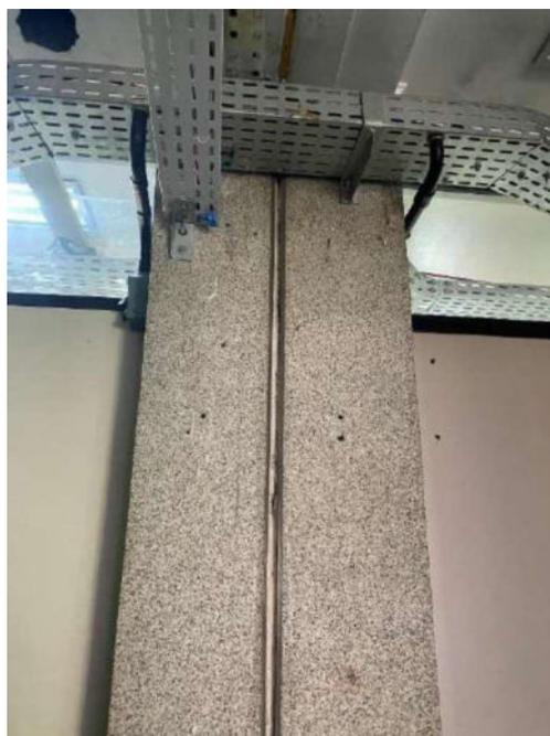
Figura 152: Deslocamento do concreto de cobrimento na junta
