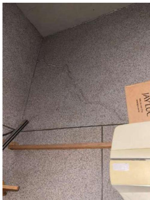
Figura 13: Detalhe - Fissura na alvenaria
