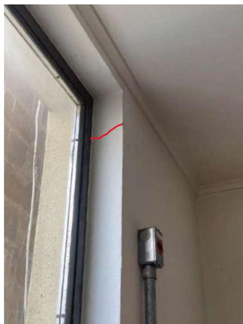
Figura 113: Presença de fissura na alvenaria
