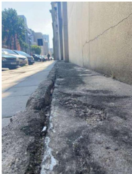
Figura 218: Deformação na calçada adjacente a alvenaria que apresenta fissuras
