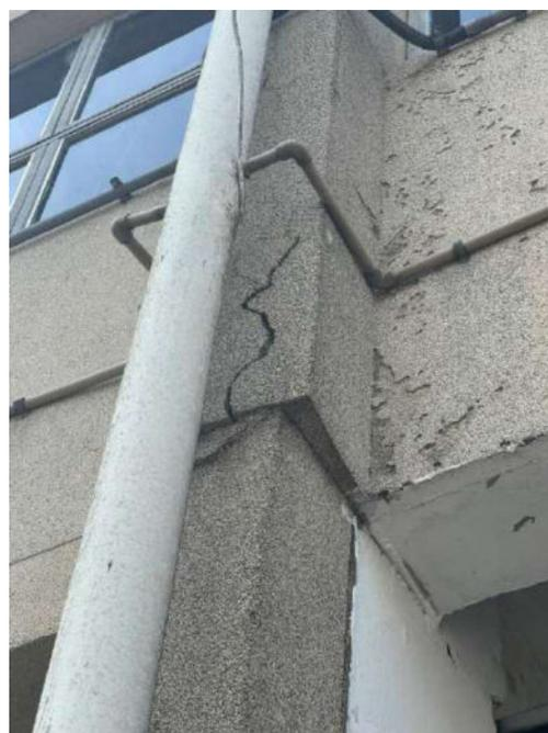
Figura 203: Detalhe – Trinca, deslocamento do concreto de cobertura no pilar da fachada
