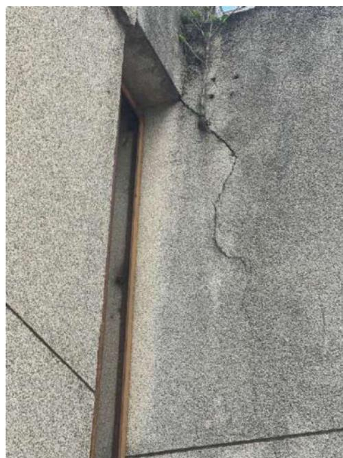
Figura 210: Detalhe - Deslocamento do concreto de cobrimento entre a viga 231 e o pilar 01 e fissura no muro próximo ao pilar e viga
