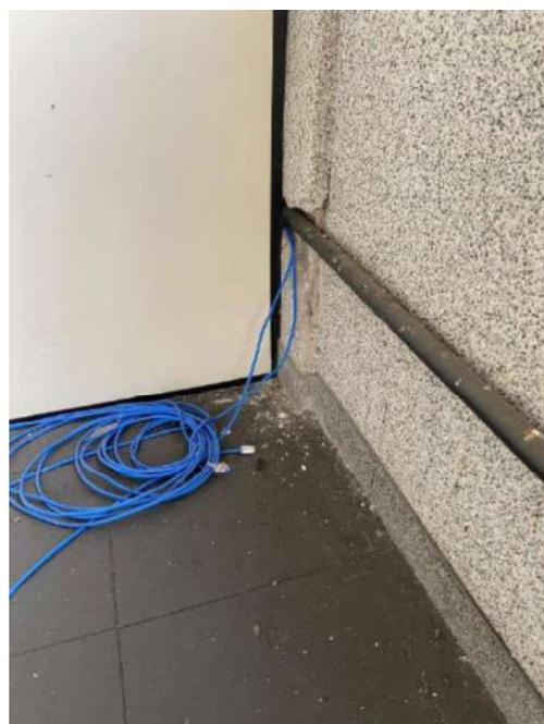
Figura 168: Falha no acabamento do pilar ao passar o eletroduto
