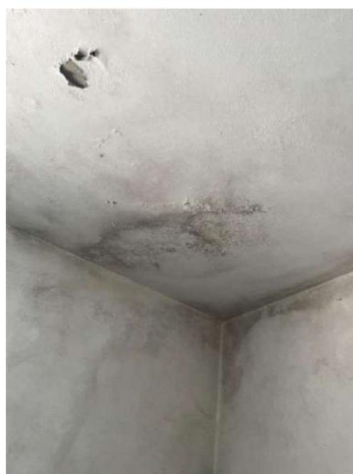
Figura 182: Presença de umidade e fissuras na laje
