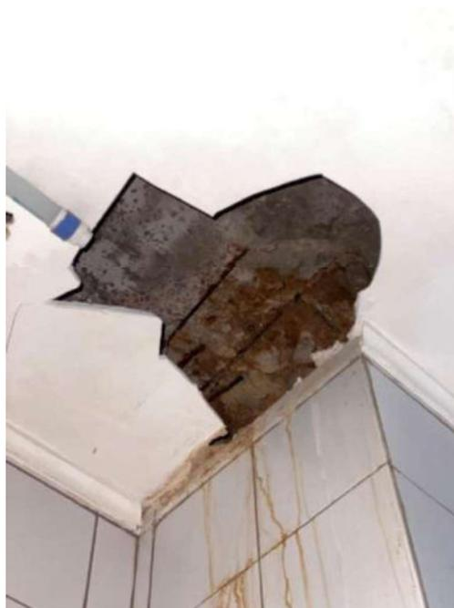
Figura 124: Exposição e corrosão das armaduras na laje 427
