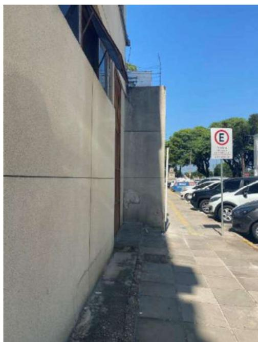
Figura 211: Fissura na alvenaria em relação a viga baldrame e no muro próximo ao pilar e viga
