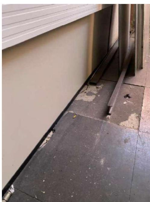
Figura 149: Presença de fissura e deslocamento do concreto de cobrimento na laje 436
