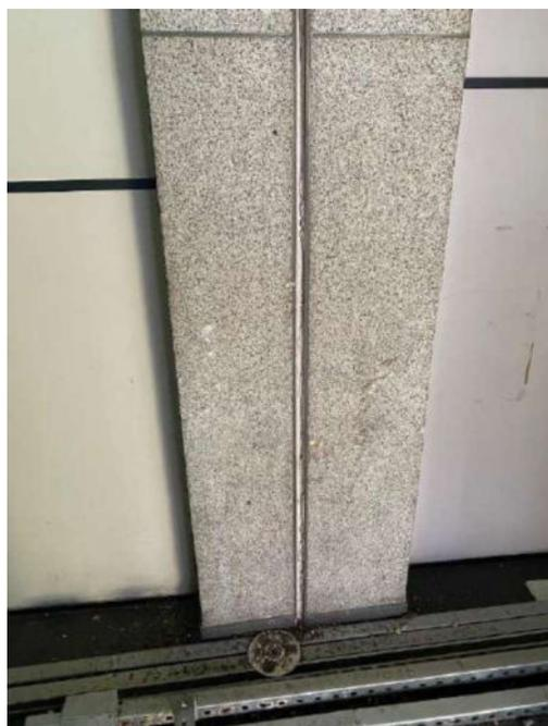
Figura 151: Deslocamento do concreto de cobrimento na junta
