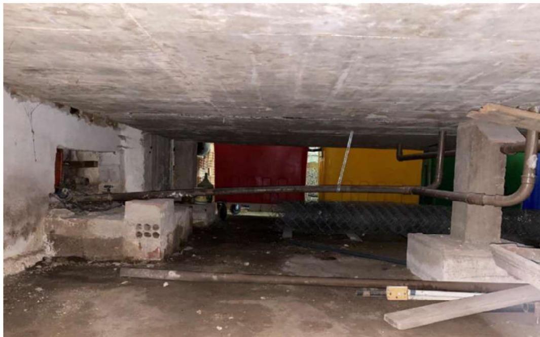
Figura 44: Deslocamento do concreto de cobertura da laje, exposição e corrosão de armaduras
