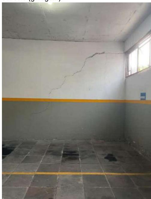
Figura 81: Visão geral - Fissura inclinada na alvenaria no pavimento subsolo (garagem)
