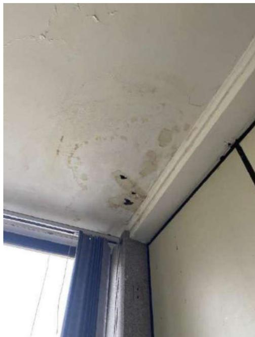
Figura 157: Presença de umidade e furos no forro de gesso
