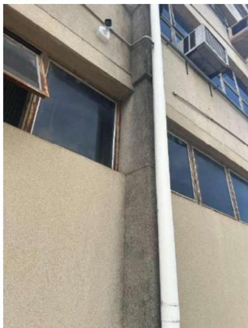
Figura 207: Visão geral – Presença de mofo/bolor, deslocamento do concreto de cobrimento entre a viga e alvenaria
