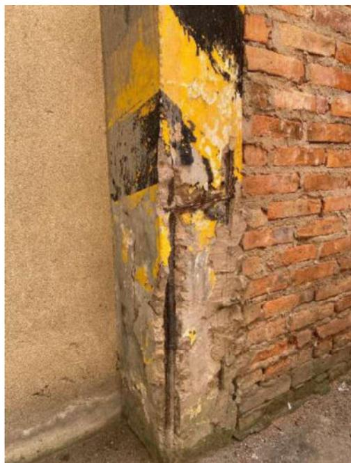
Figura 9: Detalhe - Deslocamento do concreto de cobertura do pilar 2, exposição e corrosão de armaduras
