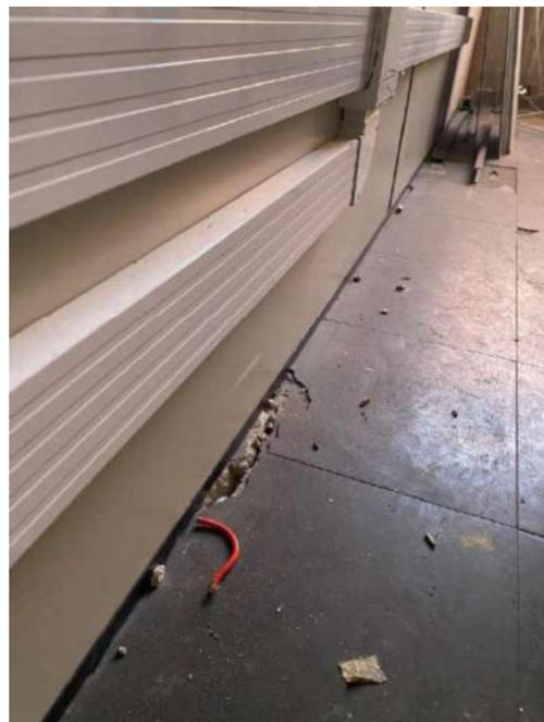
Figura 155: Deslocamento do concreto de cobertura na laje 436
