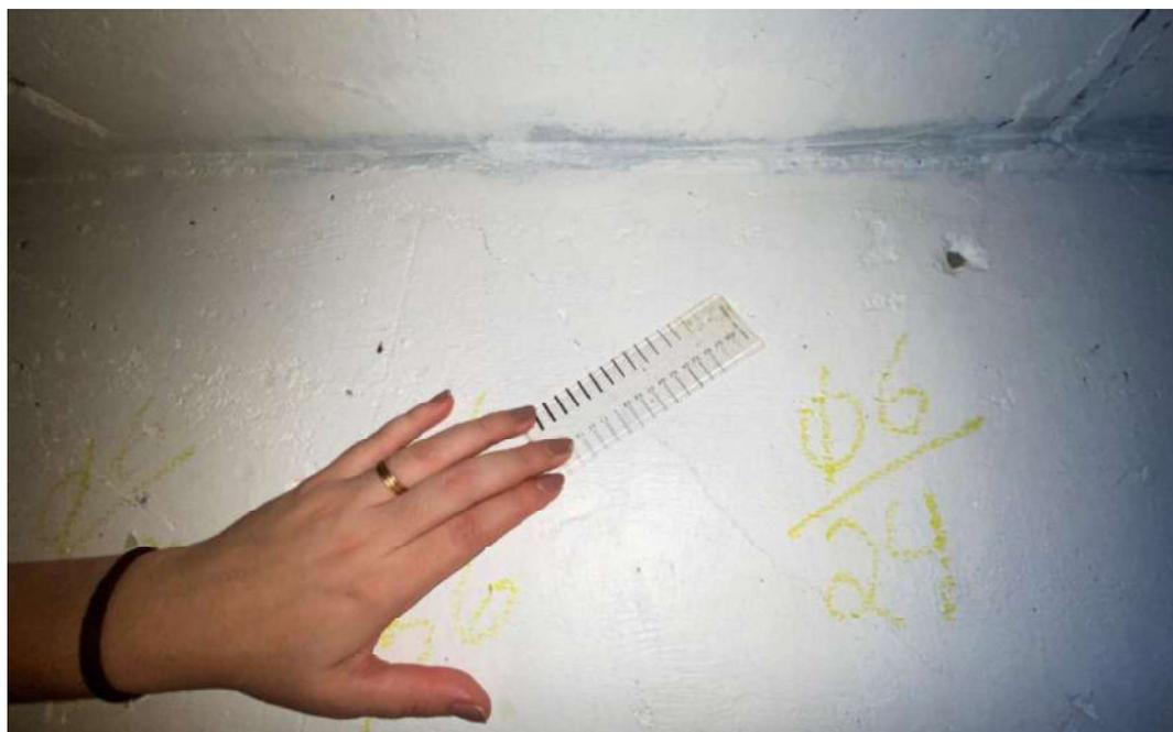
Figura 74: Detalhe - Fissura com abertura de 1 mm na viga 203
