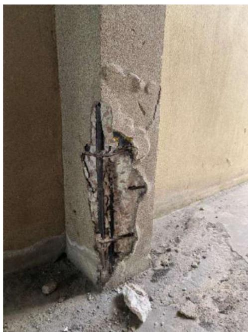
Figura 10: Deslocamento do concreto de cobertura do pilar 56, exposição e corrosão de armaduras
