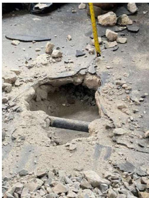
Figura 166: Presença de brita como enchimento na laje
