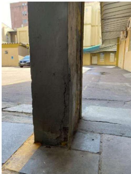
Figura 6: Detalhe - Deslocamento do concreto de cobertura do pilar 53
