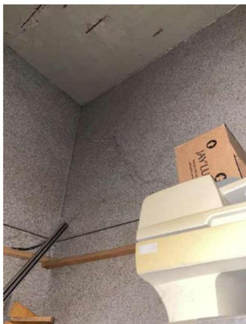
Figura 14: Visão geral - Fissura na alvenaria e exposição e corrosão de armaduras da laje 202
