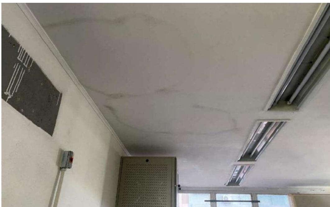
Figura 127: Detalhe - Presença de umidade no forro de gesso na laje 501
