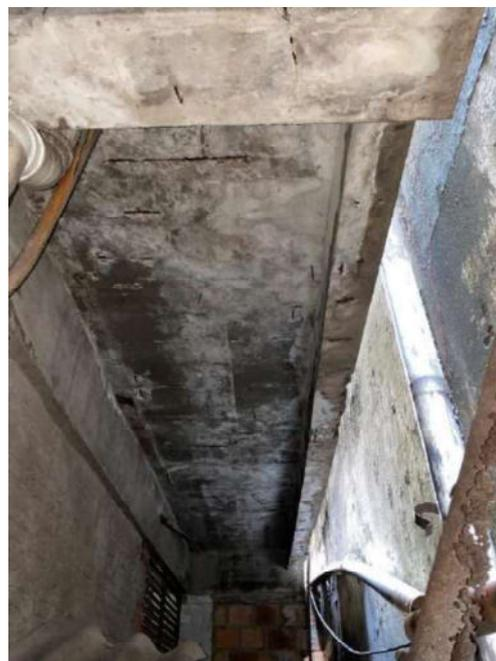
Figura 18: Deslocamento do concreto de cobertura da viga 246 e laje 280, exposição e corrosão de armaduras
