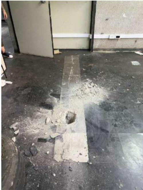
Figura 139: Presença de fissura na laje 437
