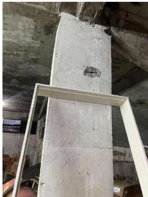
Figura 31: Presença de fissura no pilar 85, deslocamento do concreto de cobrimento, exposição e corrosão de armadura
