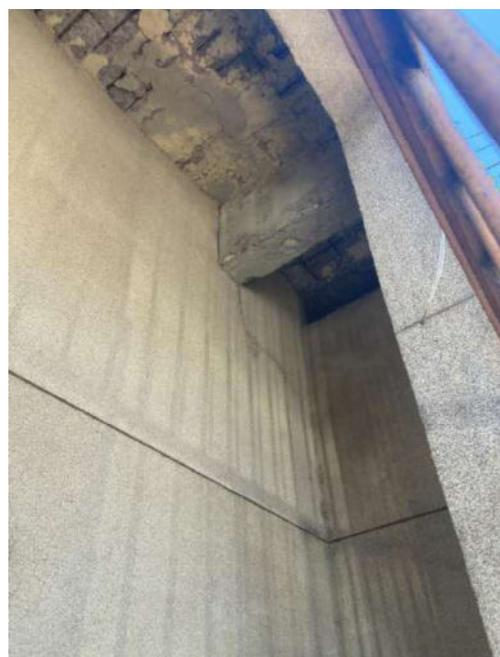
Figura 215: Armadura exposta na laje 201 e 202 e fissura na alvenaria
