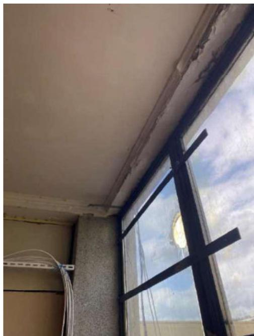
Figura 148: Fissura e deslocamento do concreto de cobertura na viga 537
