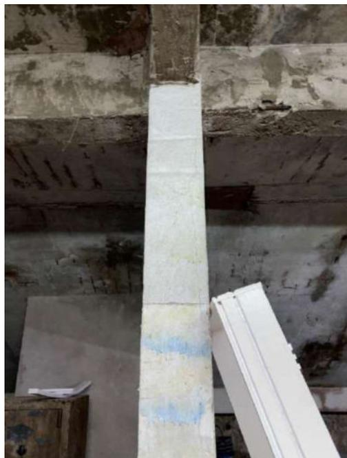
Figura 51: Presença de fissura no pilar 85, deslocamento do concreto de cobrimento da viga e lajes, exposição e corrosão de armaduras
