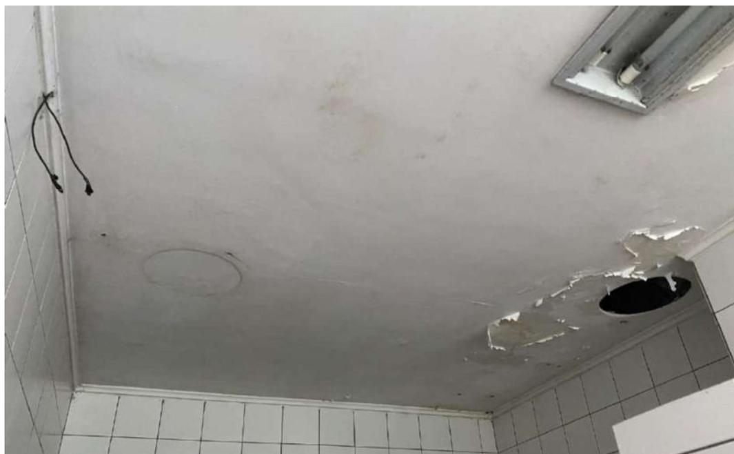
Figura 114: Presença de umidade e deslocamento no forro de gesso na laje 341
