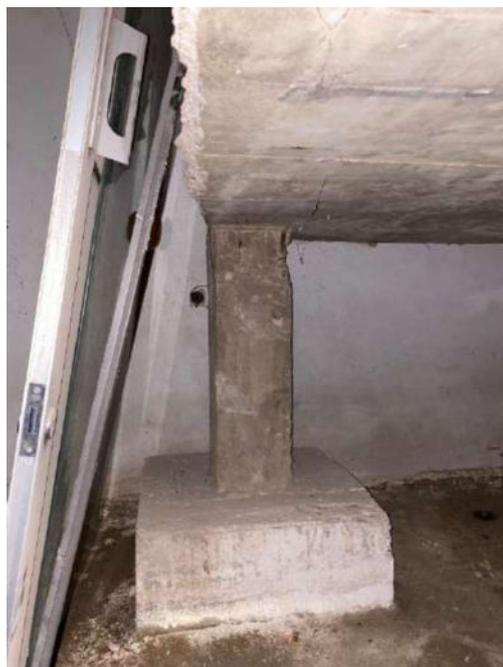
Figura 43: Visão geral - Deslocamento do concreto de cobertura do pilar, exposição e corrosão da armadura
