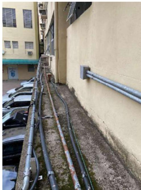
Figura 200: Marquise com presença de lodo e fissuras na impermeabilização
