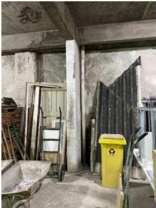
Figura 39: Visão geral - Deslocamento do concreto de cobertura, exposição e corrosão de armadura no pilar 67
