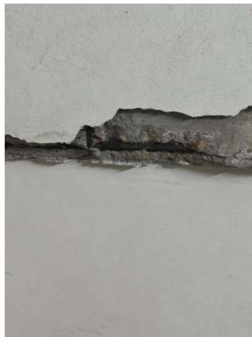
Figura 86: Detalhe - Corrosão de armadura na viga 244
