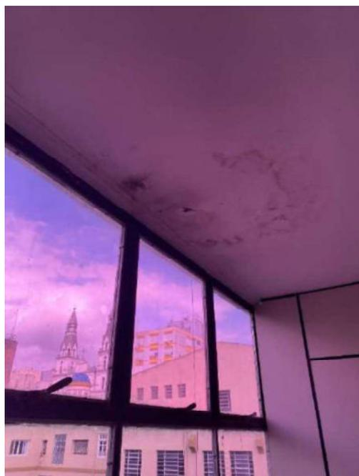
Figura 163: Detalhe - Presença de umidade e furos no forro de gesso na laje 532
