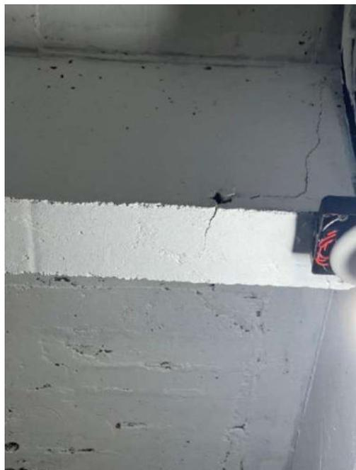
Figura 78: Fissura na viga 207 e nicho de concretagem na laje do pavimento subsolo (garagem)
