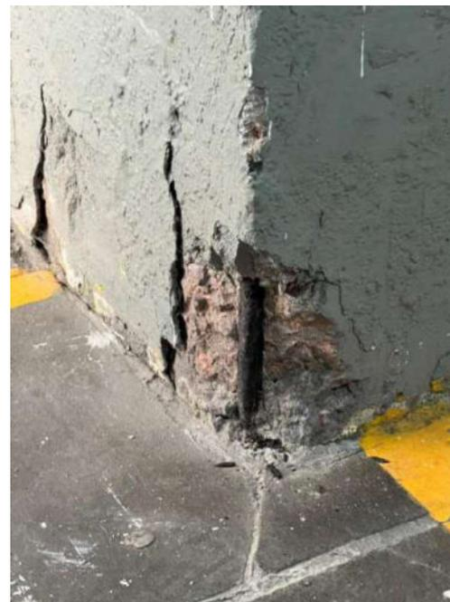
Figura 1: Detalhe - Deslocamento do concreto de cobertura, exposição e corrosão da armadura na base do pilar 51 do pavimento subsolo
