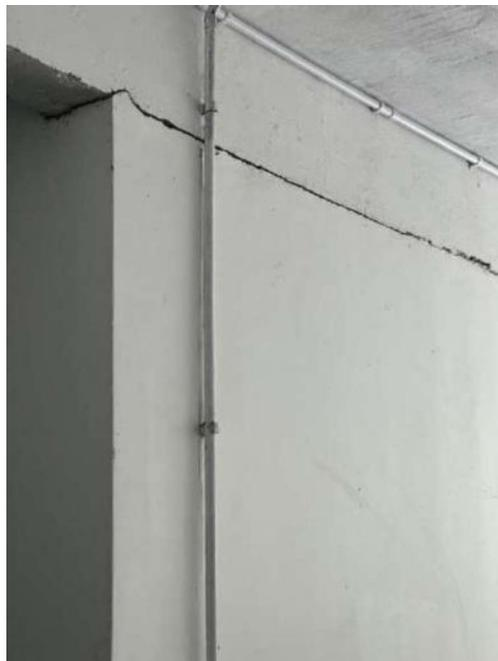
Figura 3: Detalhe - Deslocamento do concreto de cobertura da viga 215 em relação a alvenaria
