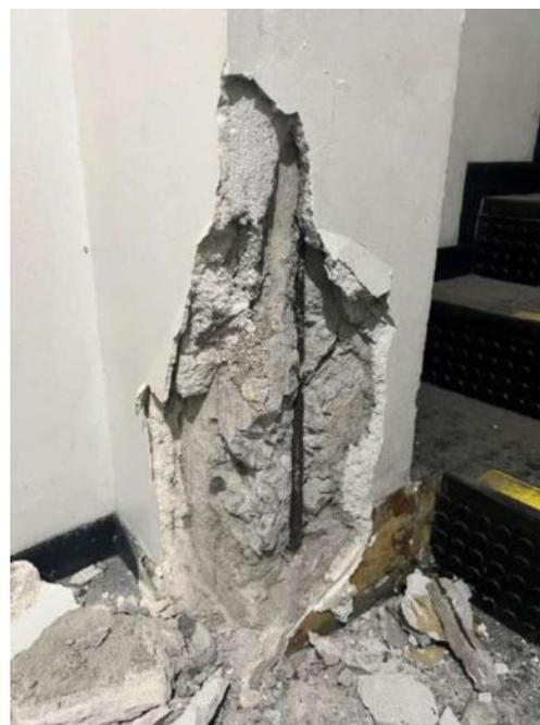
Figura 103: Detalhe - Corrosão de armadura no pilar 56 da escada
