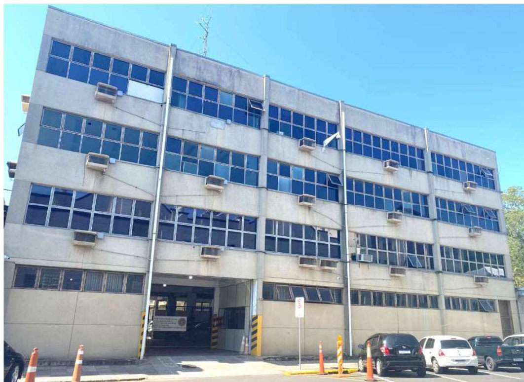
Figura 20: Fachada posterior, presença de lodo.
