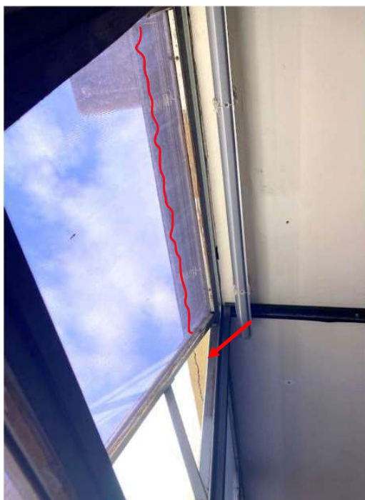
Figura 22: Presença de fissura em viga perimetral, ocasionada por expansão de armadura.
