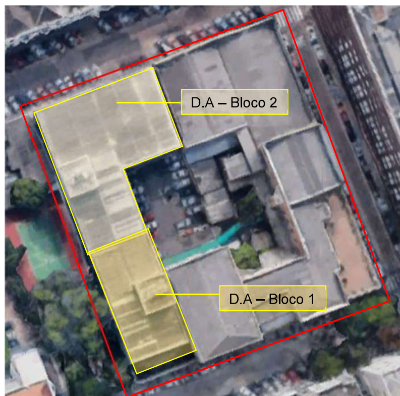
Figura 1: Quartel Geral do Comando da Brigada Militar em vermelho e prédio do Departamento Administrativo em amarelo (objeto do laudo).
