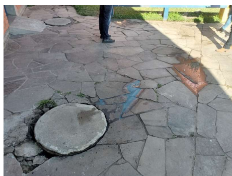
Fig.5,6,7) Esgoto “aberto” dentro da cozinha, apresenta problemas de transbordamento.
