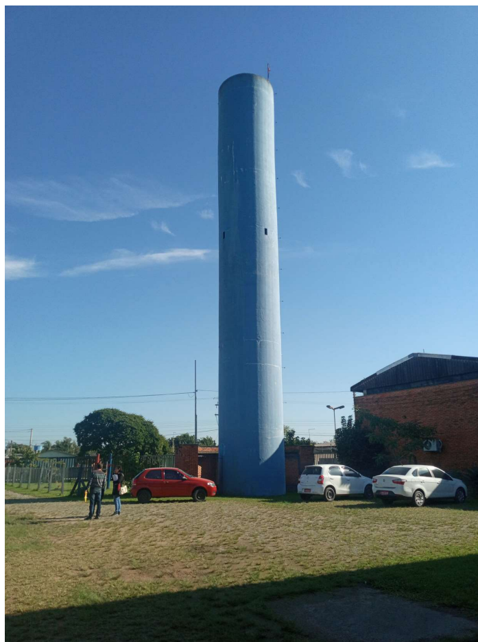
Fig.2) Vista do reservatório existente
