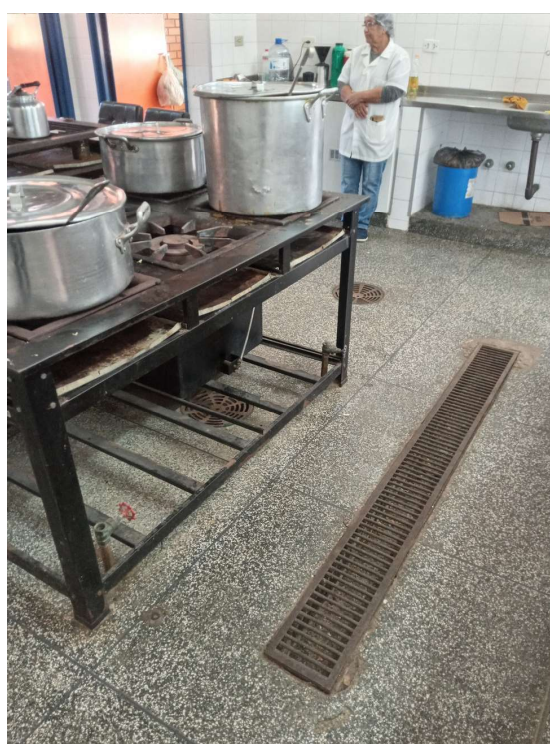
Fig.5,6,7) Esgoto “aberto” dentro da cozinha, apresenta problemas de transbordamento.
