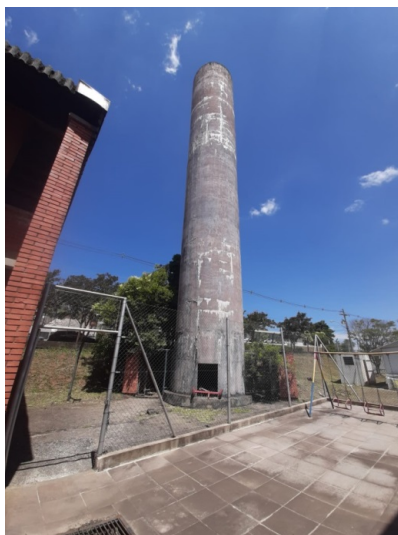
Fig2 Vista do reservatório existente
