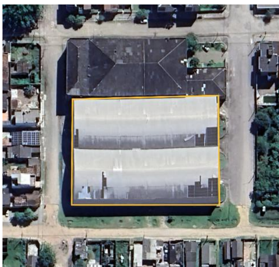
Figura 1: Local para recuperação do telhado.
