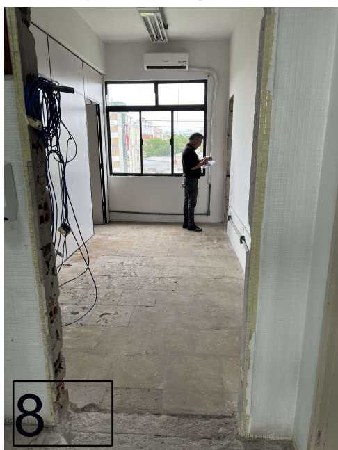
Sala maior à direita – piso removido
