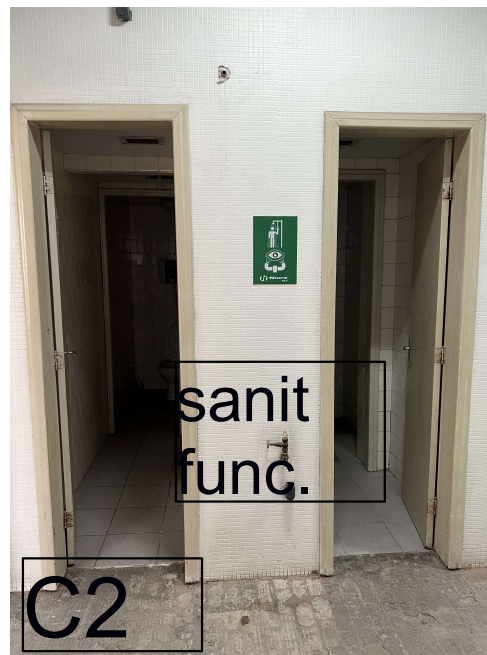
Banheiros do corredor (à direita) – piso cerâmico
