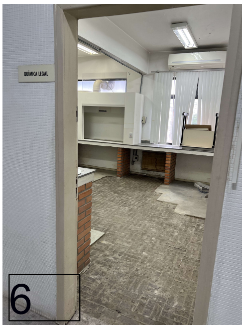
Segunda sala à direita – piso removido
