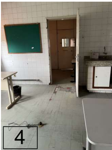
Primeira sala à direita – piso vinílico
