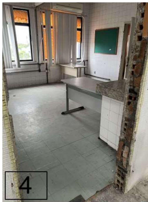
Primeira sala à direita – piso vinílico
