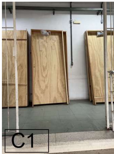
Vista aproximada – piso vinílico
