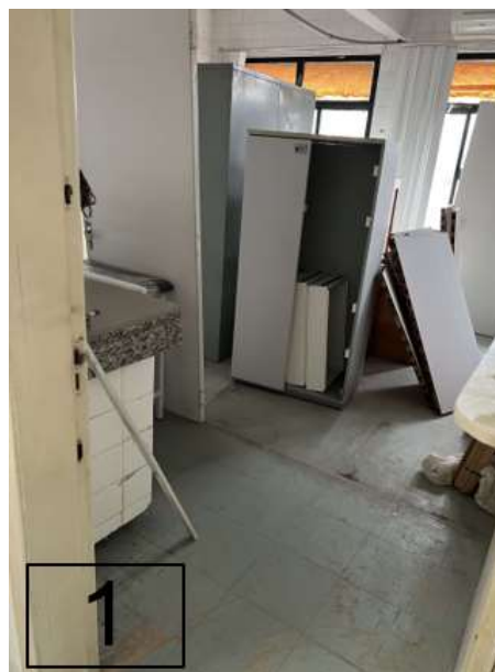
Sala em frente às escadas, à direita – piso vinílico
