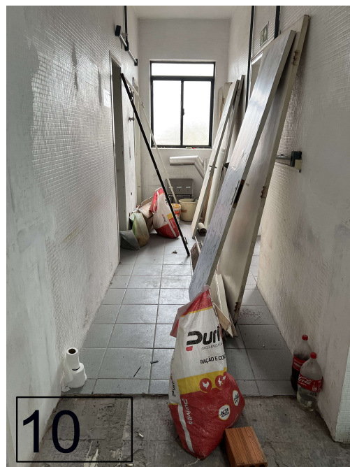
Corredor de acesso aos banheiros à esquerda – piso cerâmico
