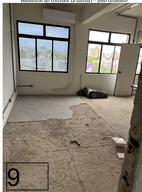
Sala maior à direita – piso parcialmente removido
