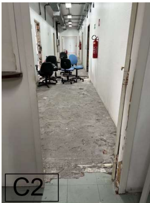
Corredor de acesso, após porta principal – piso já removido
