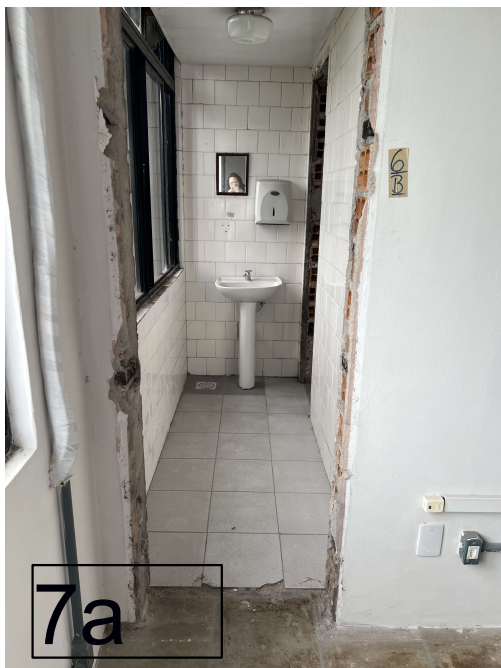
Banheiro da sala maior à direita – piso cerâmico
