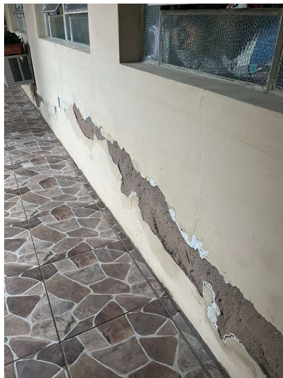
Parede área externa dos alojamento CO
