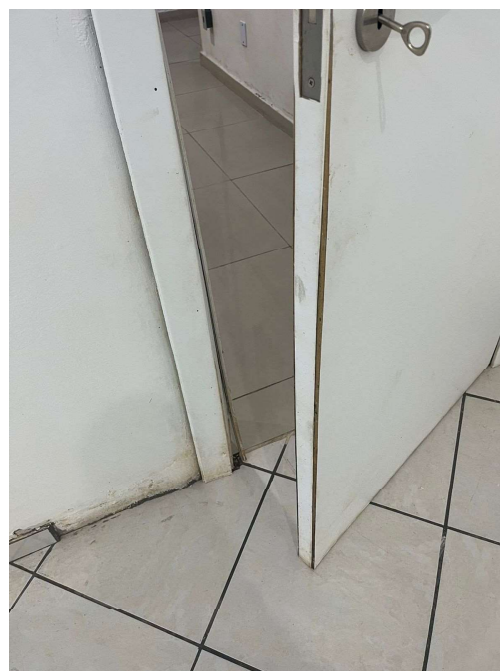
Aberturas áreas internas do prédio do CO
