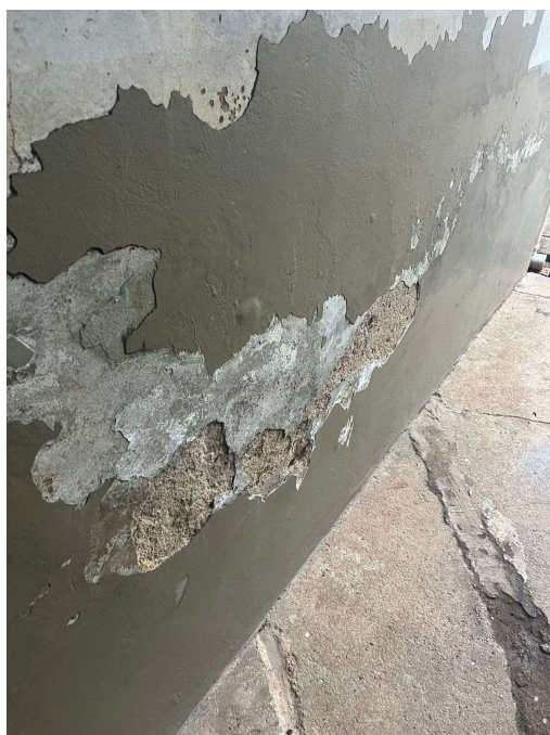
Parede Externo entrada do CO
