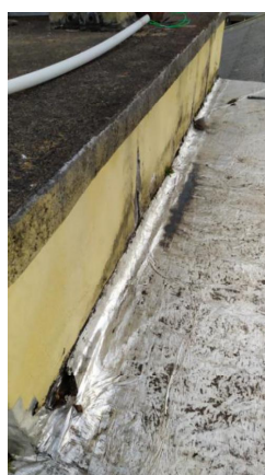
Imagem 10 – Laje da Casa de Máquina (sistema de impermeabilização ineficiente)
