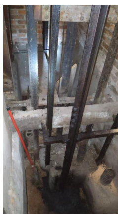
Imagem 17 – Poço do elevador
