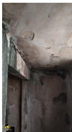
Imagem 4 – Laje de cobertura ( Casa de Máquina)
