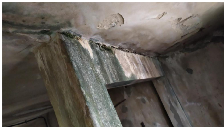
Imagem 6 – Viga (Casa de Máquina)
