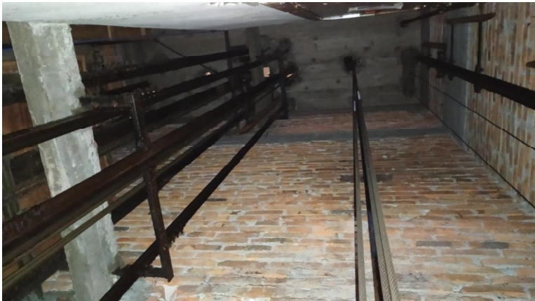
Imagem 15 – Alvenaria e vigas intermediárias da caixa de corrida
