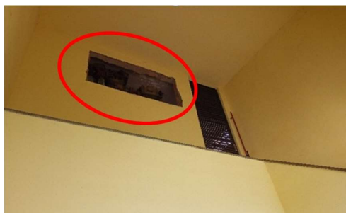
Fotografia 24 Vão de janela 01 (interna) da casa de máquinas
