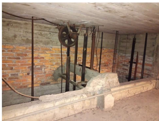
Fotografia 13 Topo da caixa de corrida com visualização da laje de cobertura do prédio e laje de teto das caixas de corrida
