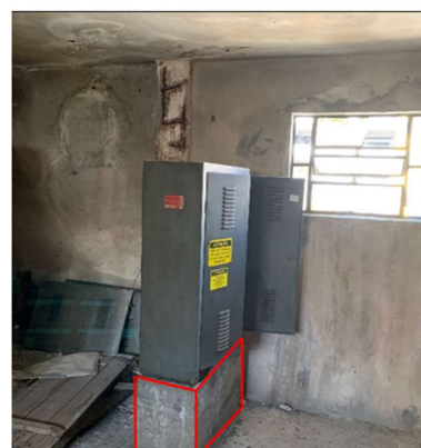
Fotografia 28 Bases de concreto a serem demolidas
