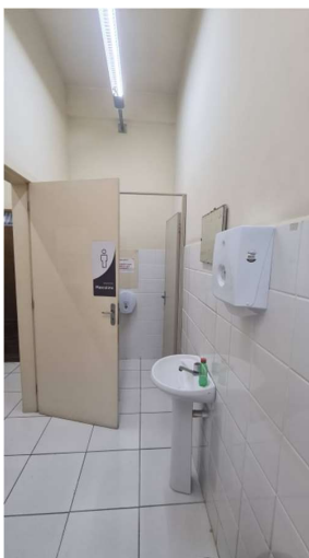
Fotografia 16 Sanitário com pintura acima dos azulejos e portas em tom de bege.
