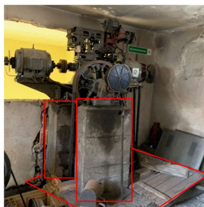
Fotografia 27 Bases de concreto a serem demolidas
