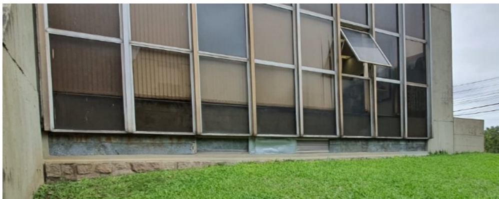
Imagem 03: Situação da fachada oeste
