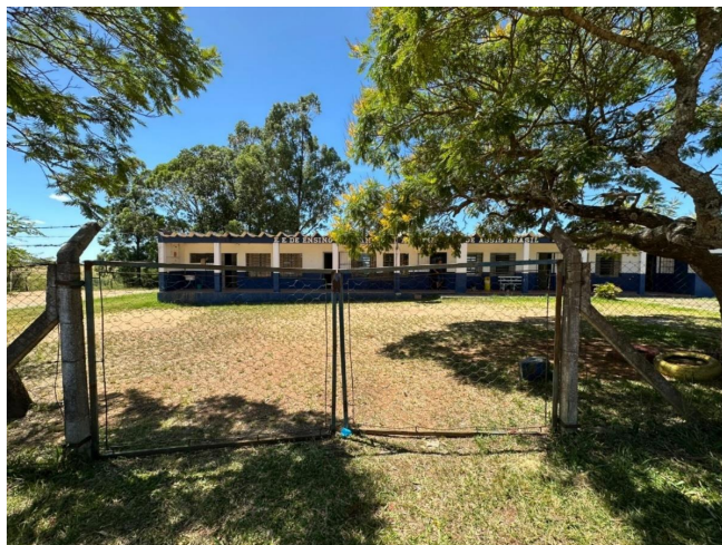
Foto 02: Fachada das salas de aula.
