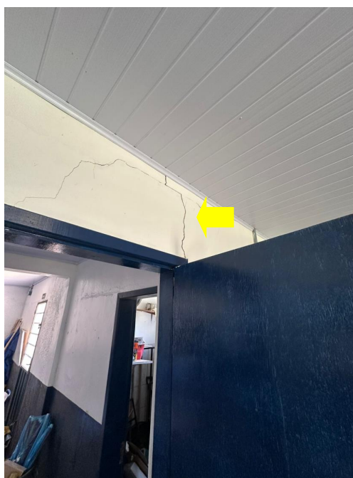
Foto 07: Sala de aula 01 (interna).
