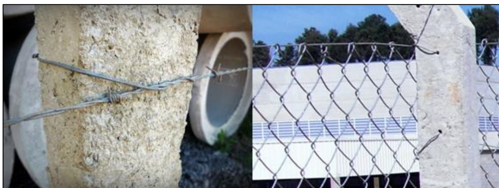
Figura 7 - Detalhamento fixação da tela
