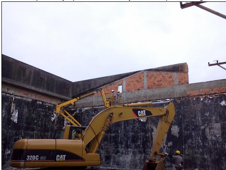
Foto 15 – Escavadeira rompendo estrutura de concreto armado.
