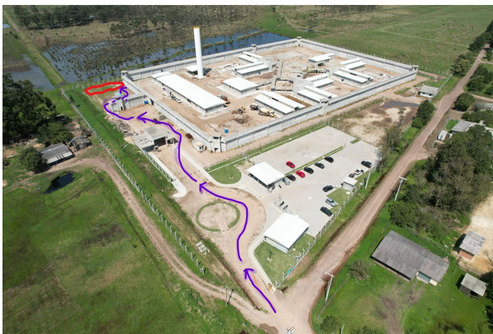
Foto aérea do local - Contorno em vermelho marca a área de intervenção e as setas roxas indicam o percurso de acesso das máquinas
