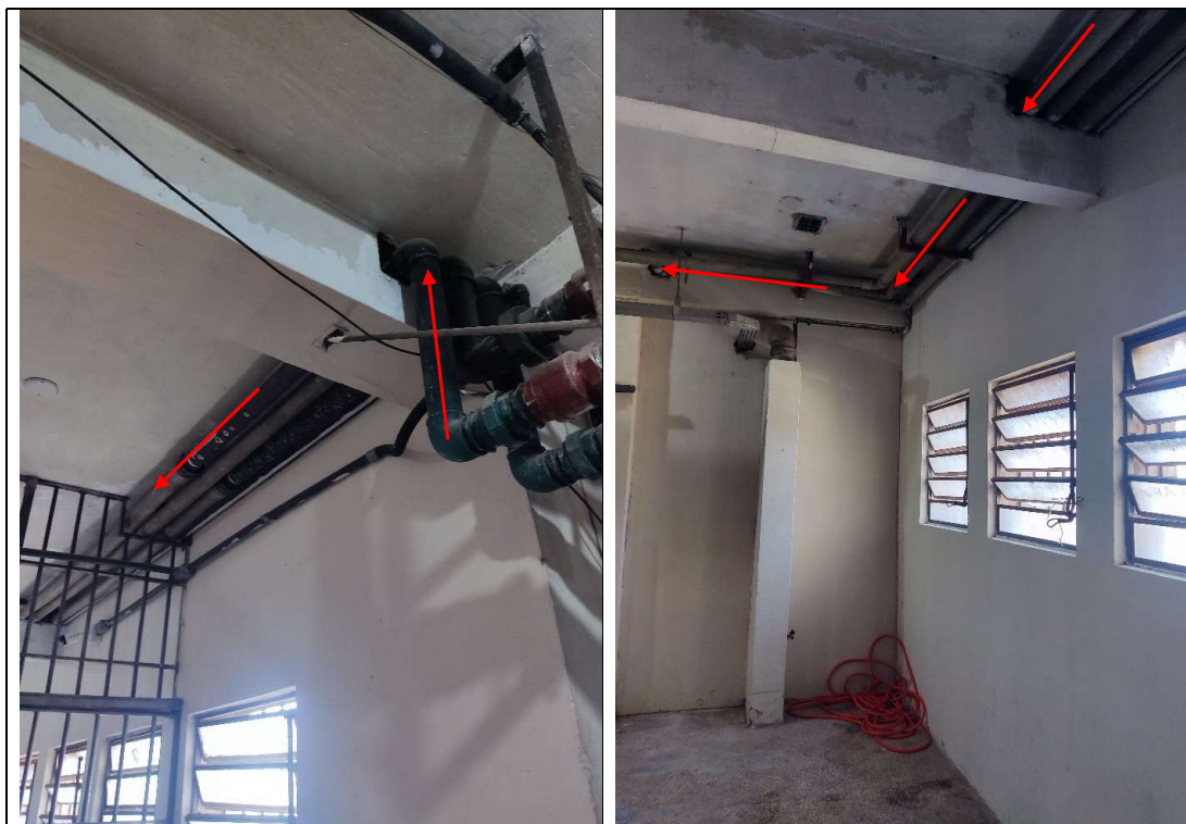
Figura 13 - Detalhe das passagens através de vigas das tubulações antigas assim que saia do boiler(figura a esquerda) atravessando a primeira grade da ala para então adentrar no espaço entre as duas grades de acesso as alas.
