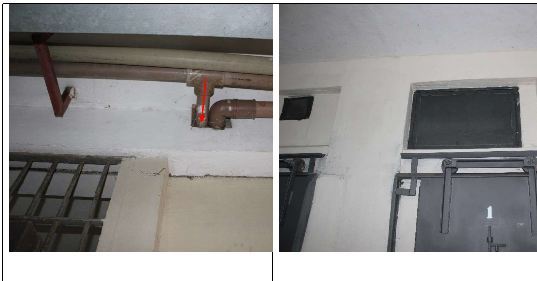
Figura 14 - Detalhe da entrada das tubulações de água para dentro dos shafts das celas. Na foto a direita imagem da portinhola de acesso dos shafts por onde a instalação deverá ser realizada.
