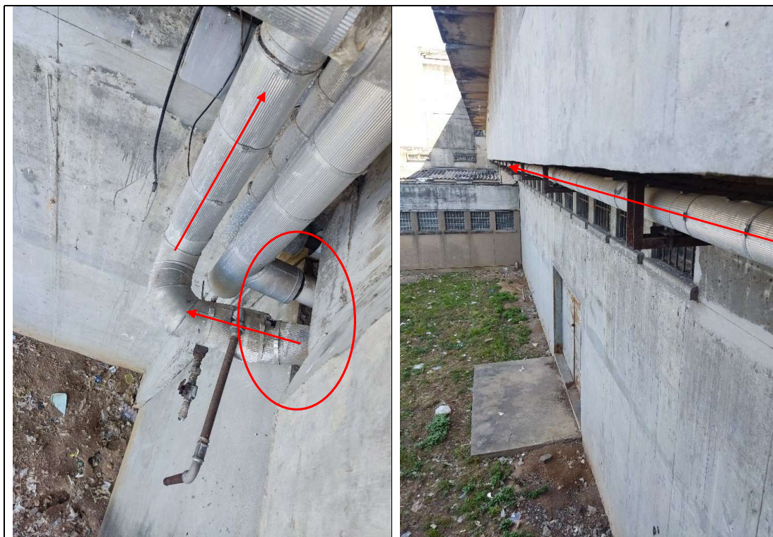
Figura 6 - Trecho da tubulação de vapor que vem do patio de abastecimento através do muro(circulado em vermelho) e sobe para seguir por trecho afixado à laje do segundo pavimento do pavilhão C(primeiro pavimento com celas). Detalhe para a fixação através de estruturas metálicas na laje do piso do primeiro pavimento de celas
