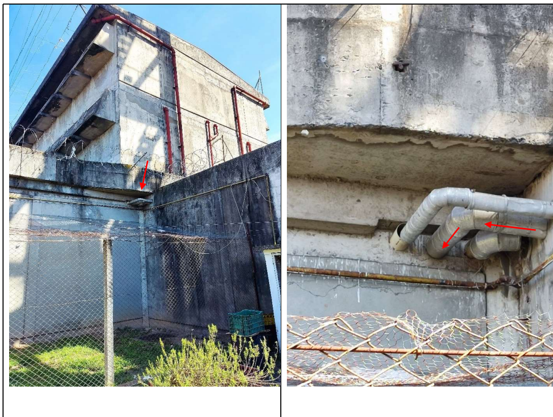
Figura 5 - Trecho da tubulação de vapor que adentra o pátio abastecimento e em curva de ângulo reto acesso o pátio da penitenciária que comunica com o pátio abastecimento.
