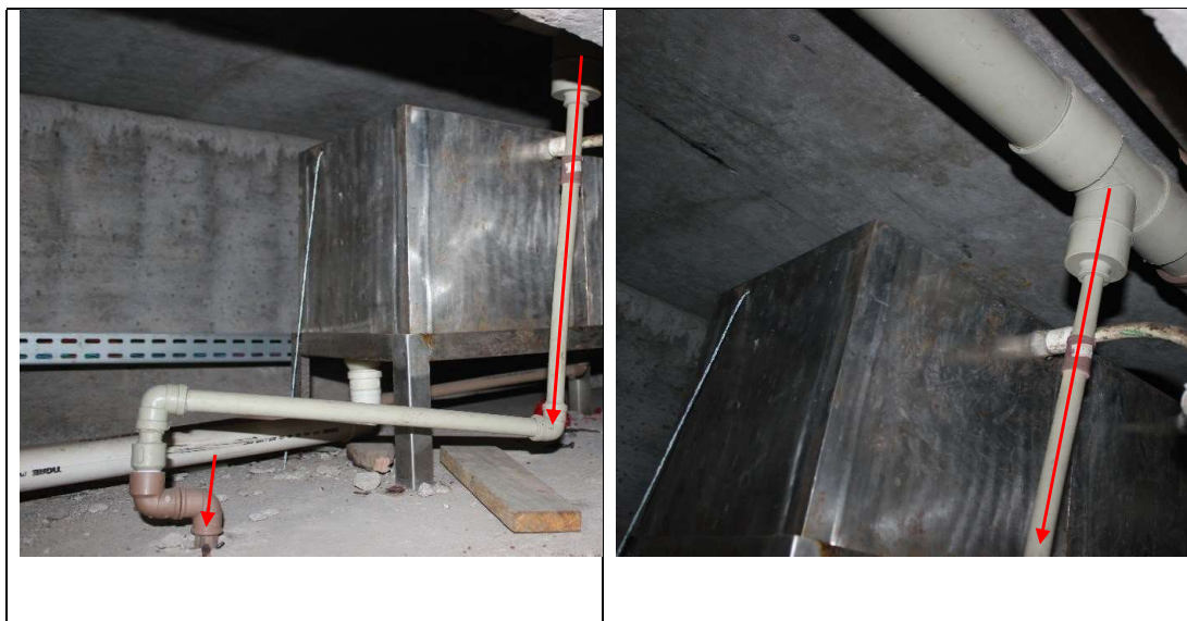
Figura 15 - Detalhe do ramal de descida de água para o chuveiro da cela na figura a esquerda e ramal principal de abastecimento na figura a direita,
