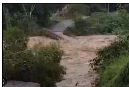
Fig. 4: Imagens da ponte de concreto sobre o arroio Não Sabia, em 01/05/2024.
