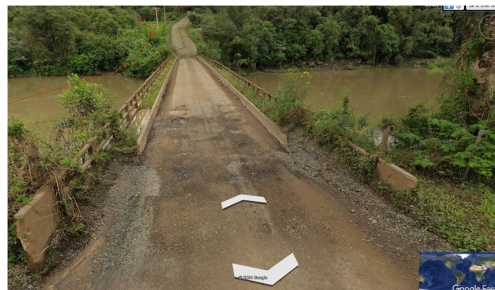
Fig. 2: Vistas frontal da ponte na ERS-441, com extensão original de 53,50m antes do sinistro
