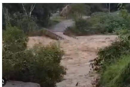
Fig. 3: Imagem da ponte de concreto sobre o rio Não Sabia, em 01/05/2024.
