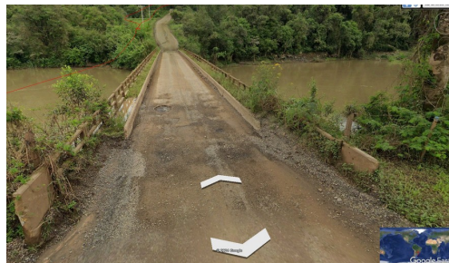
Fig. 2: Vista frontal da ponte na ERS-441, com extensão original de 53,50m antes do sinistro
