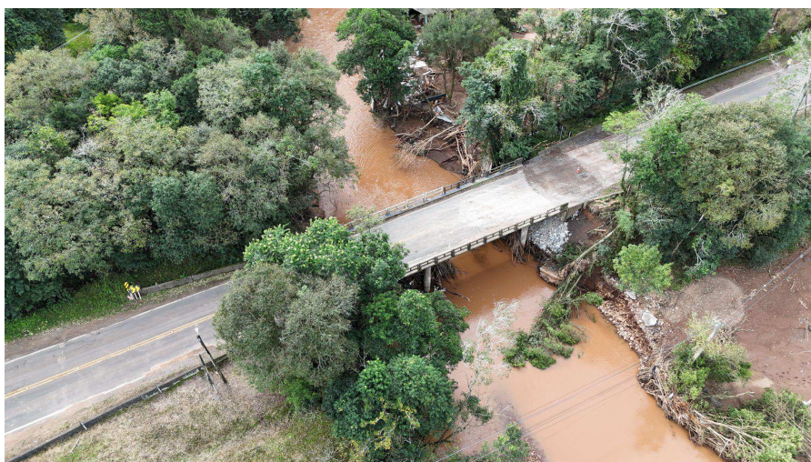
Figura 6: Ponte sobre o Arroio Pinhal
