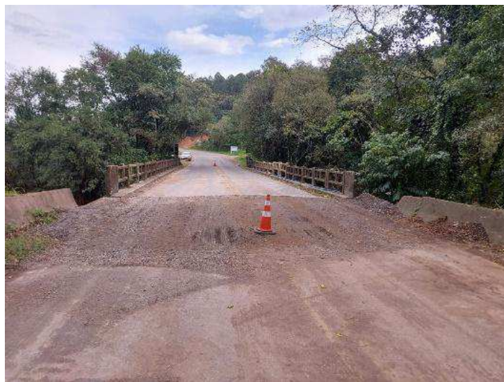
Figura 5: Cabeceira da Ponte sobre o Arroio Pinhal
