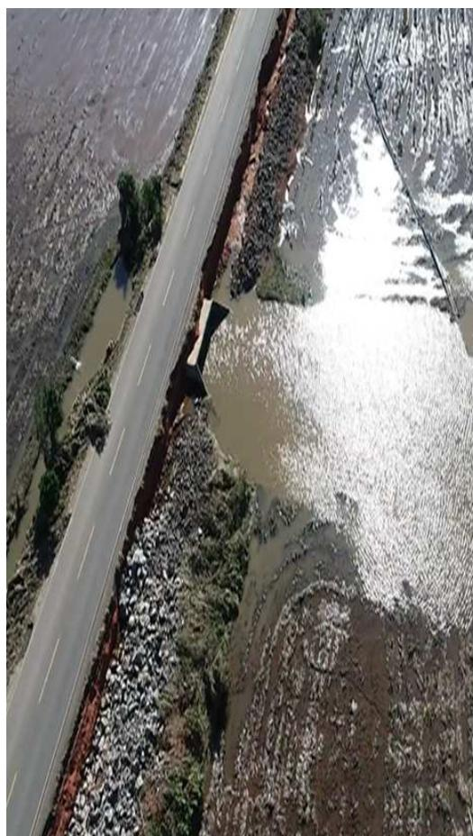
**Figura 5: Colapso da saia do aterro - km 39+300**
