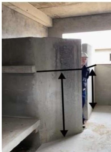
*Figura 1 – marcação do trecho de paredes a serem rebaixadas*
