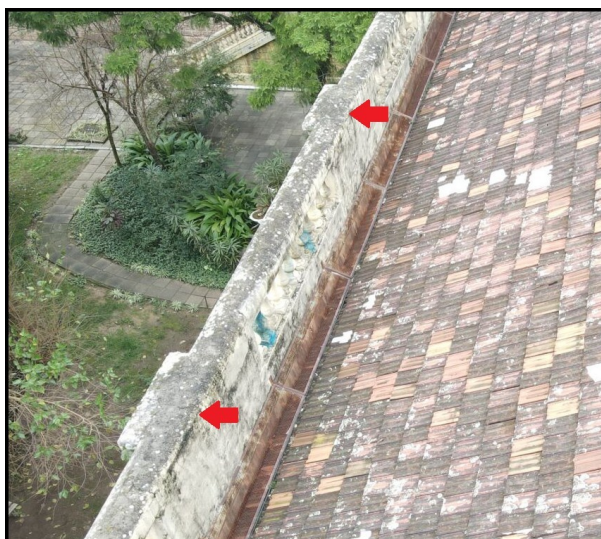
Fig. 02 - Vigas e Balaústres (Telhado Prédio 2)
