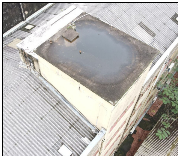
Fig. 03 - Casa de Máquinas (Telhado Prédio 3)
