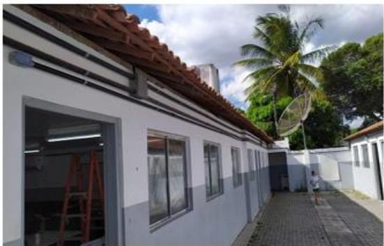
Foto XX - Infraestrutura de eletroduto fixada nas paredes externas
