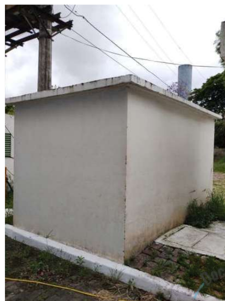
Foto 04 – Cabine sul – Fachada oeste e sul
