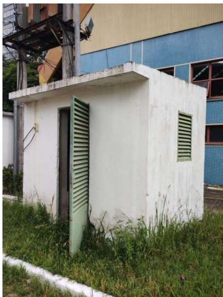
Foto 01 – Cabine norte – Fachada leste e norte
