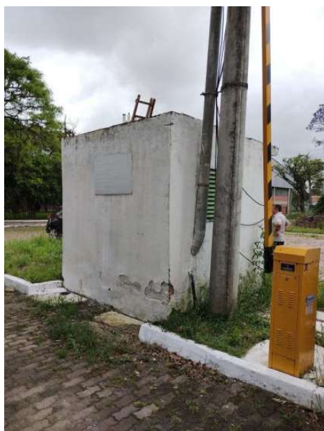
Foto 03 – Cabine norte – Fachada oeste e sul
