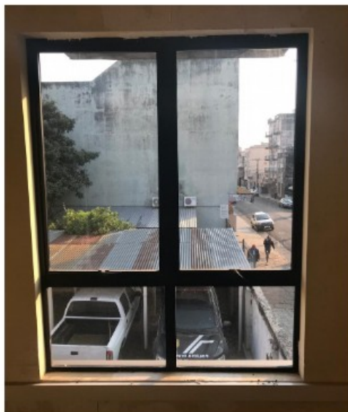
Imagem 03 – Imagem de uma das janelas onde deverão se instaladas as persianas medindo: 1,46x1,65 (total 08 janelas com estas dimensões de persianas)
