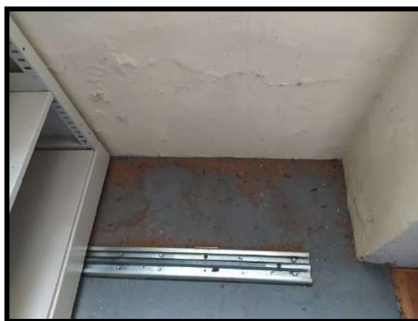
Figura 129: Indícios de umidade ascensional e lateral - assim como a presença de insetos xilófagos sobre esquadrias (arquivo da BM).
