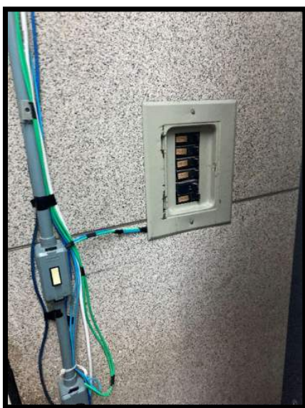
Figura 81: Fiação aparente e CD sem tampa de fechamento (departamento de informática).
