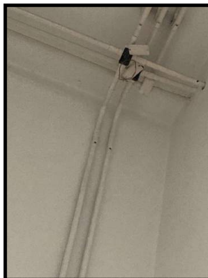
Figura 127: Fiação aparente.
