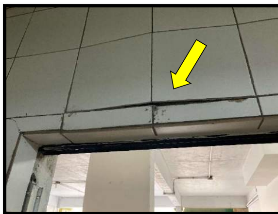
Figura 5: Falta de aderência entre os azulejos e o substrato (Alojamento dos Oficiais).
