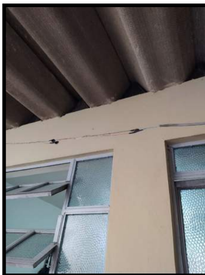
Figura 135: fachada do recinto da empresa terceirizada (serviço de higienização) – presença de cabeamento não tubulado e emendas irregulares.
