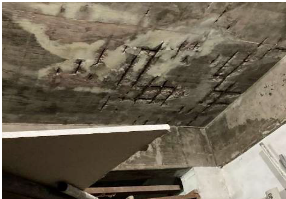
Armaduras longitudinais das lajes estão expostas e apresentando indícios de oxidação, corrosão, bem como umidade.
