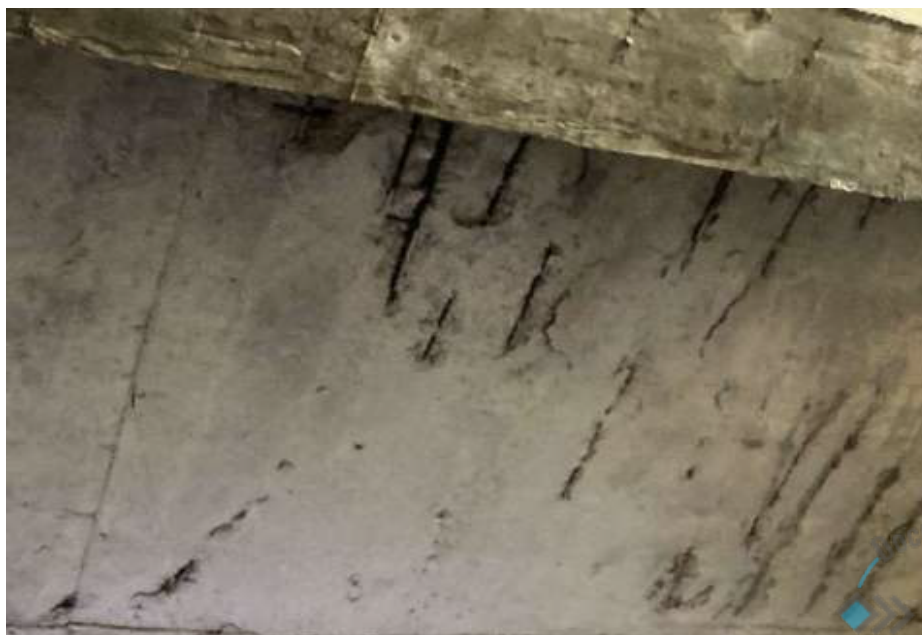
Armaduras expostas com indícios massivos de corrosão, infiltrações e umidade por condensação (depósito de materiais).
