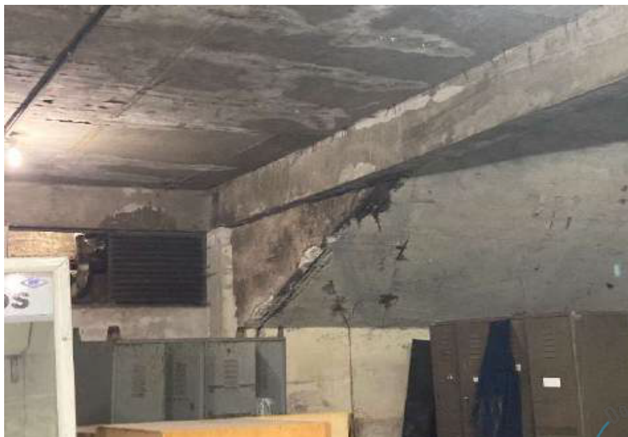
Armaduras longitudinais das lajes estão expostas e apresentando indícios de oxidação, corrosão, bem como umidade.
