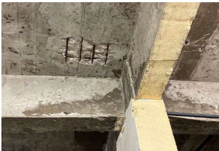
Armaduras expostas com indícios massivos de corrosão, infiltrações e umidade por condensação (depósito de materiais).
