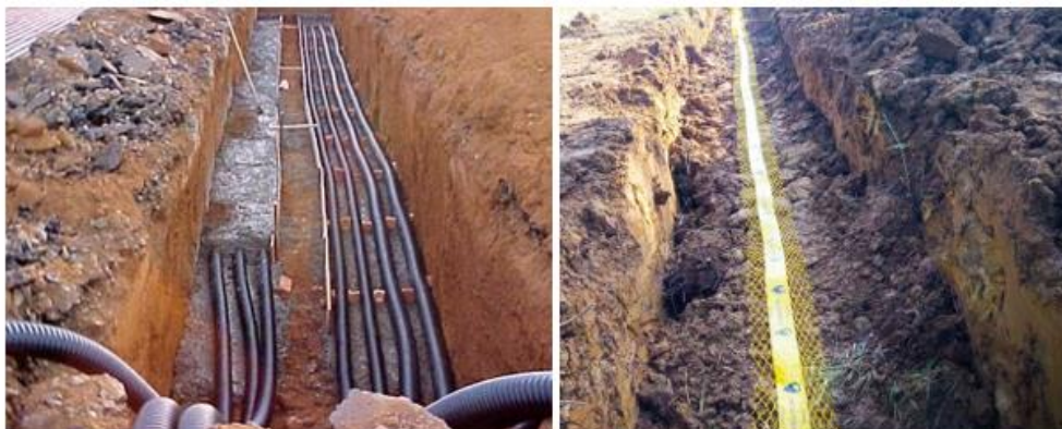
Figura 6: Instalação eletroduto subterrâneo
