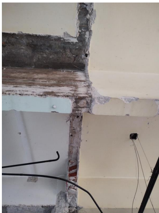
Foto 3d – Viga danificada 3 – Fissura provável armadura corroída
